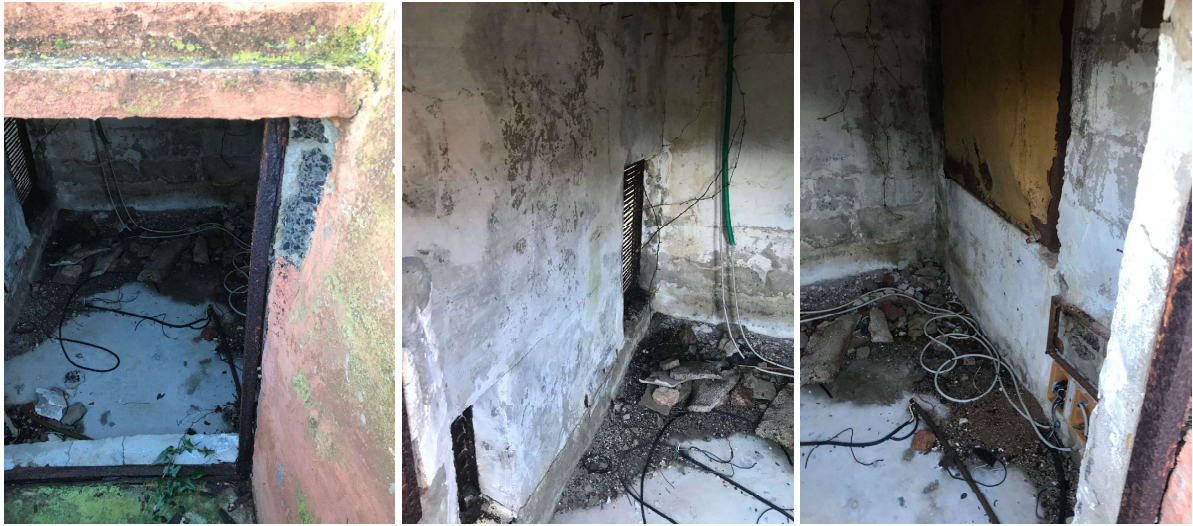
Restituzione grafica, con attestazione fotografica, della terrazza n. 2, alla quale si accede dal prospetto laterale dell'edificio.
