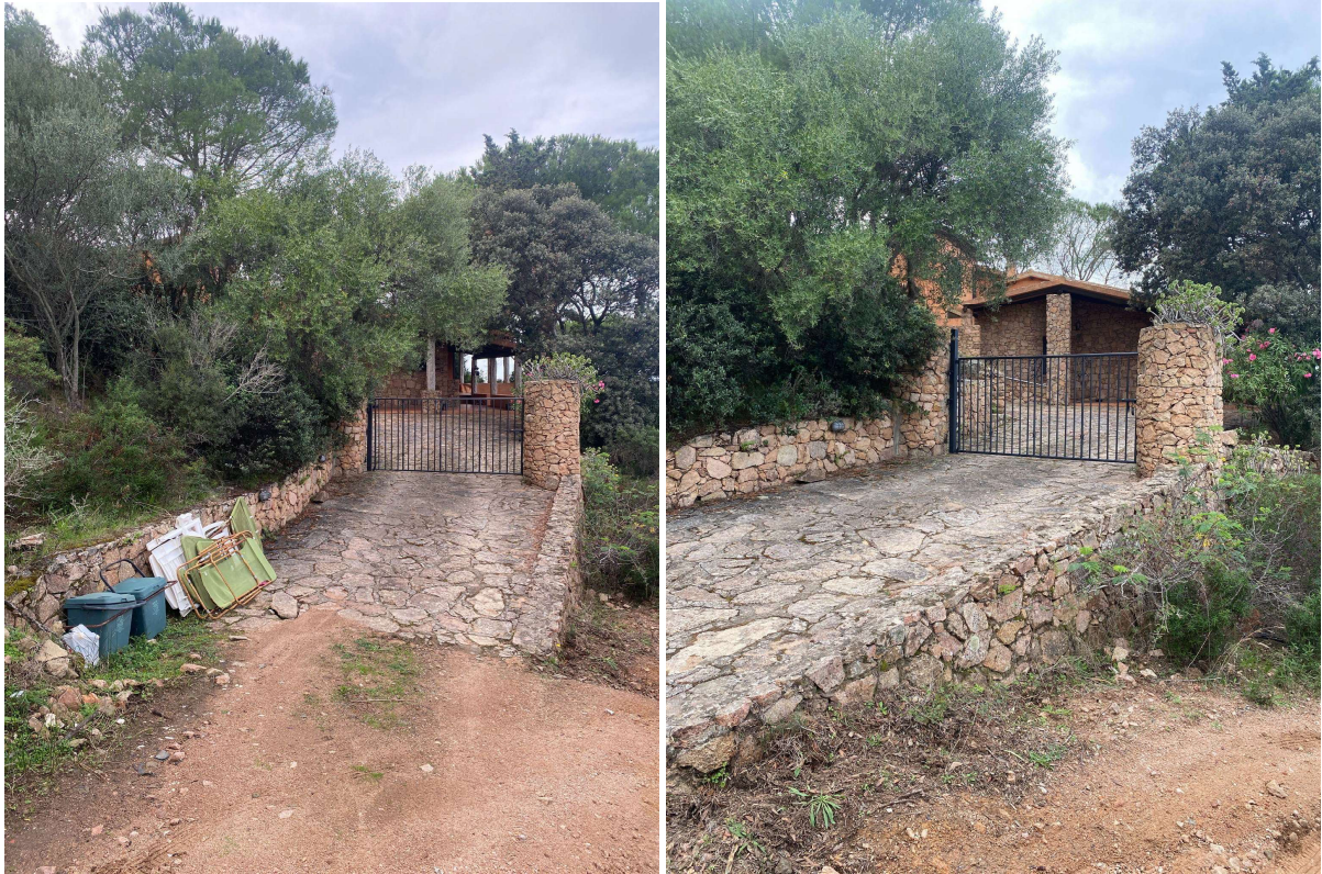
Attestazione fotografica della rampa che garantisce l'accesso agli immobili, ricadente su un lotto non di proprietà degli esecutati.
