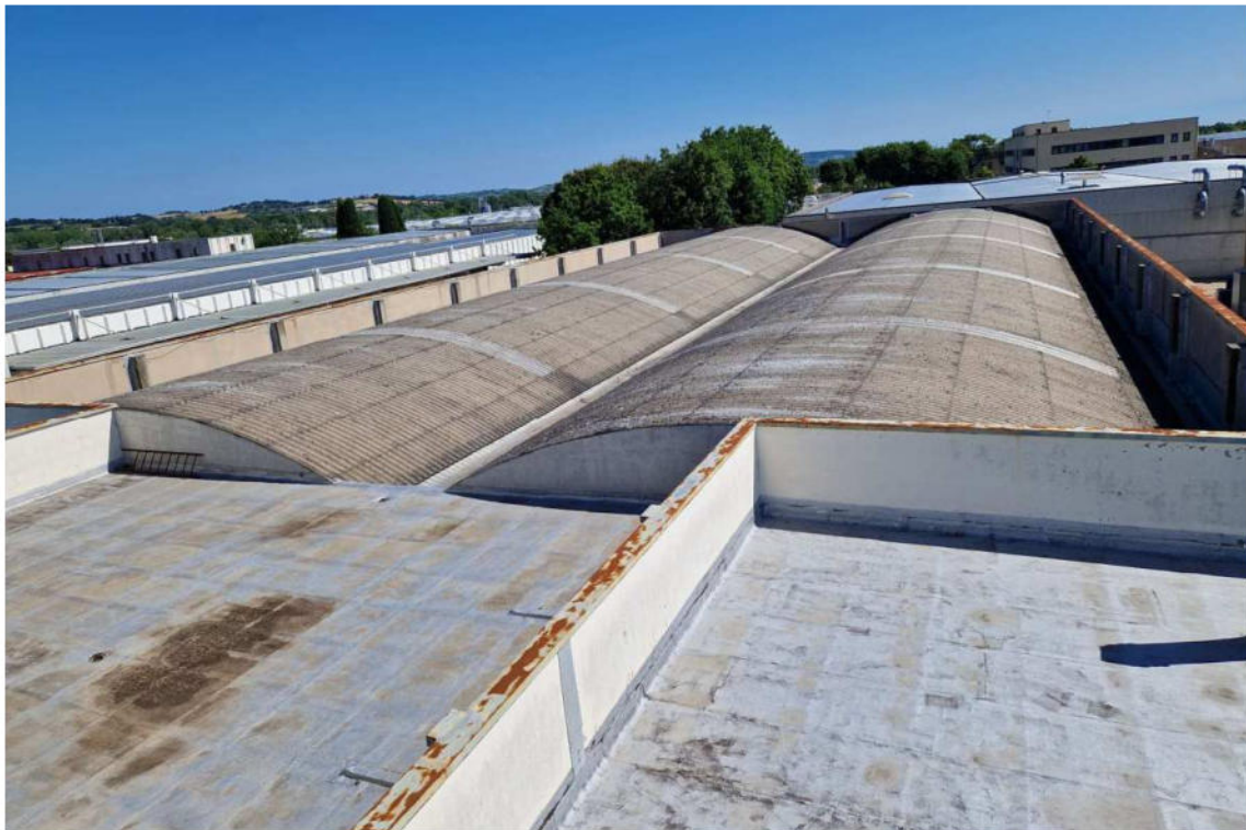
Fotografia n° 6 Lotto 1 – corpo A – Coperture fabbricato
