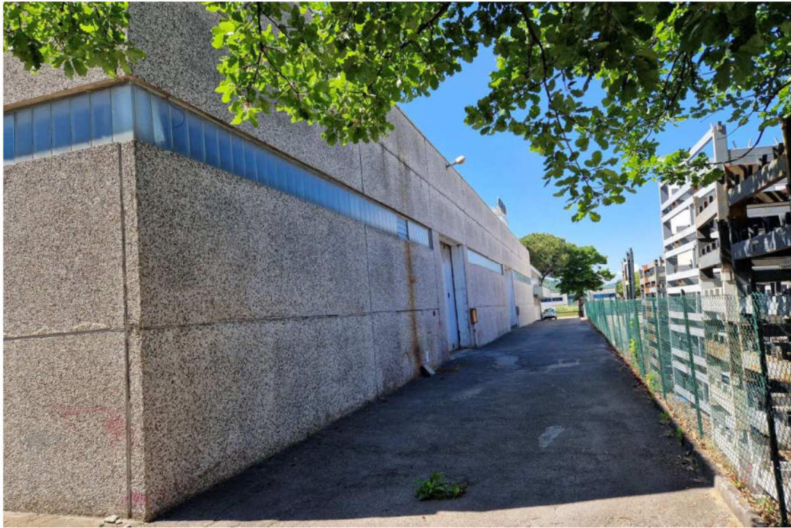
Fotografia n° 5 Lotto 1 – corpo A – Fianco fabbricato
