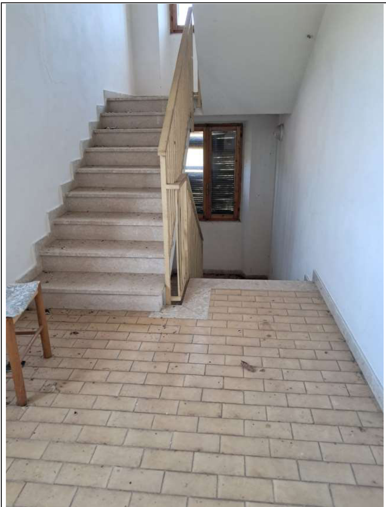
CORRIDOIO CONDOMINIALE P.1°
