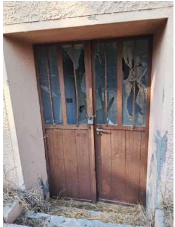
ACCESSO CONDOMINIALE ALLE CANTINE
