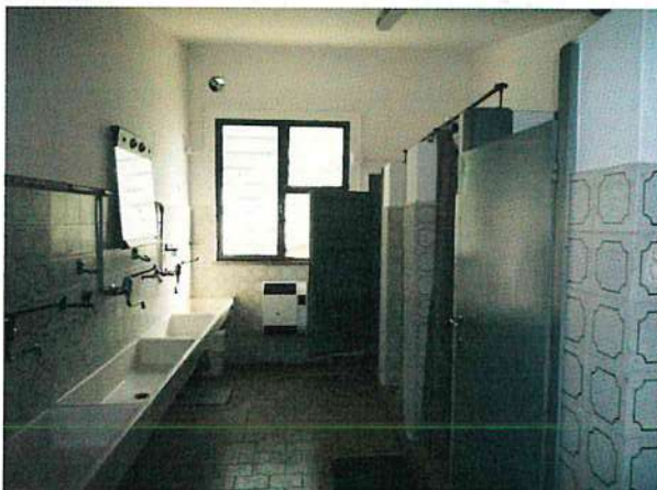
FOTO 15 – INTERNO SPOGLIATOI CORPO 5
