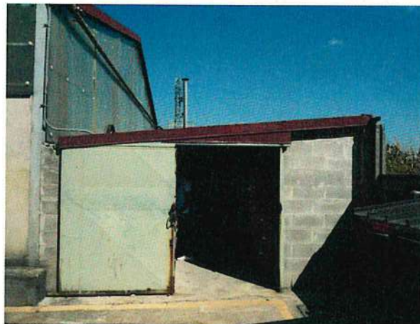
FOTO 22 – CORPO 7 FRONTE SUD
