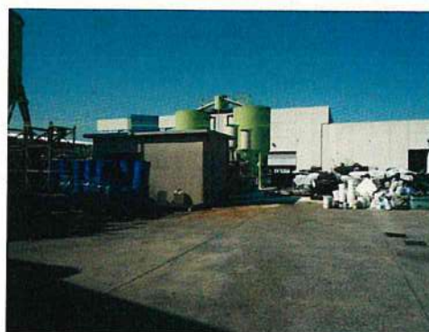
FOTO 34 – CORPO 10 FRONTE EST
