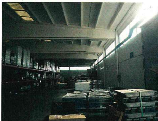
FOTO 2 – INTERNO CAPANNONE CORPO 1
