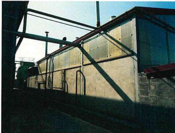
FOTO 11 – CORPO 4 FRONTE SUD
