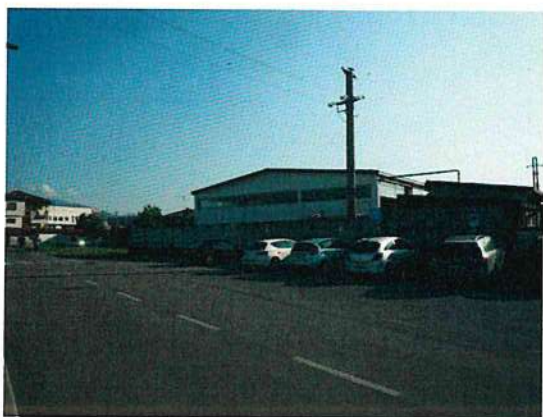
PALO IN CEMENTO FOTO A
