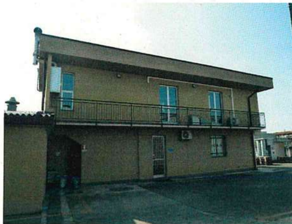
FOTO 41 – CORPO 13 FRONTE EST
