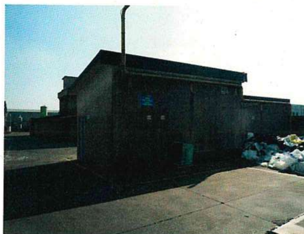
FOTO 45 – CORPO 14 FRONTE NORD
