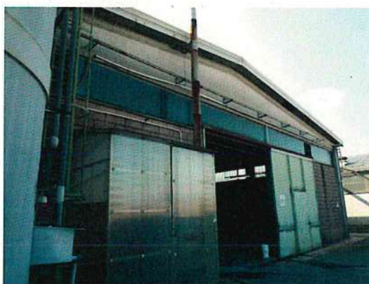
FOTO 26 – CORPO 8 FRONTE EST
