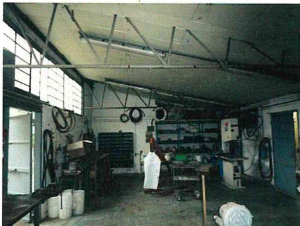
FOTO 17 - INTERNO OFFICINA CORPO 5
