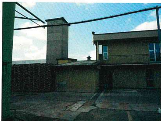
FOTO 38 – CORPO 12 FRONTE EST
