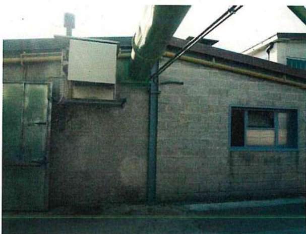
FOTO 3 – CORPO 2 FRONTE EST
