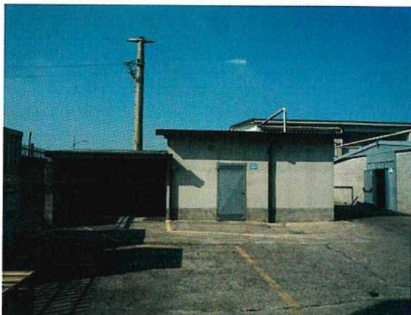
FOTO 44 – CORPO 14 FRONTE SUD
