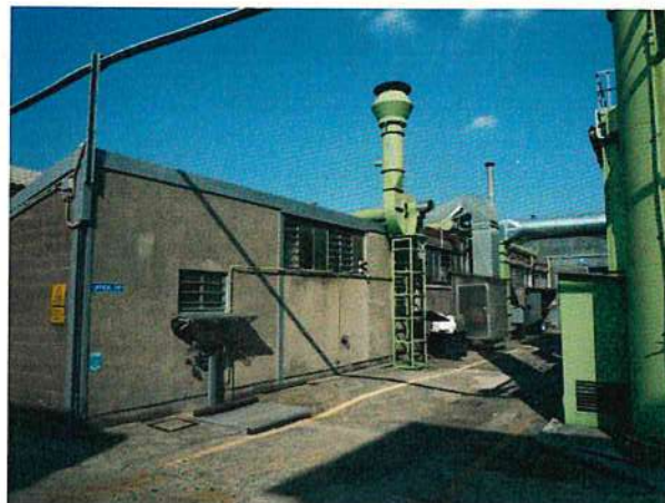
FOTO 14 – CORPO 5- FRONTE SUD
