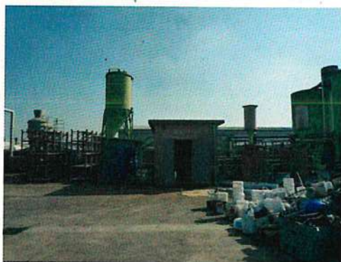
FOTO 33 – CORPO 10 FRONTE NORD
