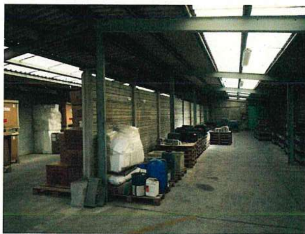
FOTO 4 - INTERNO CAPANNONE CORPO 2
