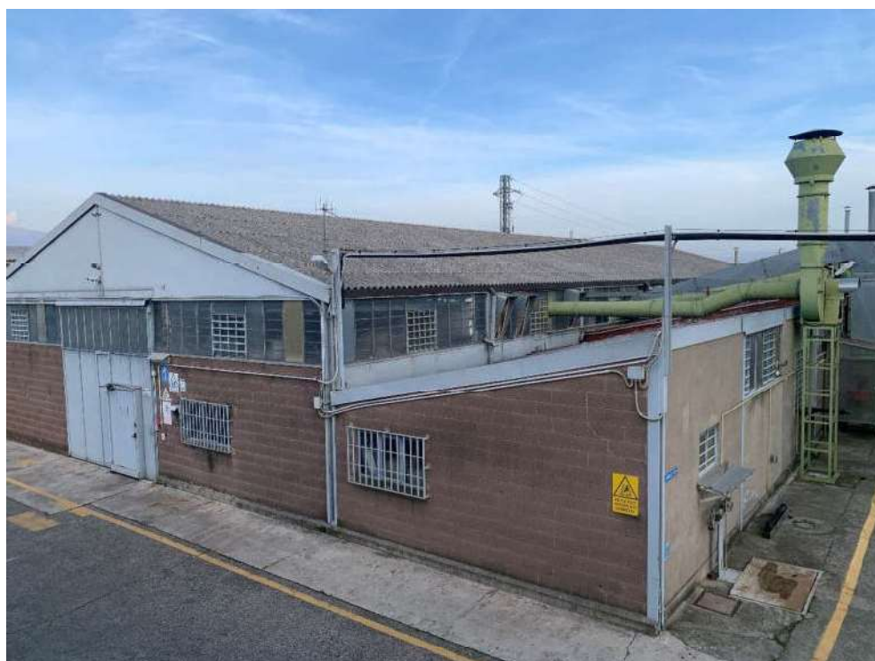
Fotografia 14: Vista "Edifici Centrali (assemblaggio)" dalla palazzina uffici
