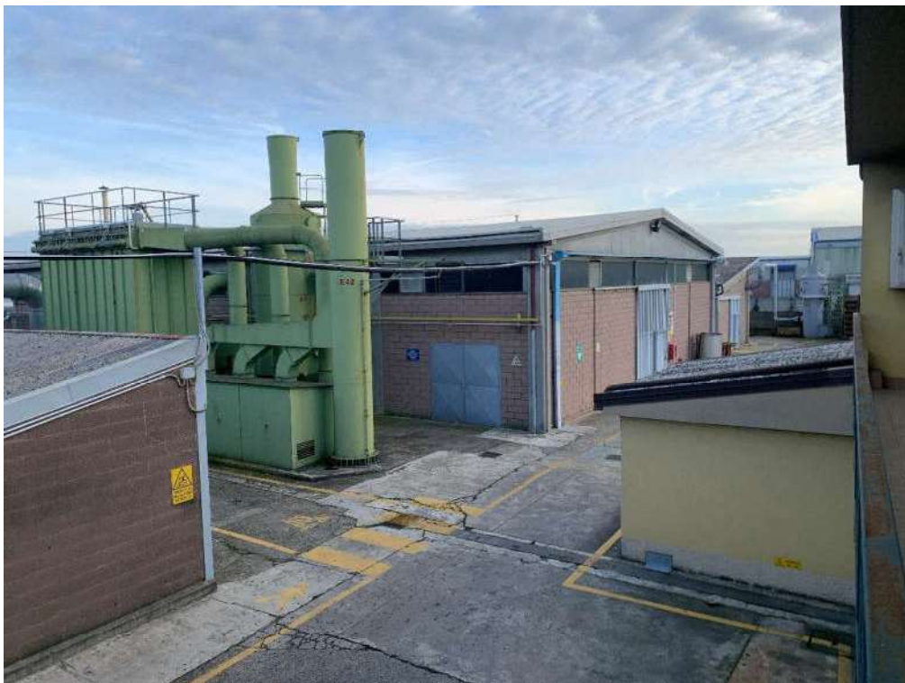
Fotografia 1: Vista "Edificio 2" dalla palazzina uffici
