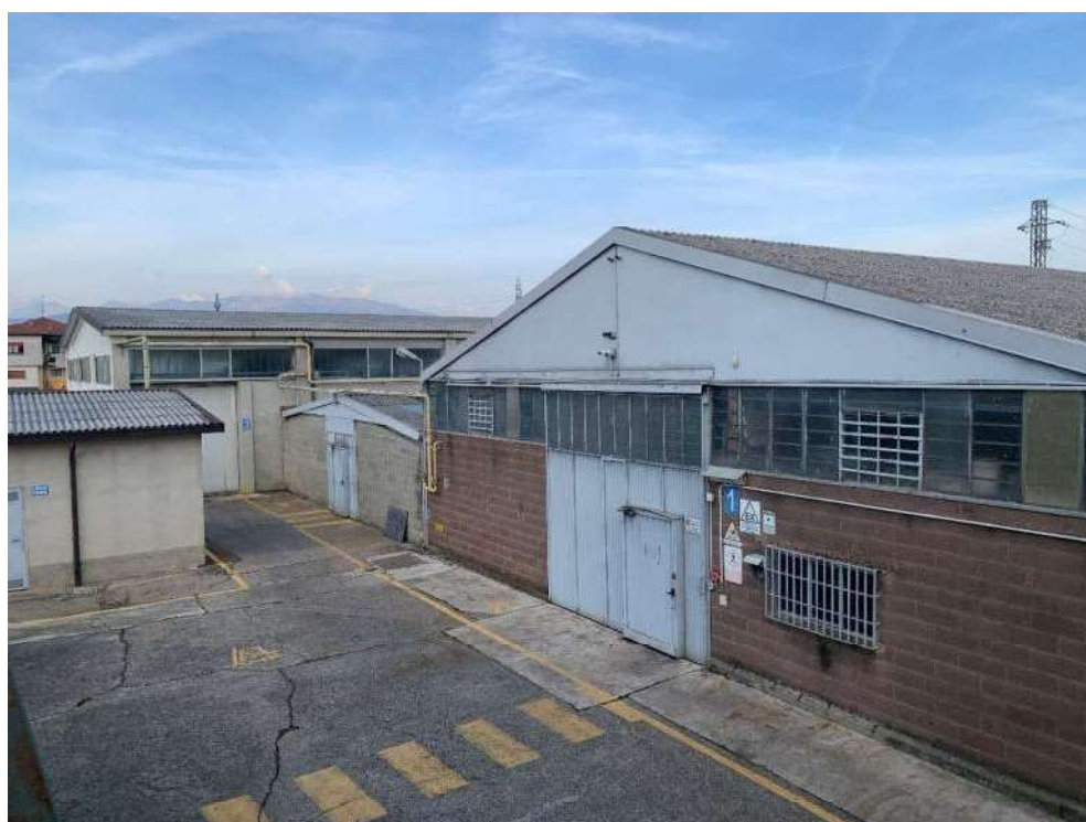
Fotografia 33 Vista "Edificio Nord" (magazzino) e da palazzina uffici
