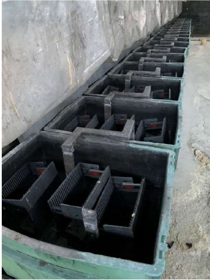
Fotografia 10: Vasche di carica di batterie/piastre
