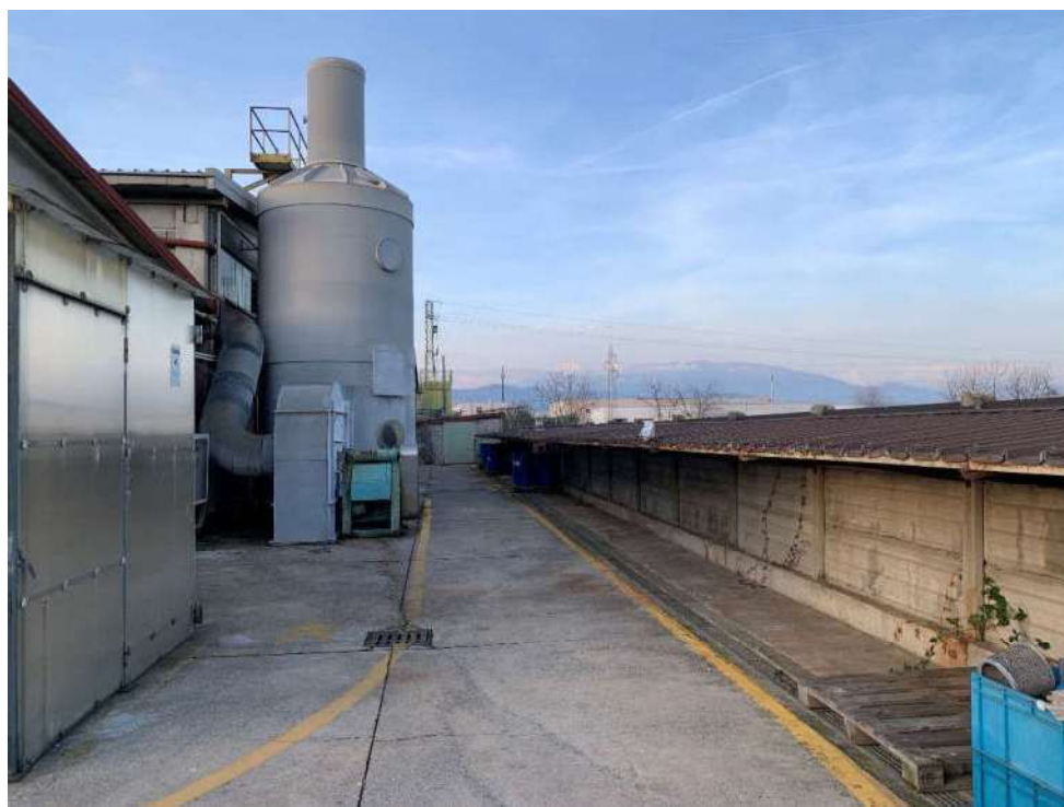
Fotografia 47: Scrubber a umido E6 e area per stoccaggio rifiuti
