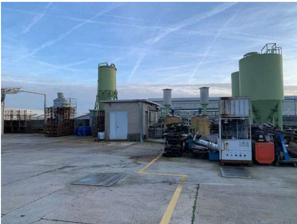
Fotografia 39: Silos calce viva, cabina comandi, trattamento e decantatori
