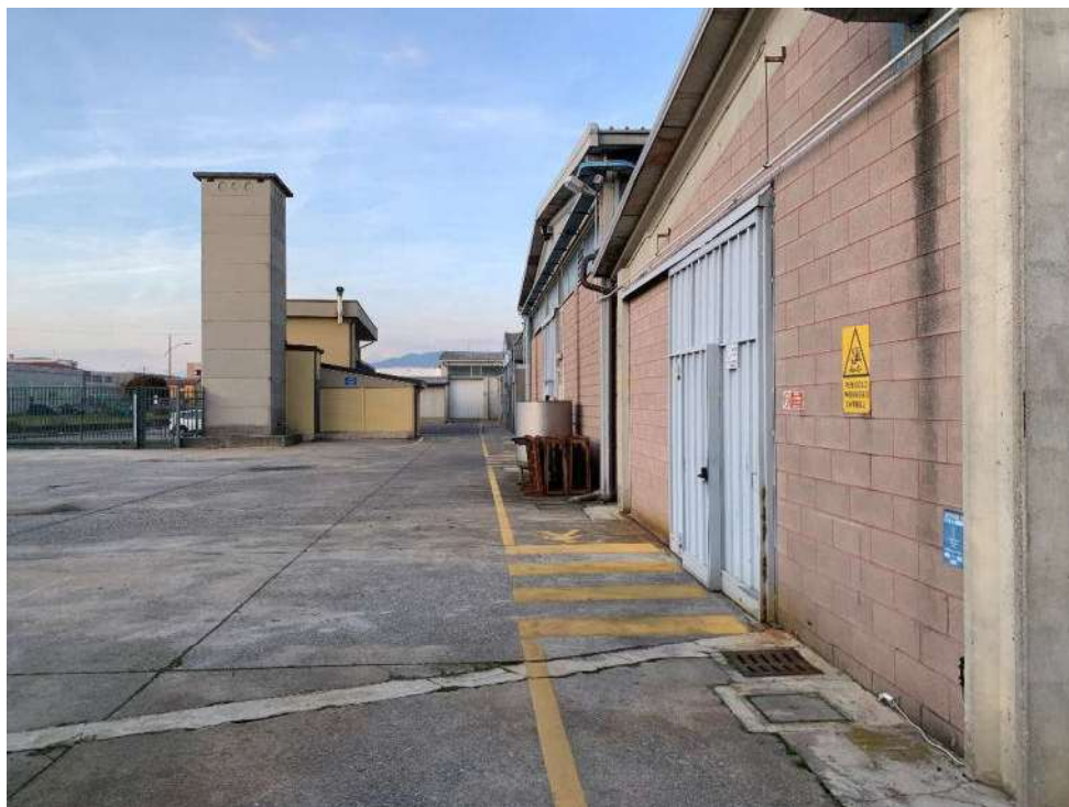
Fotografia 34: Palazzina uffici e cabina elettrica
