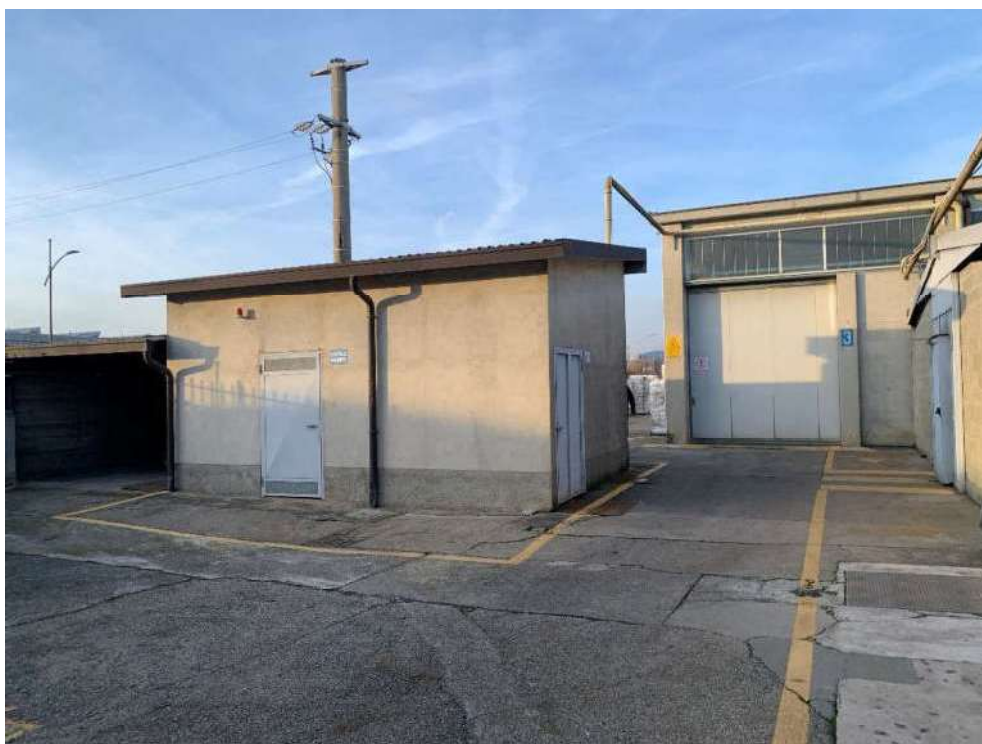
Fotografia 35: Locale pompe antincendio e autoclave
