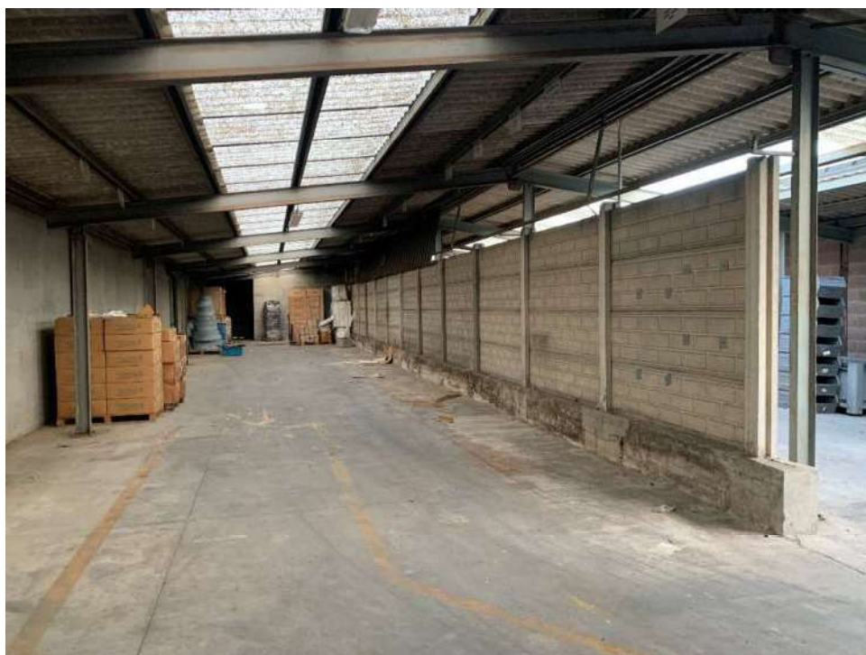
Fotografia 16: Interno del magazzino
