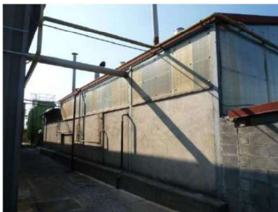
VEDUTA ESTERNA CORPO 4
