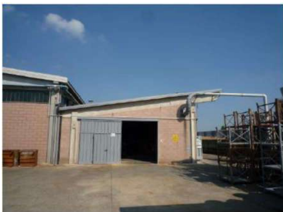
VEDUTA ESTERNA CORPO 9
