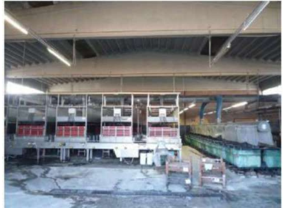
VEDUTA INTERNA CORPO 8
