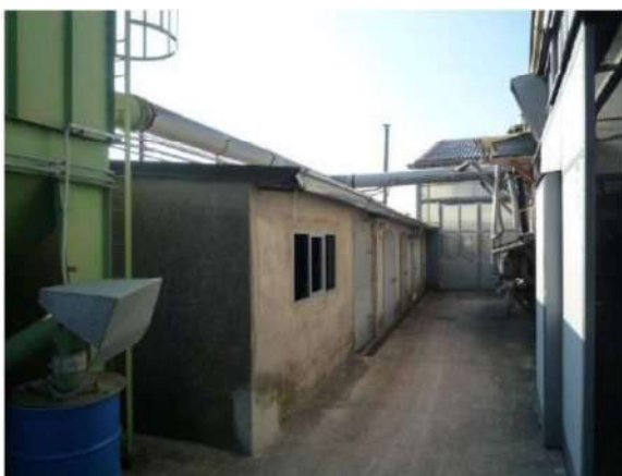
VEDUTA ESTERNA CORPO 7
