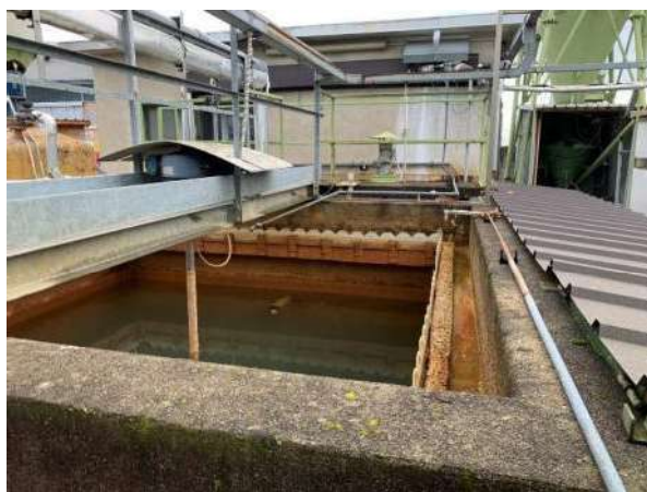
Vasche fuori terra da dismettere
