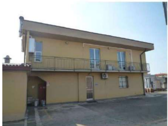
VEDUTA INTERNA CORPO 8
