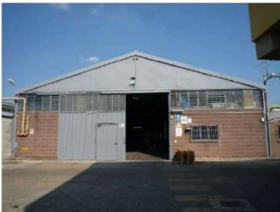
VEDUTA ESTERNA CORPO 3
