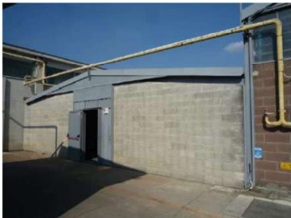
VEDUTA ESTERNA CORPO 2
