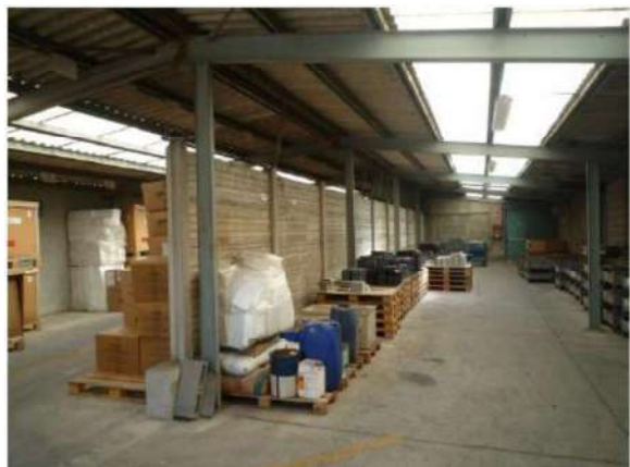
VEDUTA INTERNA CORPO 2
