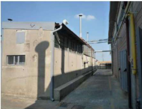
VEDUTA ESTERNA CORPO 6
