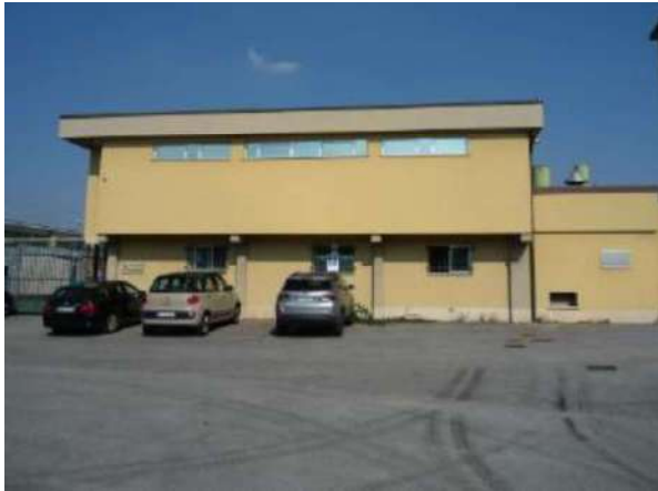
VEDUTA ESTERNA CORPO 13
