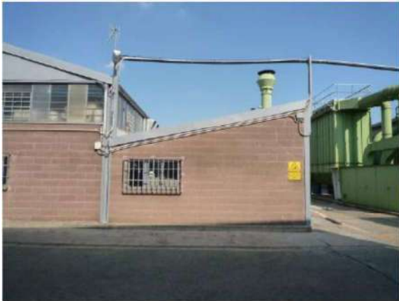
VEDUTA ESTERNA CORPO 5
