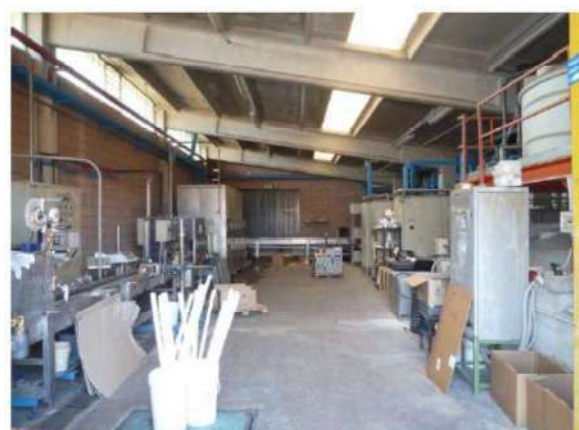
VEDUTA INTERNA CORPO 9
