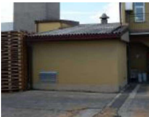
VEDUTA ESTERNA CORPO 12
