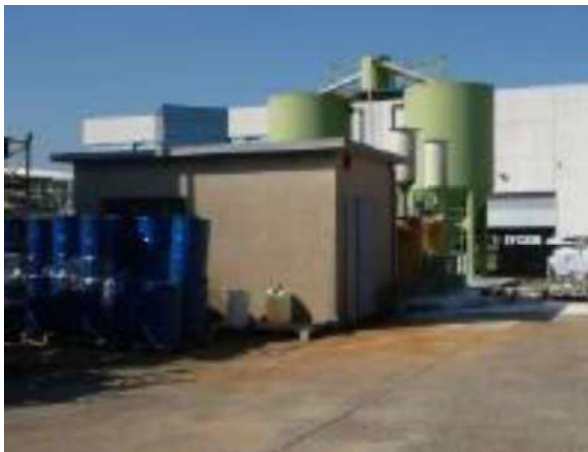
VEDUTA ESTERNA CORPO 10
