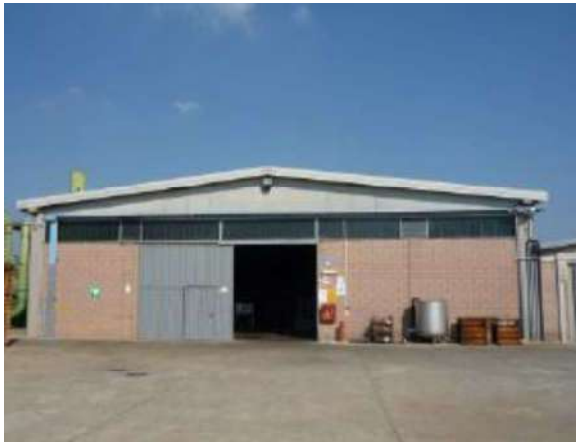
VEDUTA ESTERNA CORPO 8
