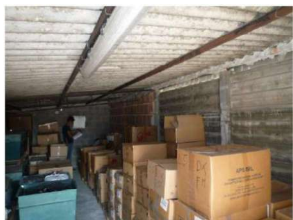
VEDUTA INTERNA CORPO 7
