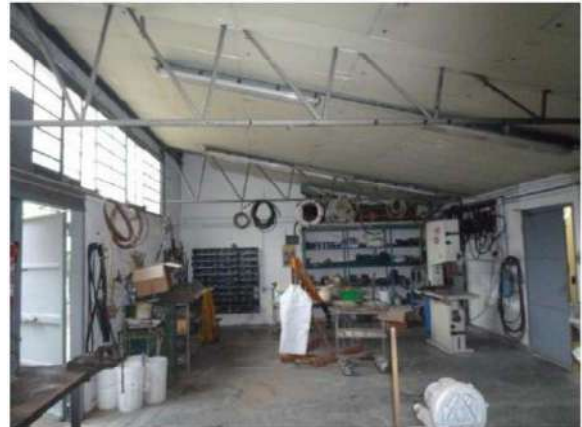
VEDUTA INTERNA CORPO 5
