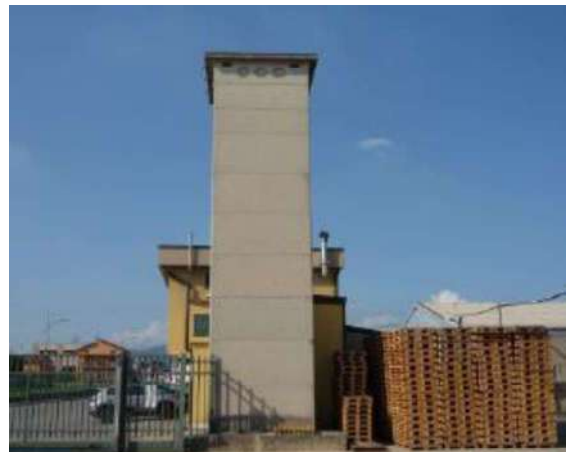
VEDUTA ESTERNA CORPO 11
