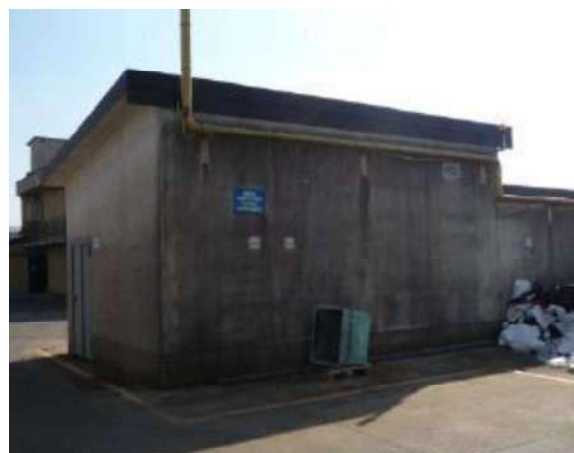
VEDUTA ESTERNA CORPO 14
