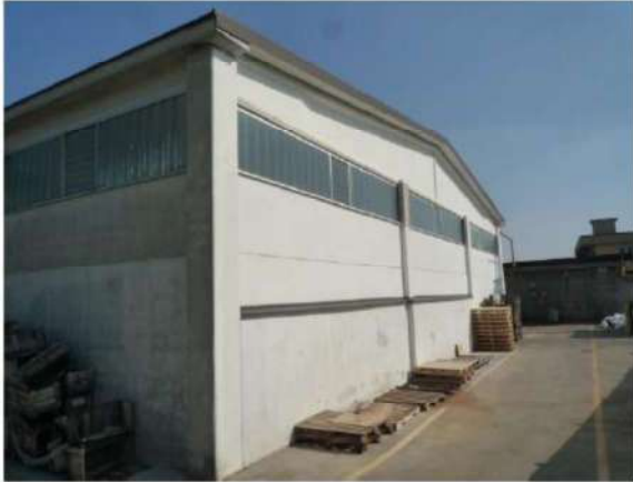
VEDUTA ESTERNA CORPO 1
