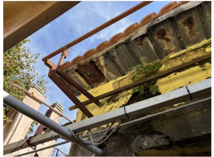
Particolare umidità di risalita, infiltrazioni e stato di degrado degli intonaci, delle tinteggiature esterne e delle pareti del Fabbricato lato Ovest
