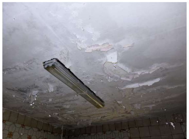
Particolare Impianto Elettrico e del soffitto ammalorato e danneggiato da infiltrazioni
