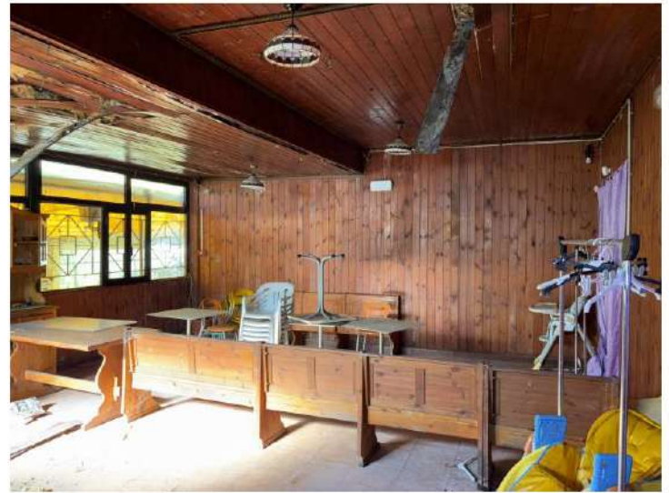
Sala Ristorante esterna esposta a sud-ovest con i controsoffitti e la copertura ammalorati e danneggiati da copiose infiltrazioni
