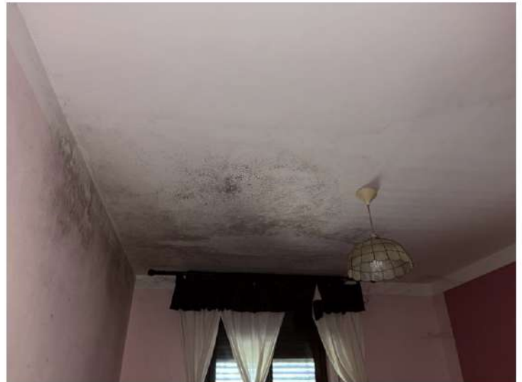
Vano Camera con presenza di evidenti infiltrazioni sul soffitto provenienti dalla copertura a tetto del fabbricato
