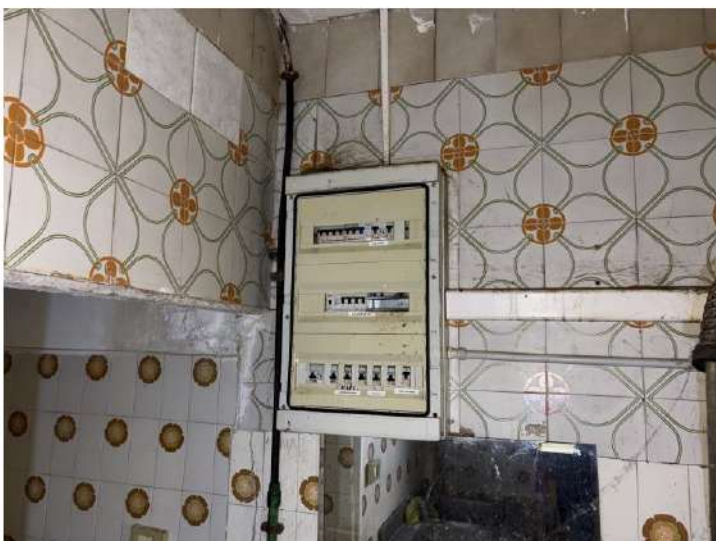
Particolare Impianto Elettrico e del soffitto ammalorato e danneggiato da infiltrazioni
