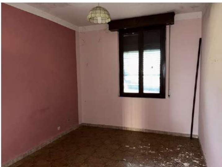
Vano Camera con presenza di evidenti infiltrazioni sul soffitto provenienti dalla copertura a tetto del fabbricato
