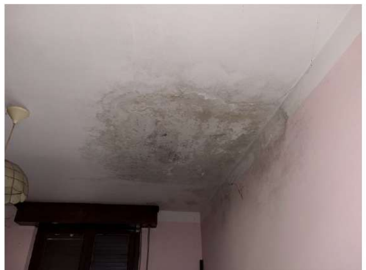
Vano Camera con presenza di evidenti infiltrazioni sul soffitto provenienti dalla copertura a tetto del fabbricato
