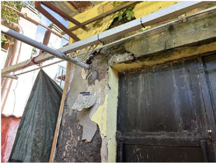
Particolare umidità di risalita, infiltrazioni e stato di degrado degli intonaci, delle tinteggiature esterne e delle pareti del Fabbricato lato Ovest
