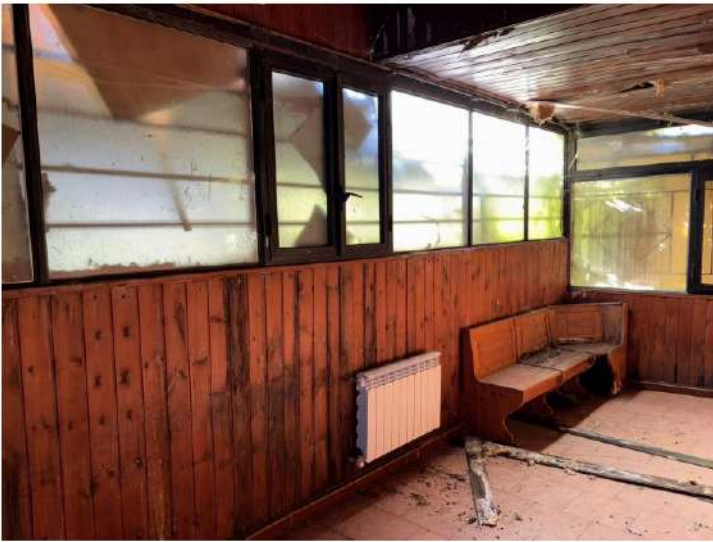
Sala Ristorante esterna esposta a sud-ovest con i controsoffitti e la copertura ammalorati e danneggiati da copiose infiltrazioni
