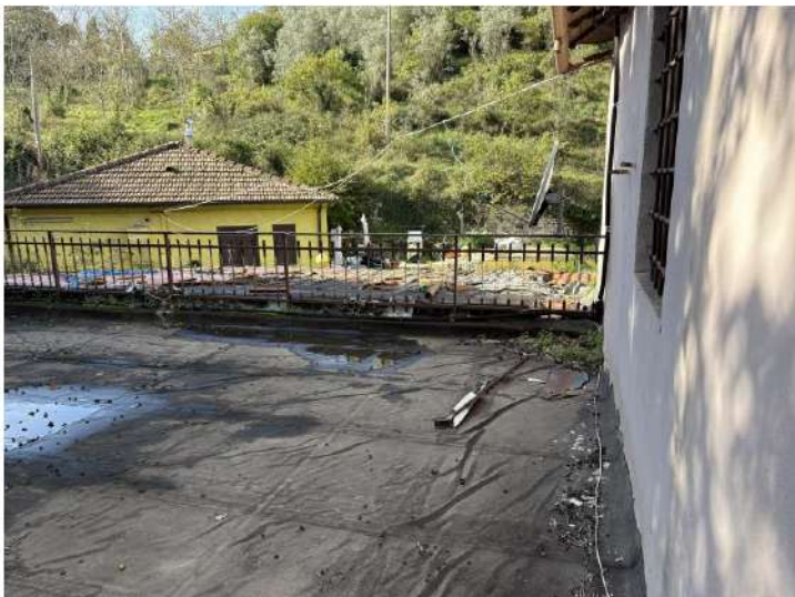
Lastrico di copertura dei locali sottostanti (sala ristorante al piano terreno esposta a sud-est) non pavimentato
