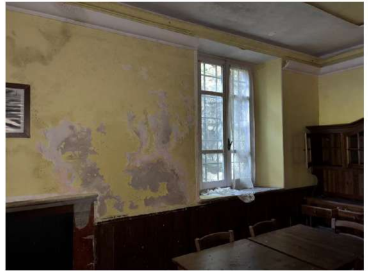
Sala Ristorante principale esposta a sud-est coperta dal Lastrico con la parete esterna lato Est ammalorata e danneggiata da copiose infiltrazioni
