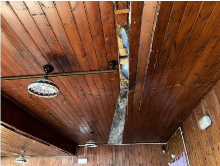
Sala Ristorante esterna esposta a sud-ovest con i controsoffitti e la copertura ammalorati e danneggiati da copiose infiltrazioni
