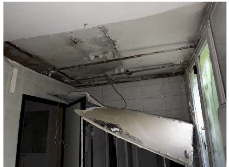
Servizi Igienici con i soffitti in pessime condizioni e per gran parte crollati a causa delle infiltrazioni provenienti dal Lastrico di copertura sovrastante
