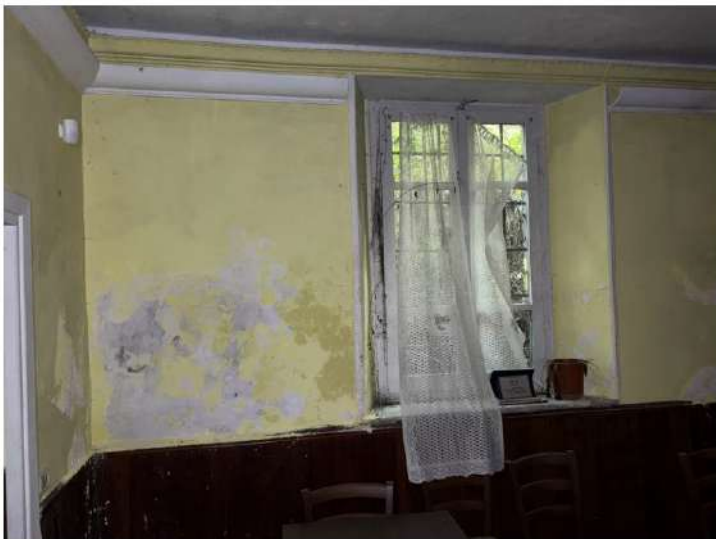
Sala Ristorante principale esposta a sud-est coperta dal Lastrico con la parete esterna lato Est ammalorata e danneggiata da copiose infiltrazioni
