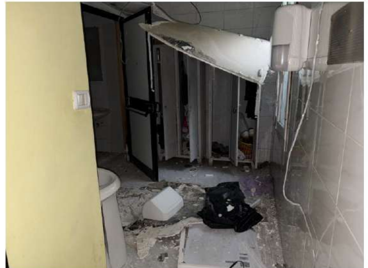
Servizi Igienici con i soffitti in pessime condizioni e per gran parte crollati a causa delle infiltrazioni provenienti dal Lastrico di copertura sovrastante
