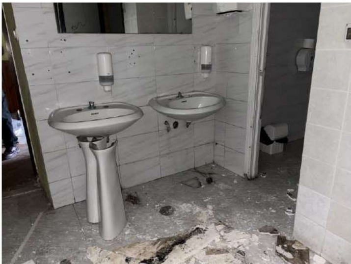
Servizi Igienici con i soffitti in pessime condizioni e per gran parte crollati a causa delle infiltrazioni provenienti dal Lastrico di copertura sovrastante
