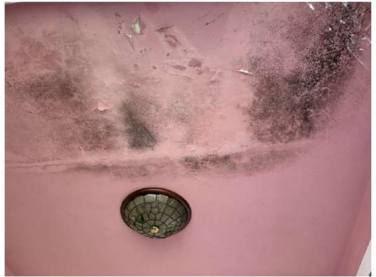
Portone di ingresso dell'Appartamento posto al piano 1° e danneggiamenti da infiltrazioni provenienti dalla copertura a tetto sull'ingresso
