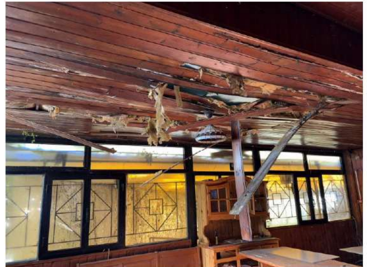
Sala Ristorante esterna esposta a sud-ovest con i controsoffitti e la copertura ammalorati e danneggiati da copiose infiltrazioni
