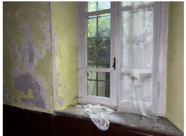
Sala Ristorante principale esposta a sud-est coperta dal Lastrico con la parete esterna lato Est ammalorata e danneggiata da copiose infiltrazioni
