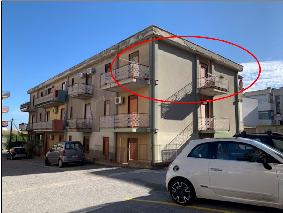
Figura 5: Ripresa del fabbricato in cui è ubicato l'immobile pignorato (nell'ovale rosso)
