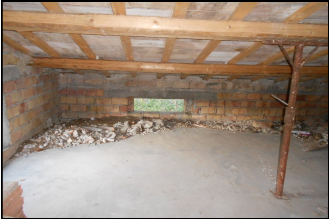
Foto n° 26 Piano Secondo sottotetto
