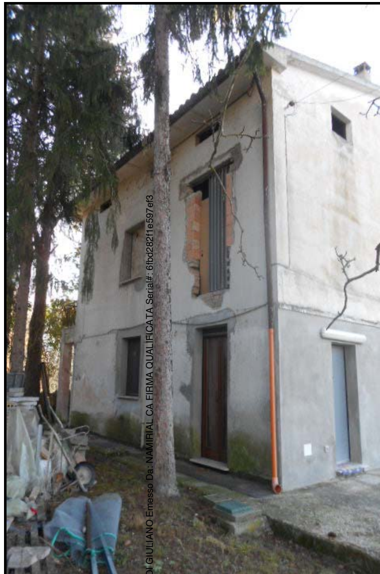
Foto n° 4 Immobile fronte nord
