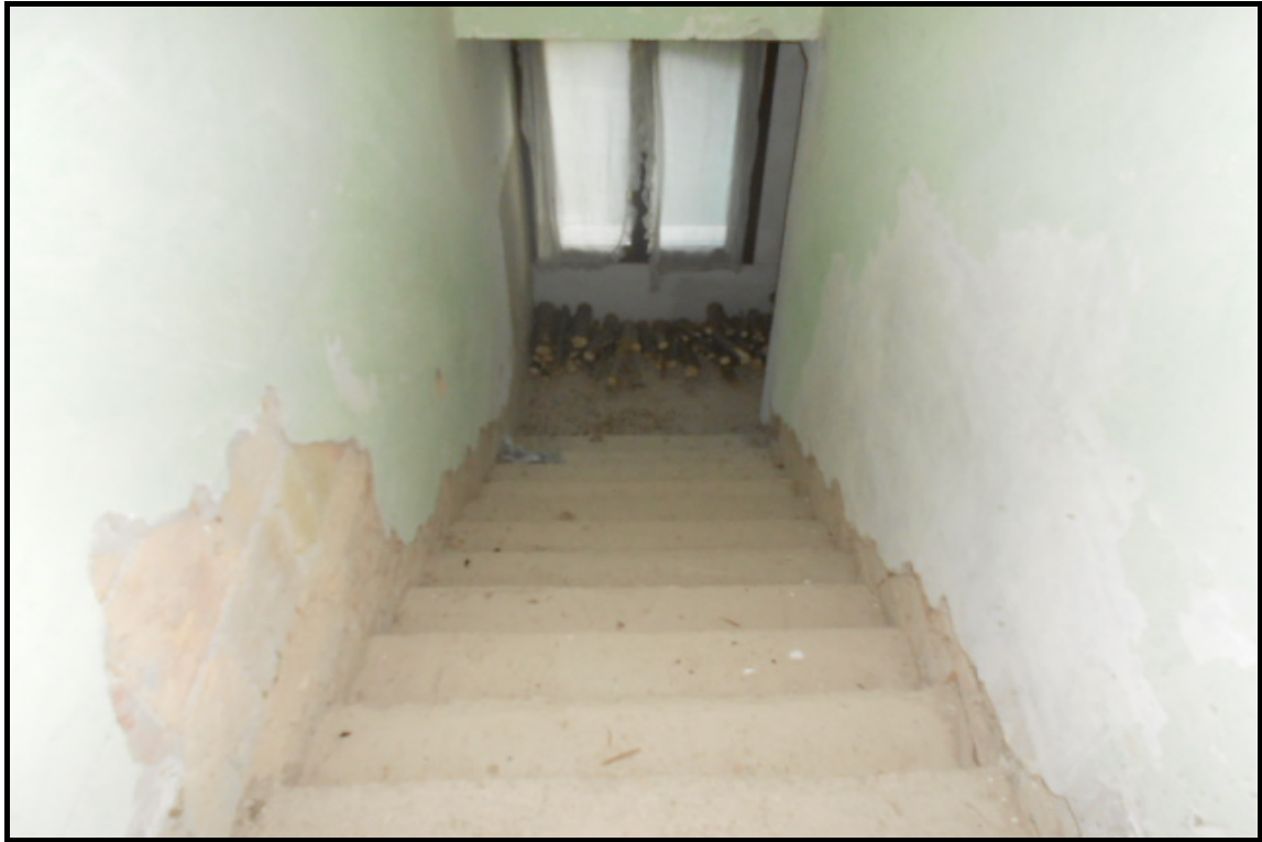
Foto n° 16 Scala al Piano Primo
