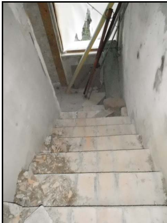
Foto n° 23 Scala al Piano Secondo sottotetto
