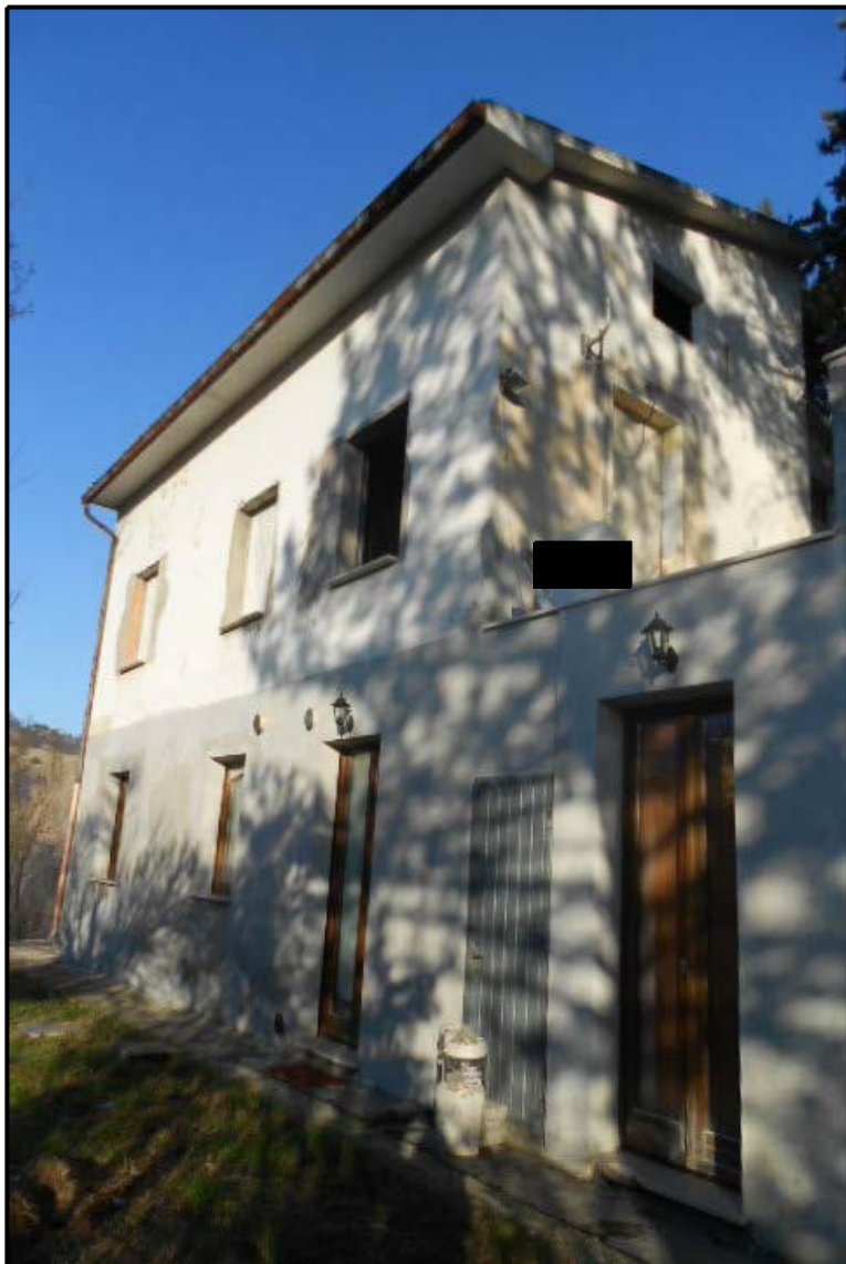
Foto n° 3 Immobile fronte sud
