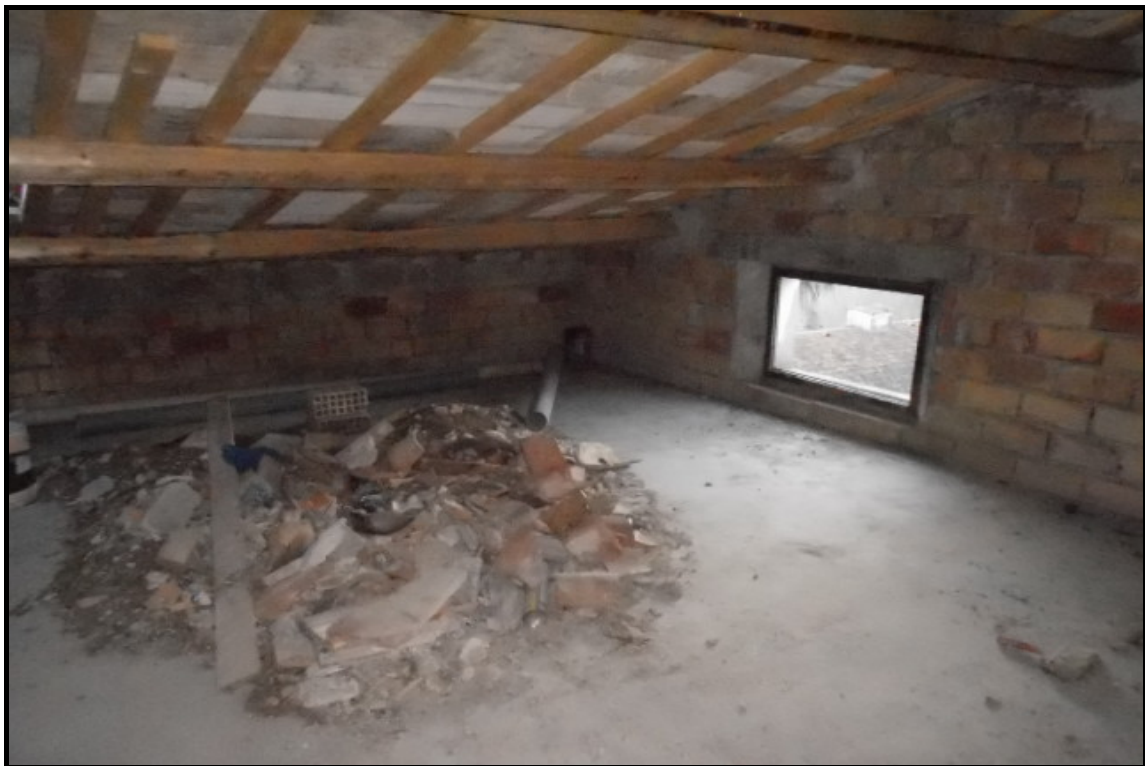
Foto n° 25 Piano Secondo sottotetto
