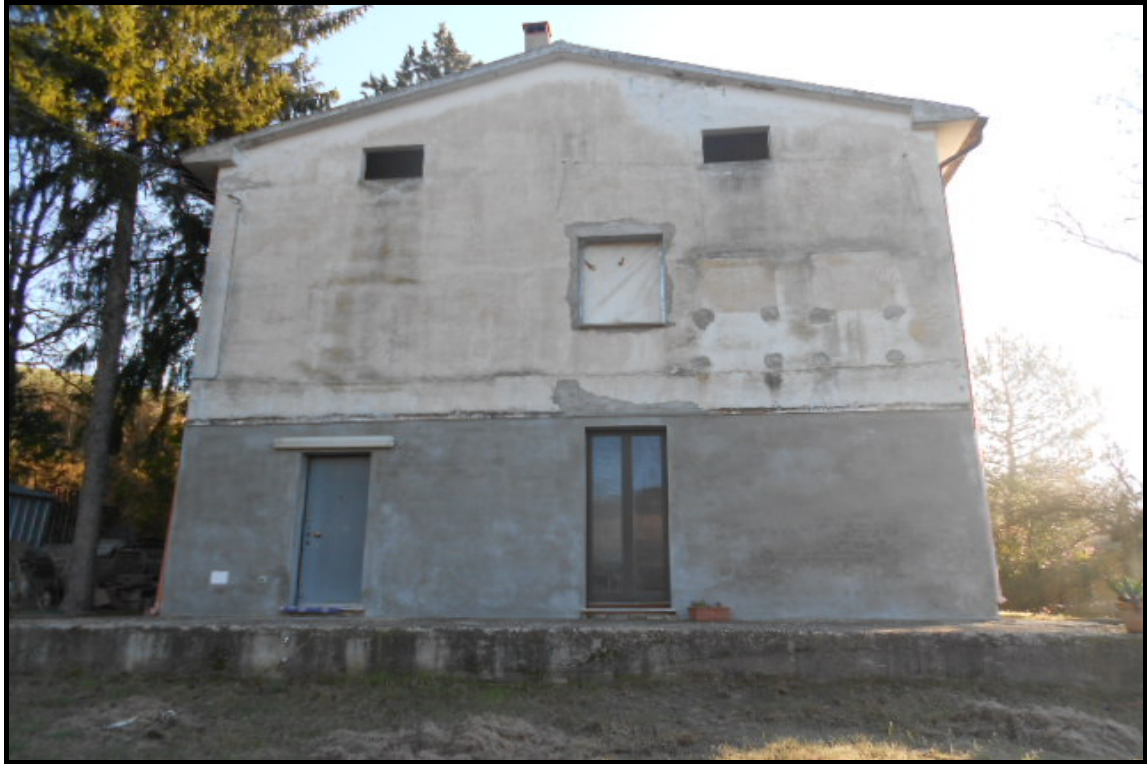
Foto n° 5 Immobile vista ovest con ingresso
