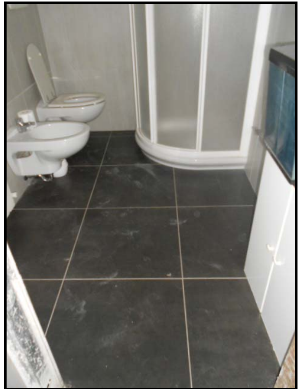
Foto n° 11 W.C. Piano Terra
