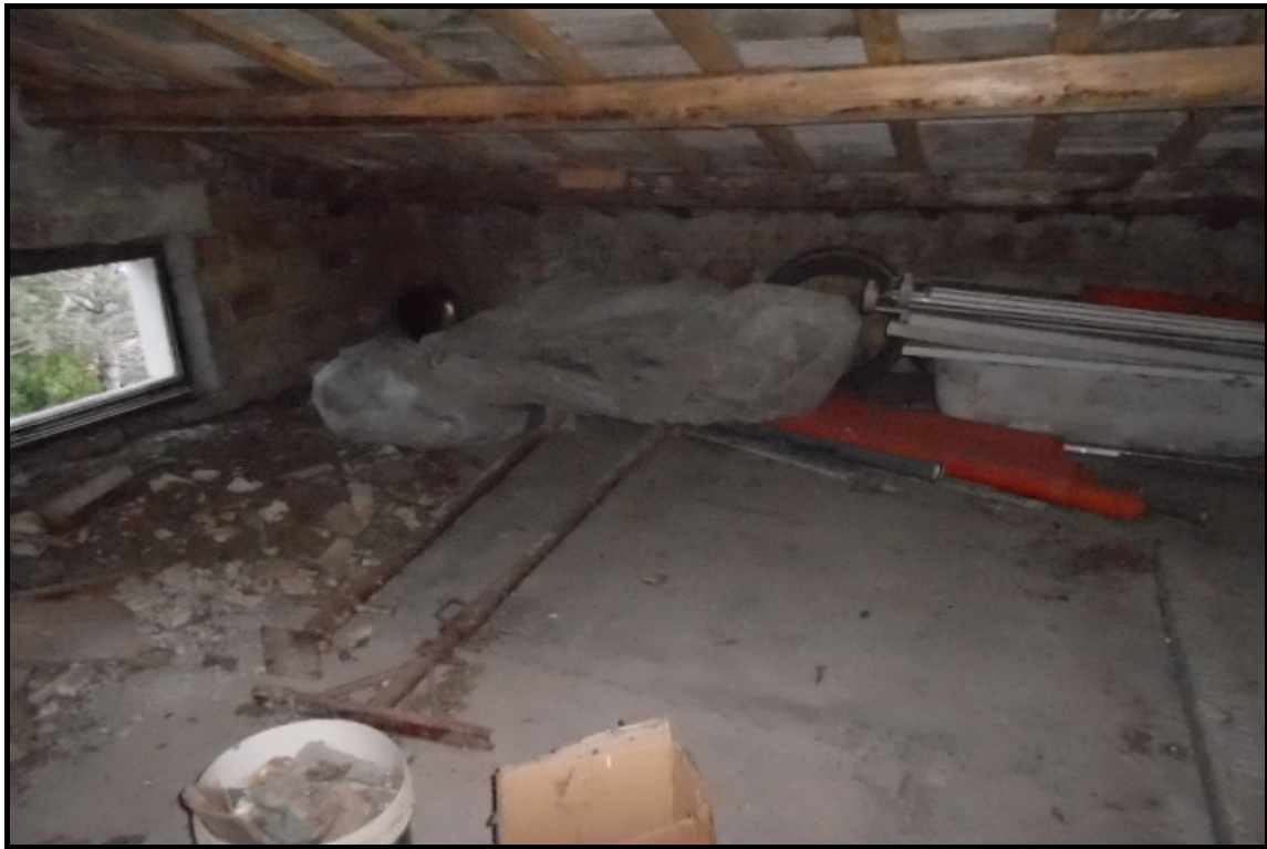
Foto n° 24 Piano Secondo sottotetto
