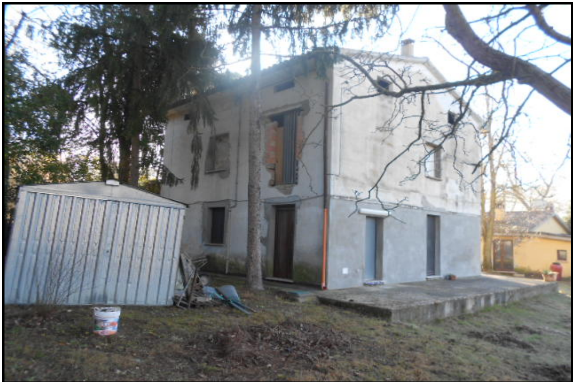
Foto n° 6 Immobile vista nord-ovest
