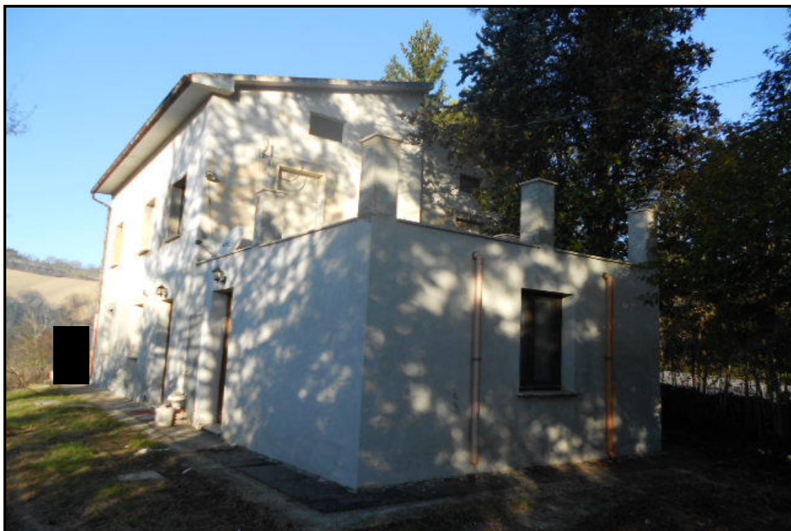
Foto n° 2 Immobile vista sud-est
