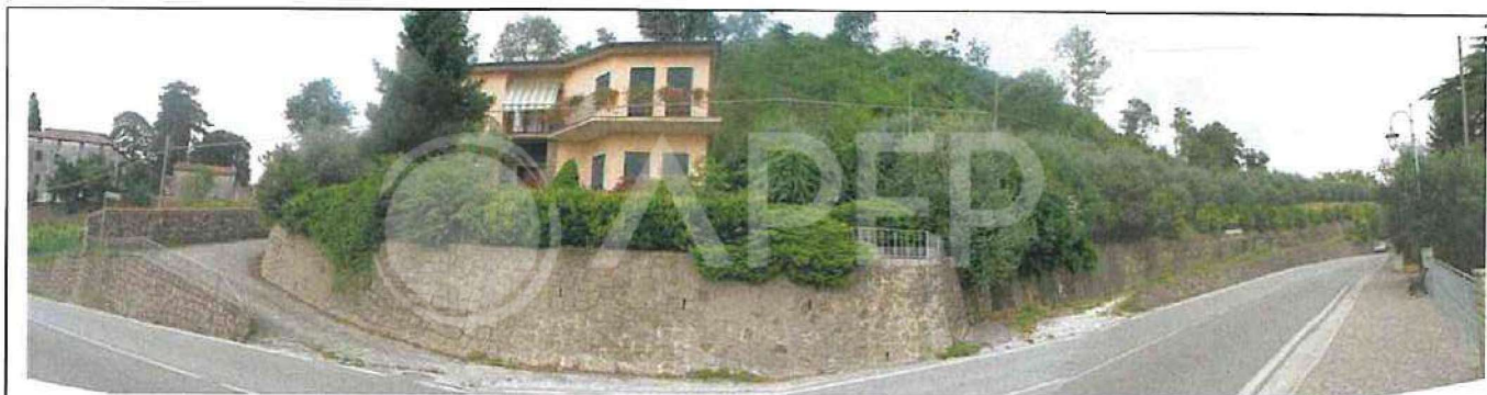
Foto n°1: Panoramica fronte est edificio e terreni.
