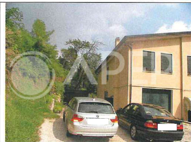
Foto n°11: Prospetto ovest edificio
