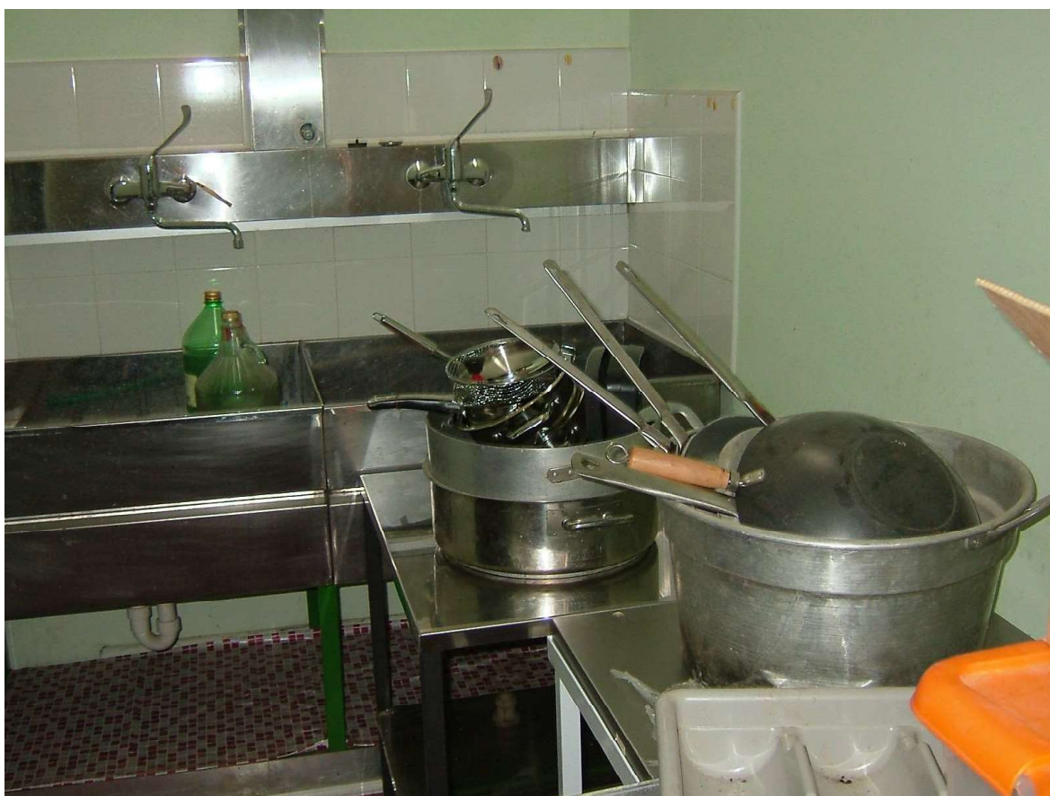
Foto 7 - piccolo locale uso cucina
