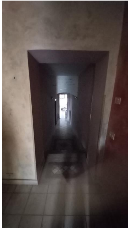
Foto n. 9 - P.1° interno abitazione sub 6 porta per accedere al sub 5/4 commerciale
