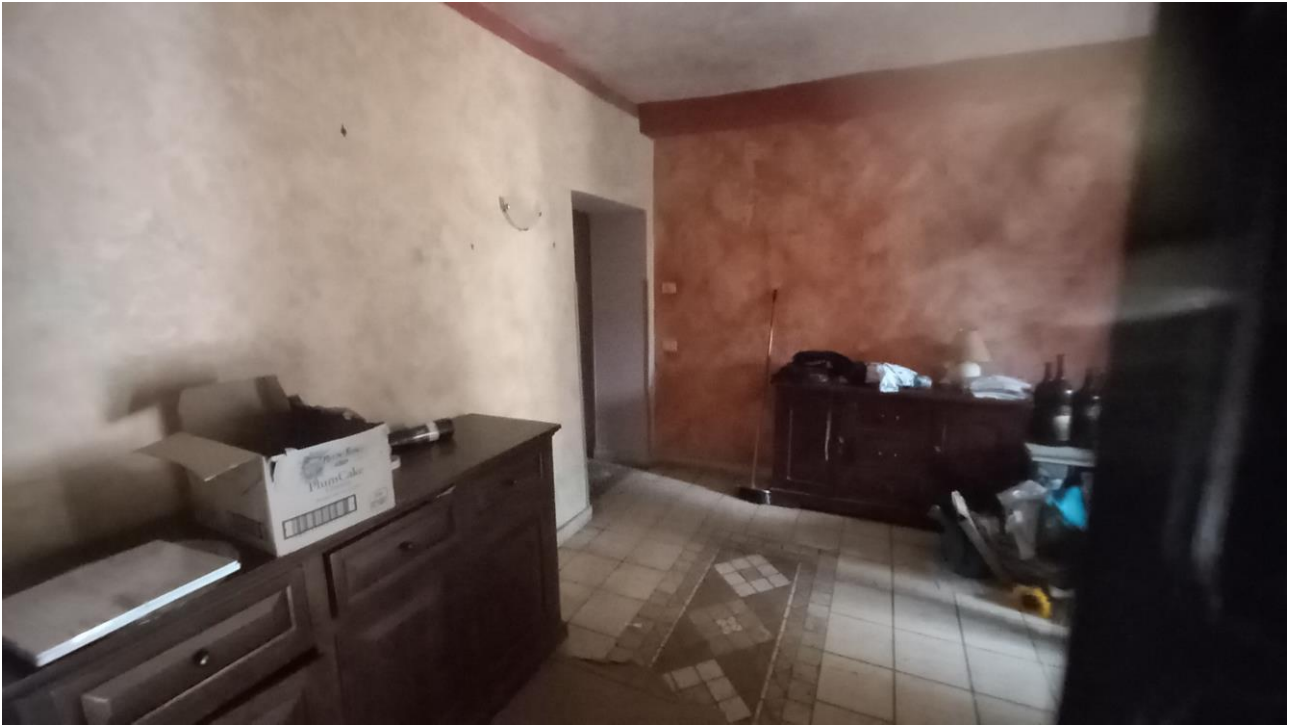
Foto n. 3 - P.1° interno abitazione sub 6 stanza/ingresso unico ai sub 6 5/4
