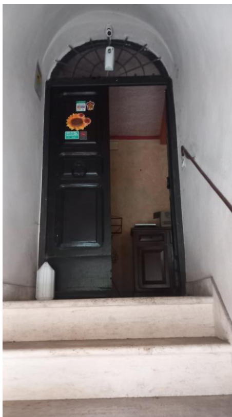
Foto n. 2 - P.1°. Ingresso unico ai sub 6 P. 1° 2° e sub 5/4 P. 1°
