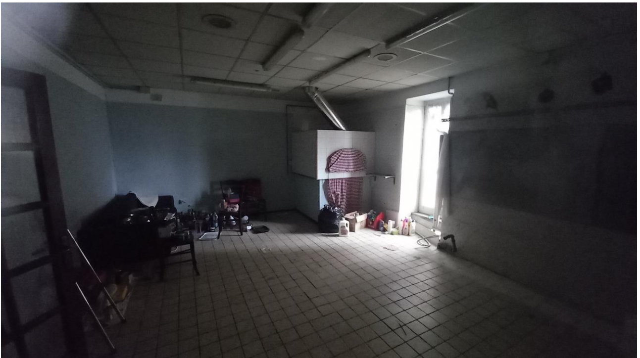
Foto n. 10 - P.1° interno unità commerciale sub 5/4 cucina
