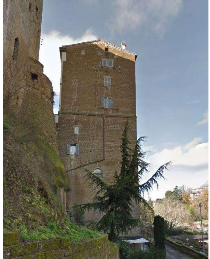
Foto 8 – Vista del prospetto nord da Via Acqua delle Rupi
