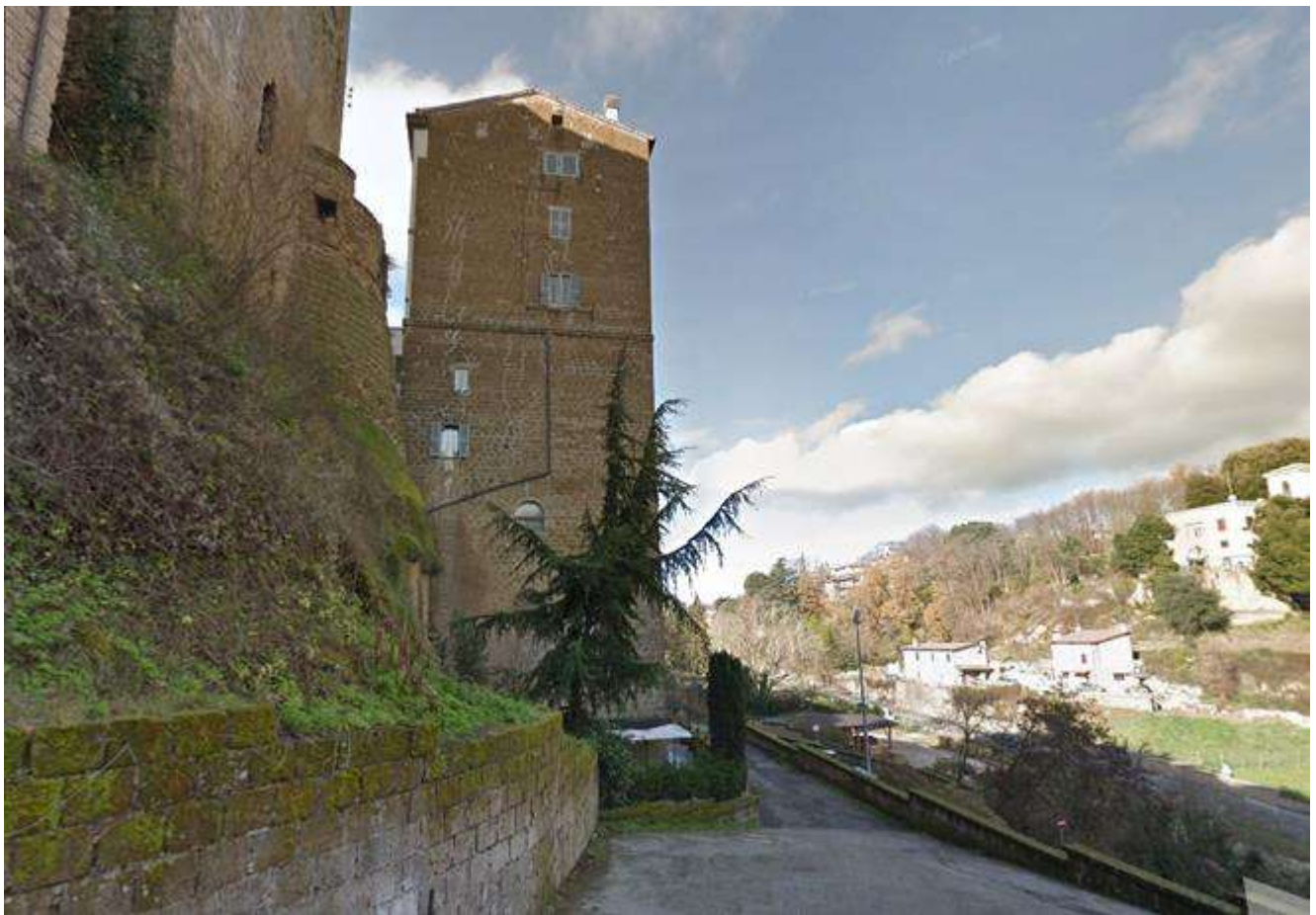
Foto 10 – Vista del prospetto est da Via Acqua alle Rupi
