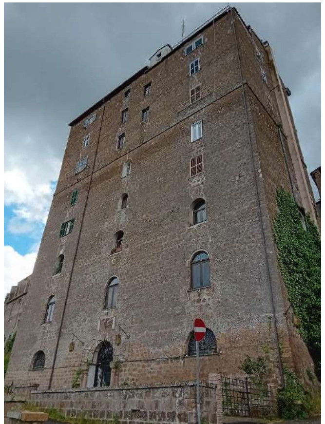
Foto 12 – Vista del prospetto nord da Via Acqua delle Rupi
