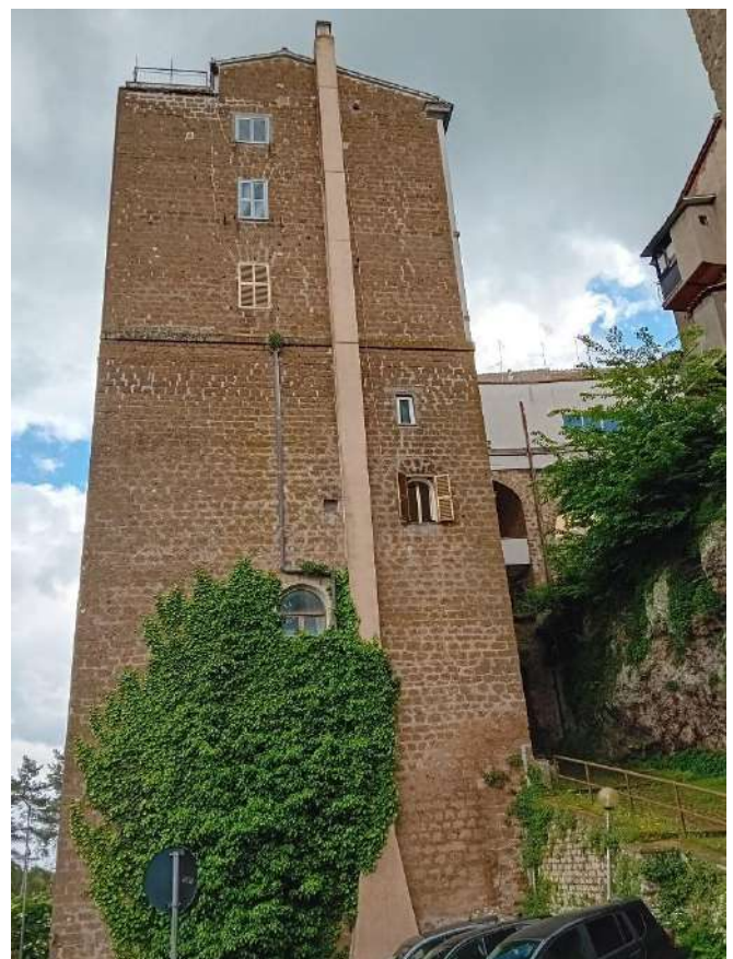
Foto 15 – Prospetto ovest da Vicolo delle Fontane
