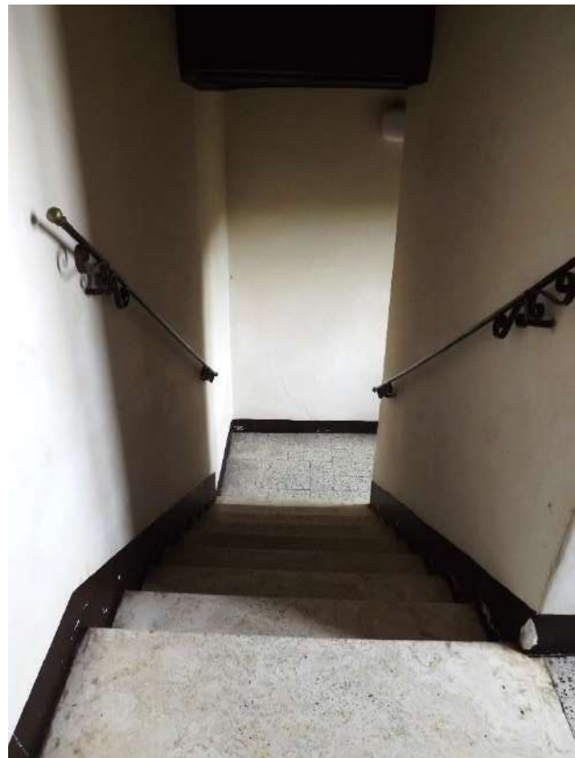
Foto 21 – Rampa vano scale condominiale
