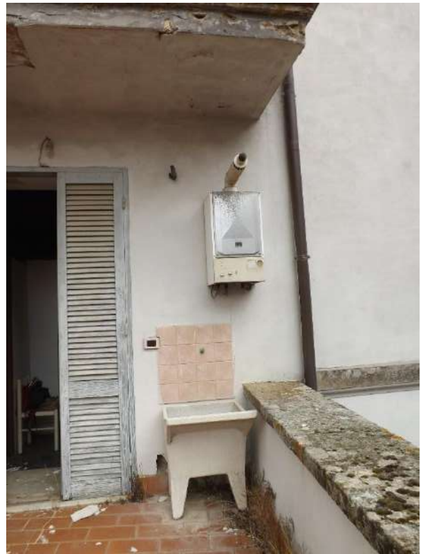
Foto 37 – Lavatoio e caldaia posti sulla terrazza
