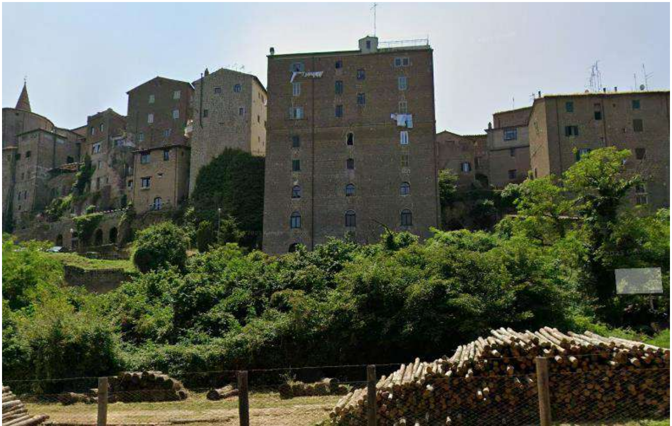
Foto 13 – Vista del prospetto nord dalla Via Cassia
