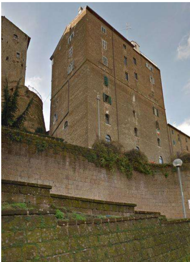
Foto 11 – Vista dei prospetti est e nord
