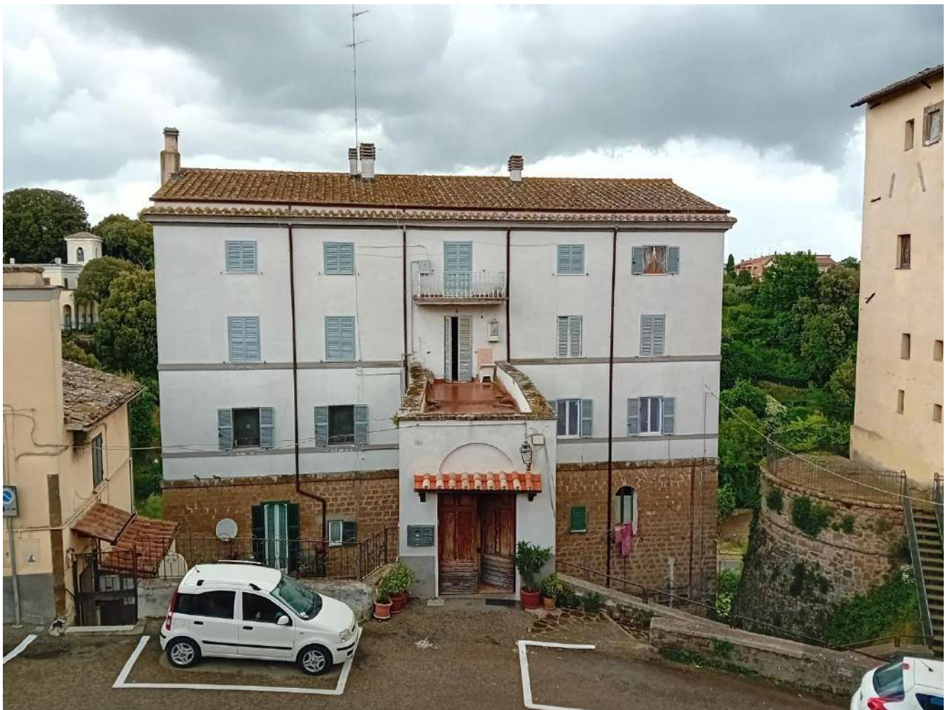
Foto 2 – Prospetto del fabbricato su Via Romana
