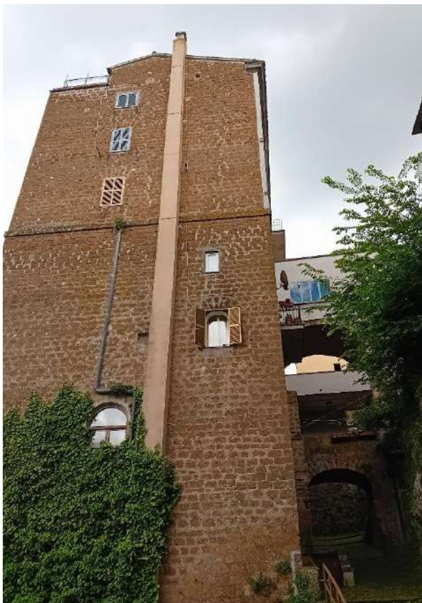
Foto 14 – Prospetto ovest con vista sull'androne e sulle arcate
