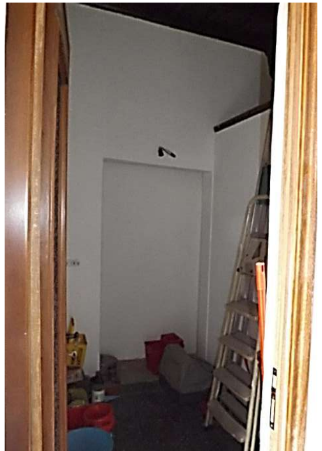
Foto 30 – Ripostiglio con vista sulla nicchia (ex vano porta)
