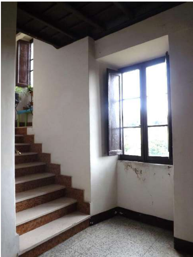
Foto 20 – Vano scale condominiale
