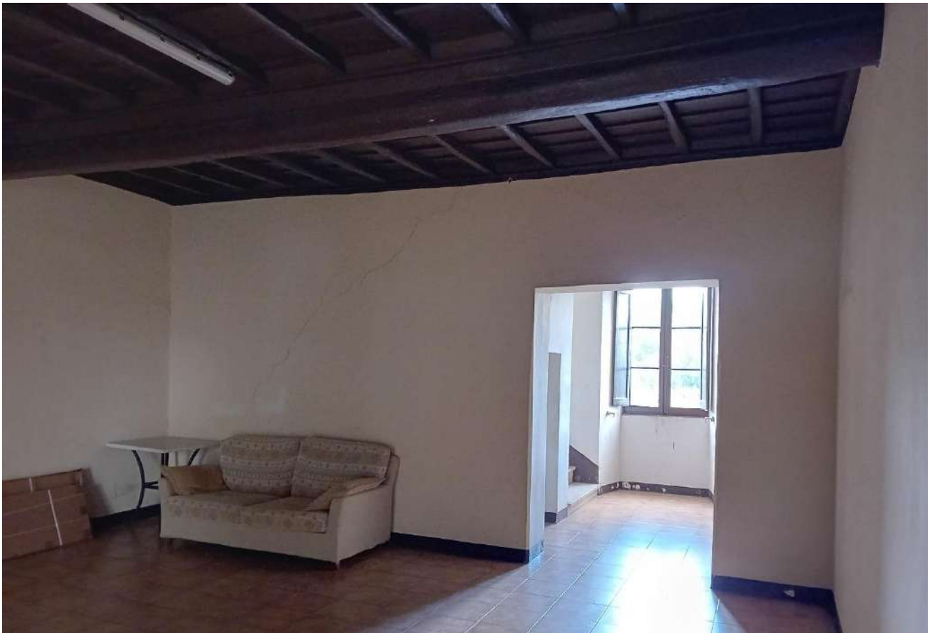
Foto 19 – Androne el vano scale condominiale
