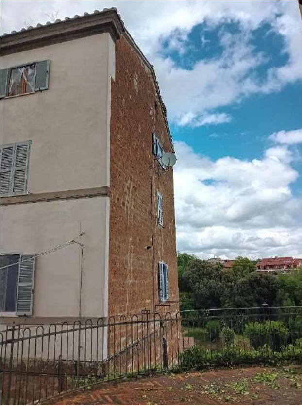
Foto 7 – Vista del prospetto est da Vicolo della Fontana
