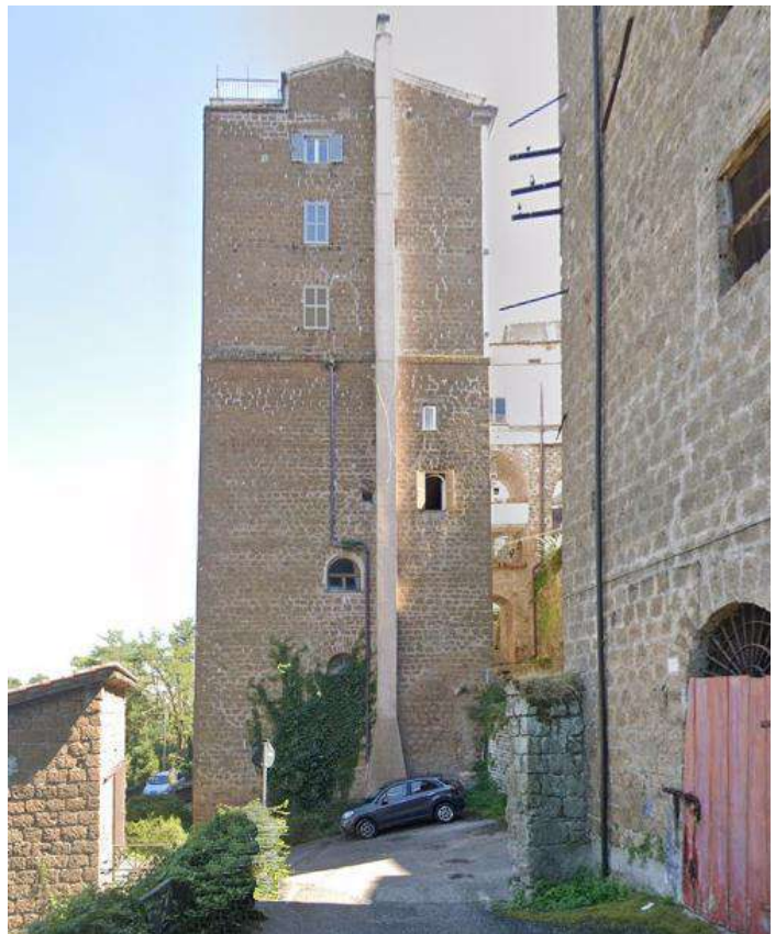
Foto 17 – Vista da Vicolo Sciapparino
