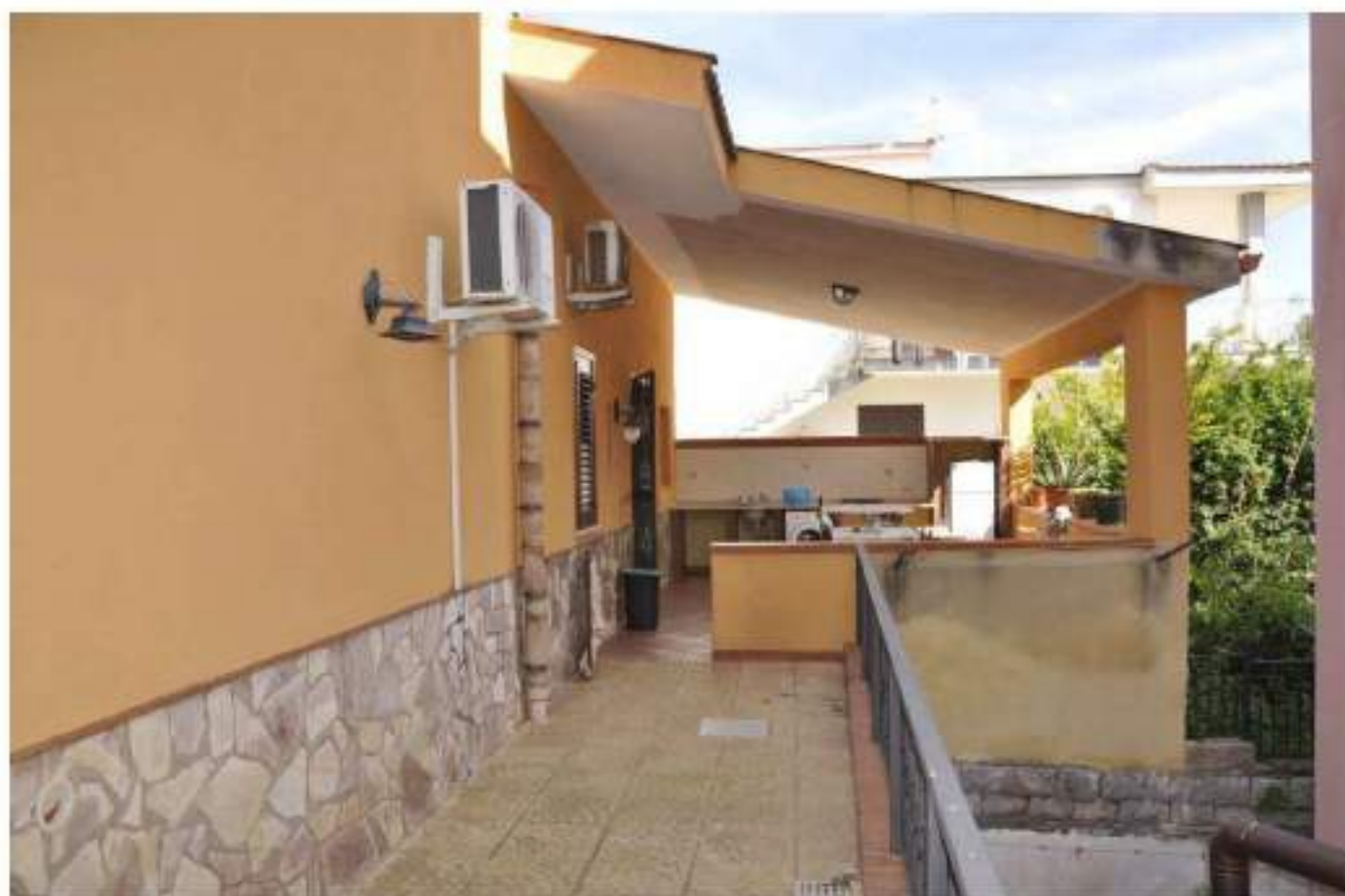
10 - Corte interna al piano terra
