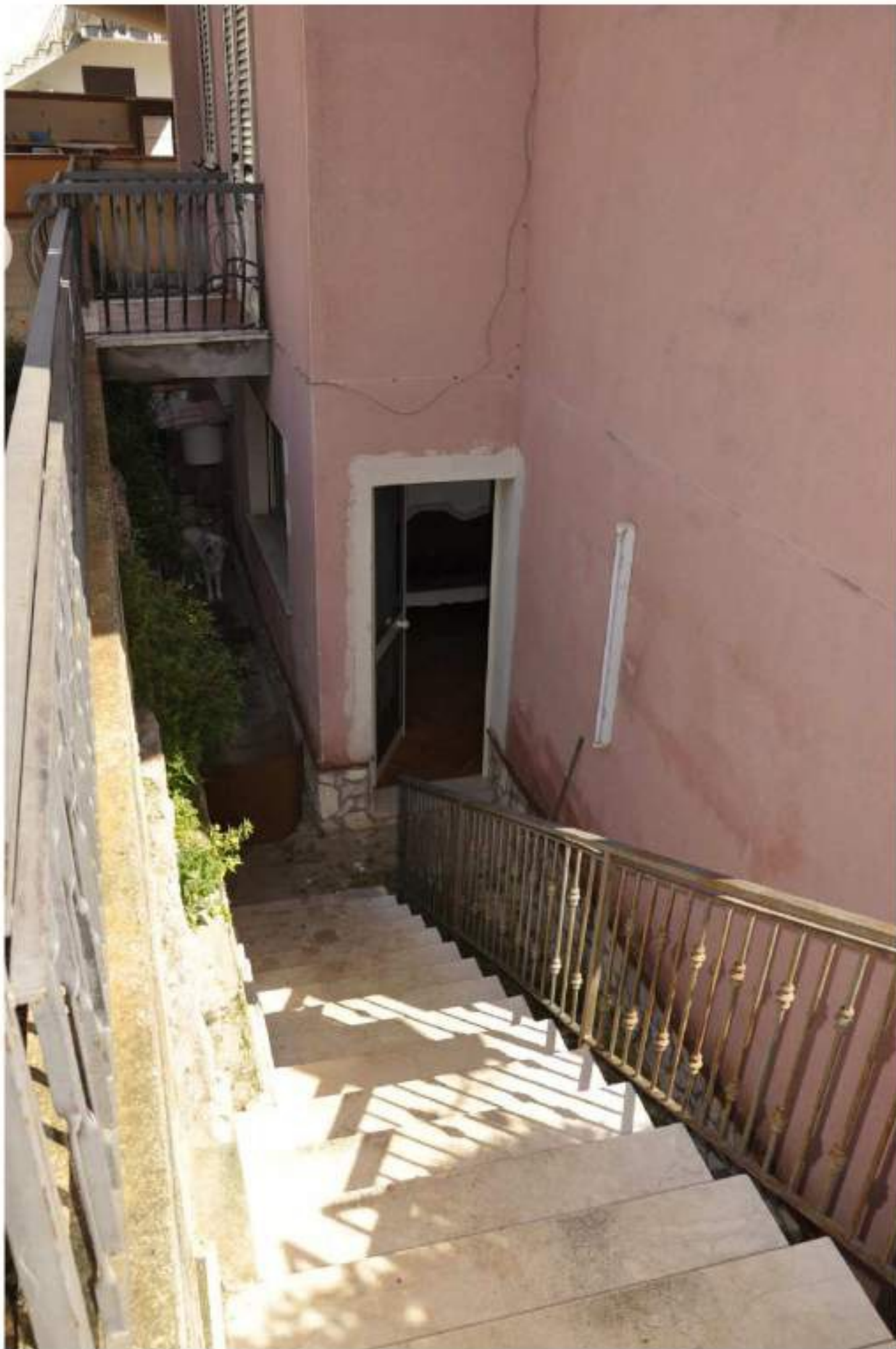
36 - Corte comune, scala di accesso al seminterrato (sub 4)
