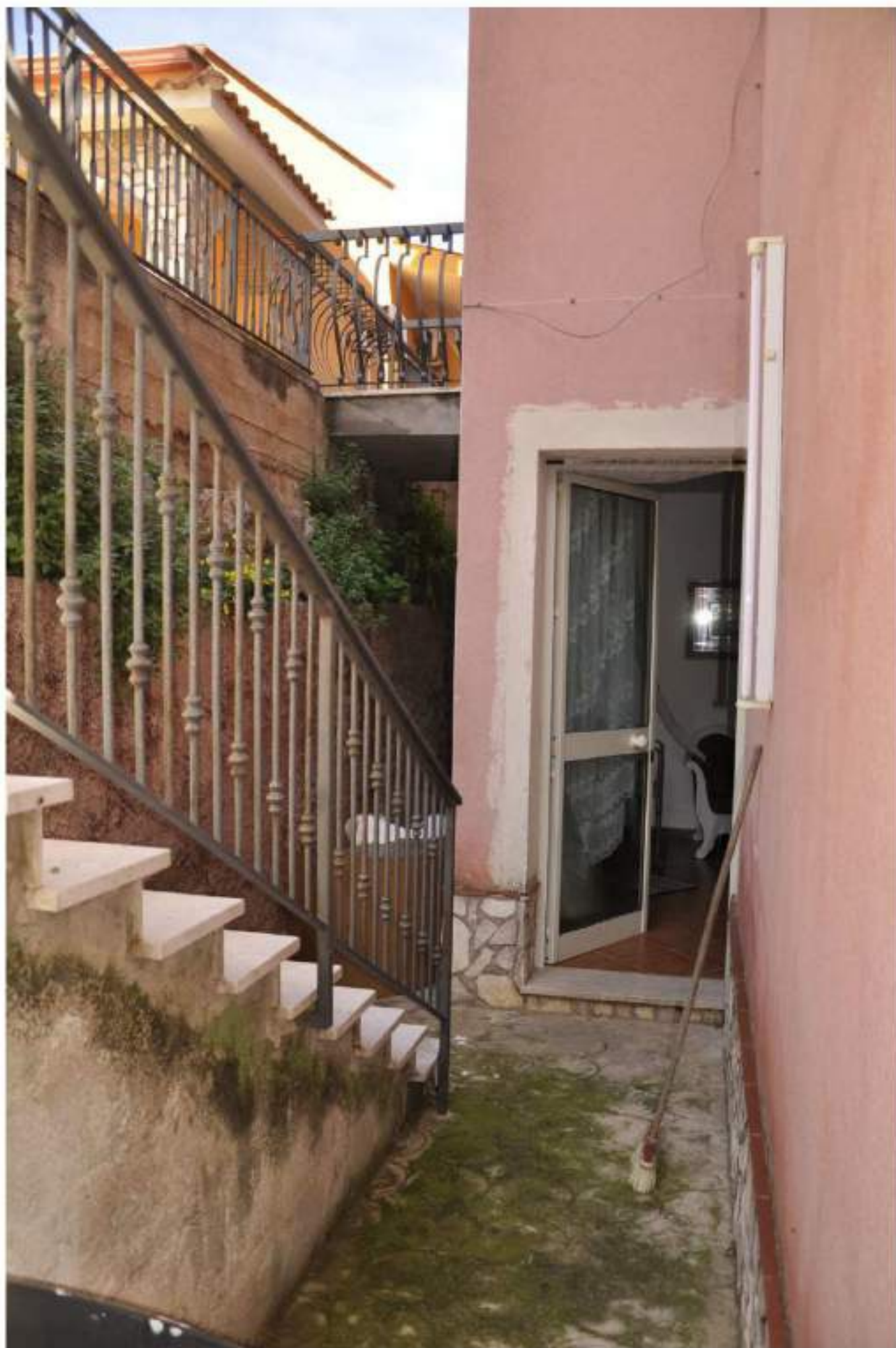
37 - Corte comune, scala e porta di accesso al seminterrato (sub 4)
