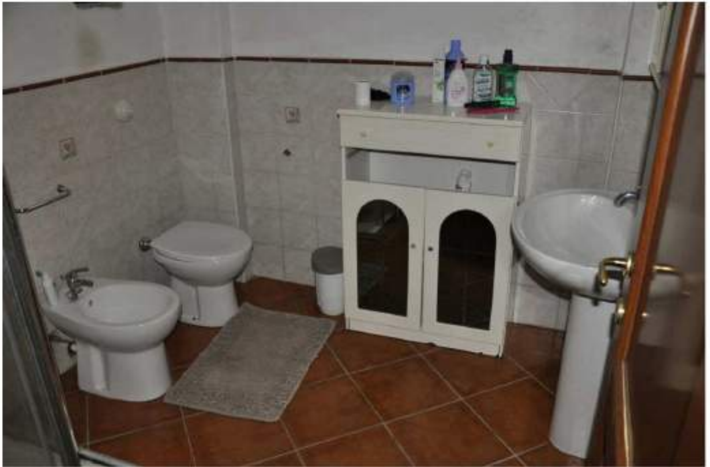
51 - Piano seminterrato, servizio igienico
