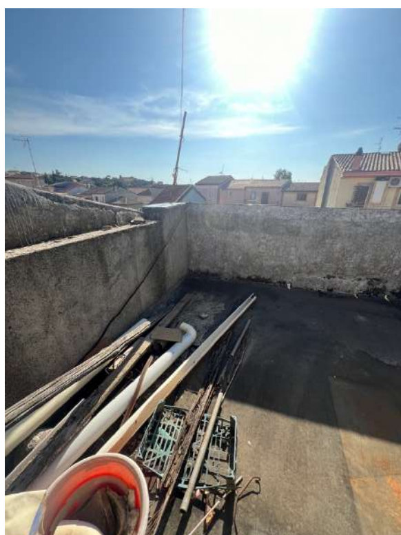
Figura 28 Terrazzo scoperto privo di pavimentazione: vi è presente solo guaina impermeabilizzante obsoleta
