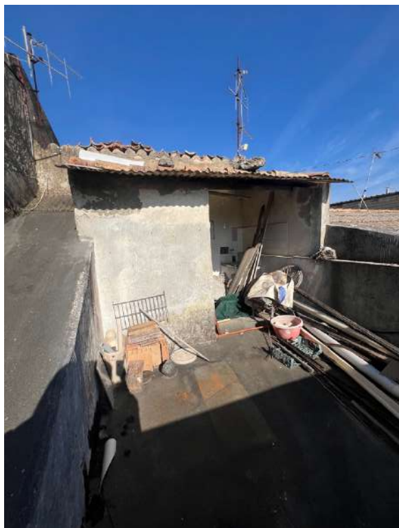
Figura 28 Terrazzo scoperto privo di pavimentazione: vi è presente solo guaina impermeabilizzante obsoleta
