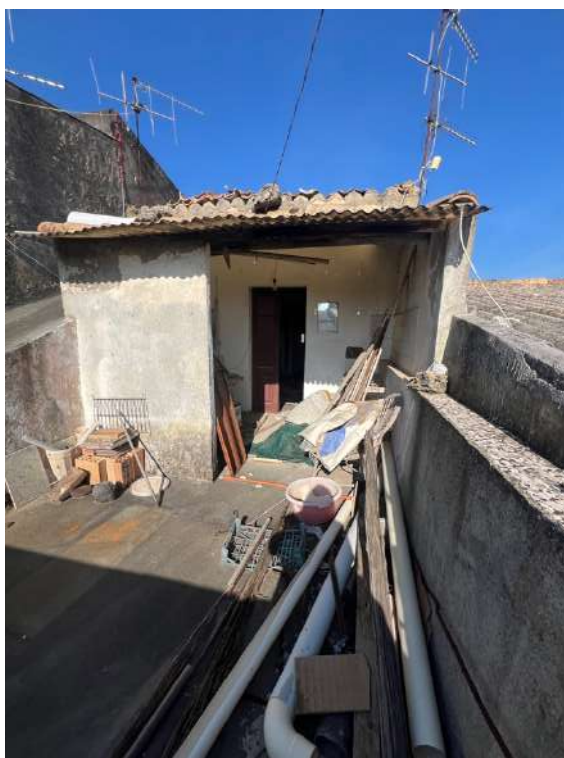
Figura 28 Terrazzo scoperto privo di pavimentazione: vi è presente solo guaina impermeabilizzante obsoleta
