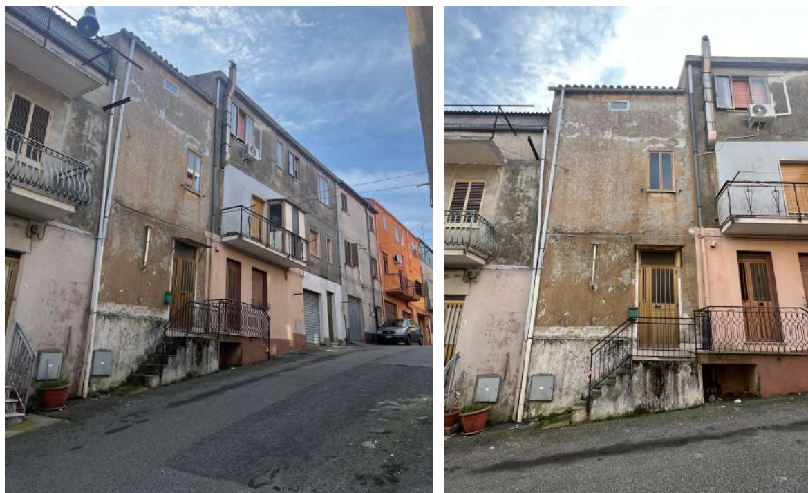
Figura 2 ingresso su via De Nicola
