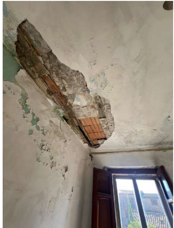
Figura 19 Dettagli degrado solaio soffitto
