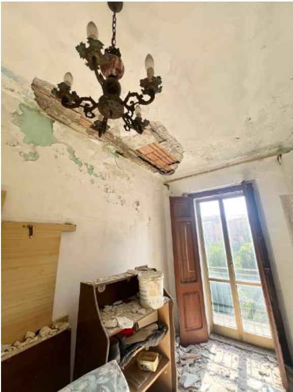
Figura 19 Dettagli degrado solaio soffitto
