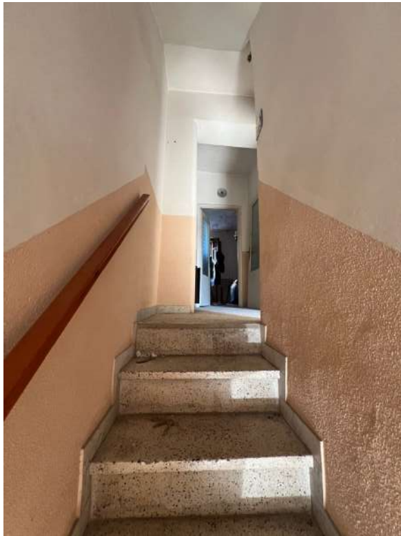
Figura 14 Accesso piano primo
