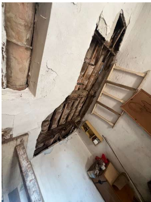
Figura 24 Distacco intonaco
