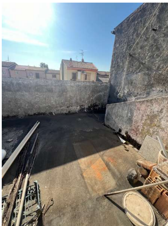
Figura 28 Terrazzo scoperto privo di pavimentazione: vi è presente solo guaina impermeabilizzante obsoleta
