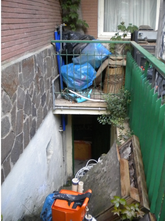
Foto 6- Scala di accesso al piano interrato.
