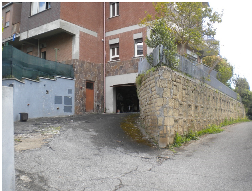
Foto 9- Rampa ingresso piano S1 da Via del Lampioncino
