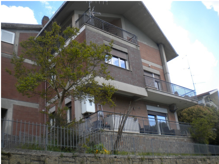
Foto 8- Prospetto sud edificio, lato Via del Lampioncino
