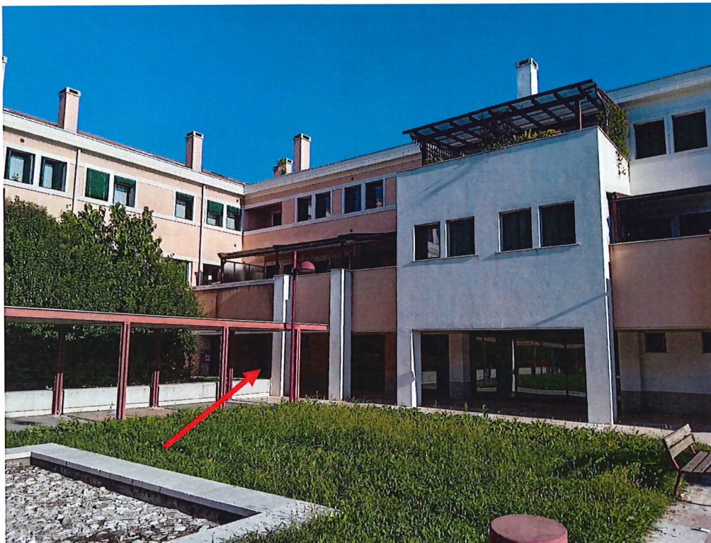
Foto 1: ingresso condominiale da P.zza del Sindacato
