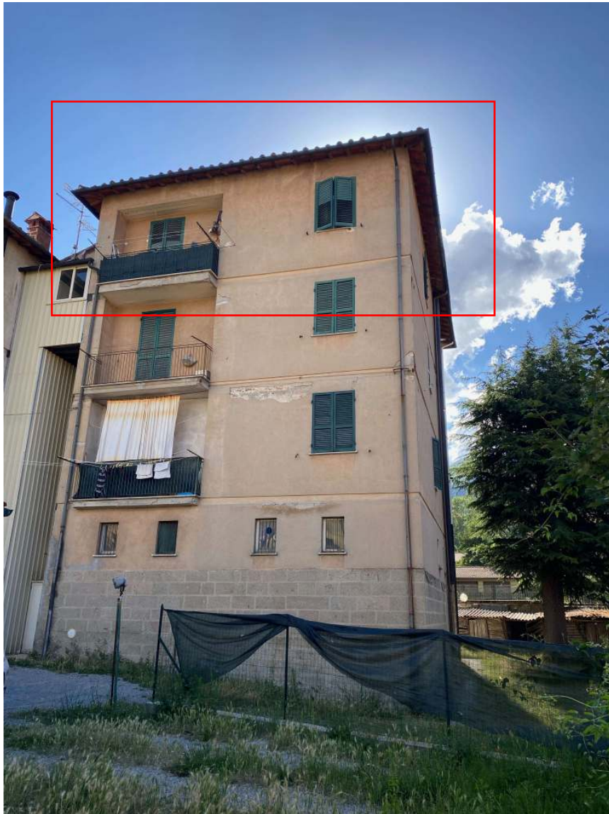
Foto n. 2 sul retro del fabbricato
