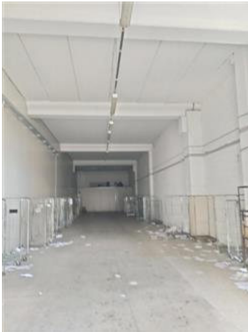
Interno del locale deposito, metà parte est
