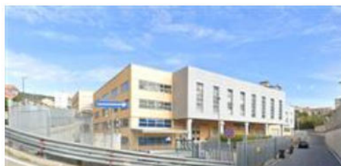
Vista complessiva dell'edificio C
