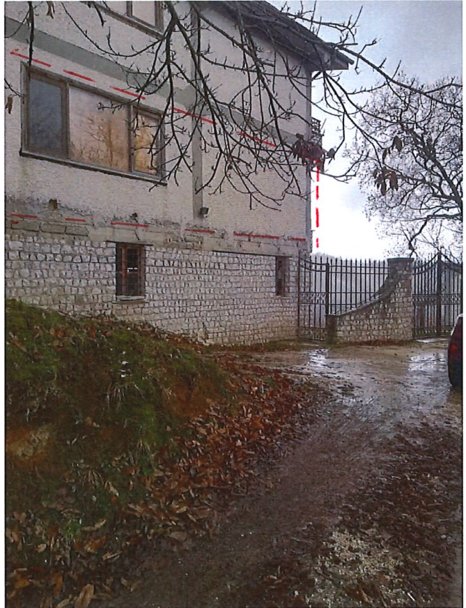
Foto 4 – Strada interpodereale di accesso all'edificio
