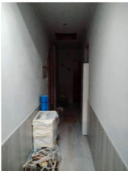
5) Corridoio d'accesso all'appartamento al secondo piano;
