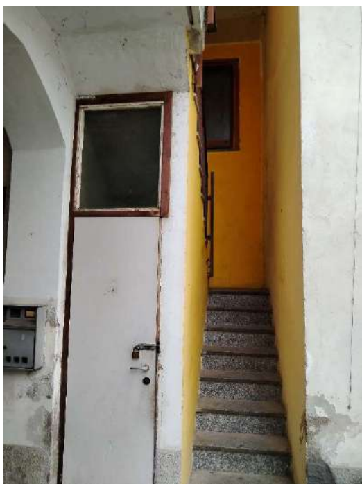
3) Scala d'accesso al ballatoio di distribuzione comune per raggiungere il secondo piano;
