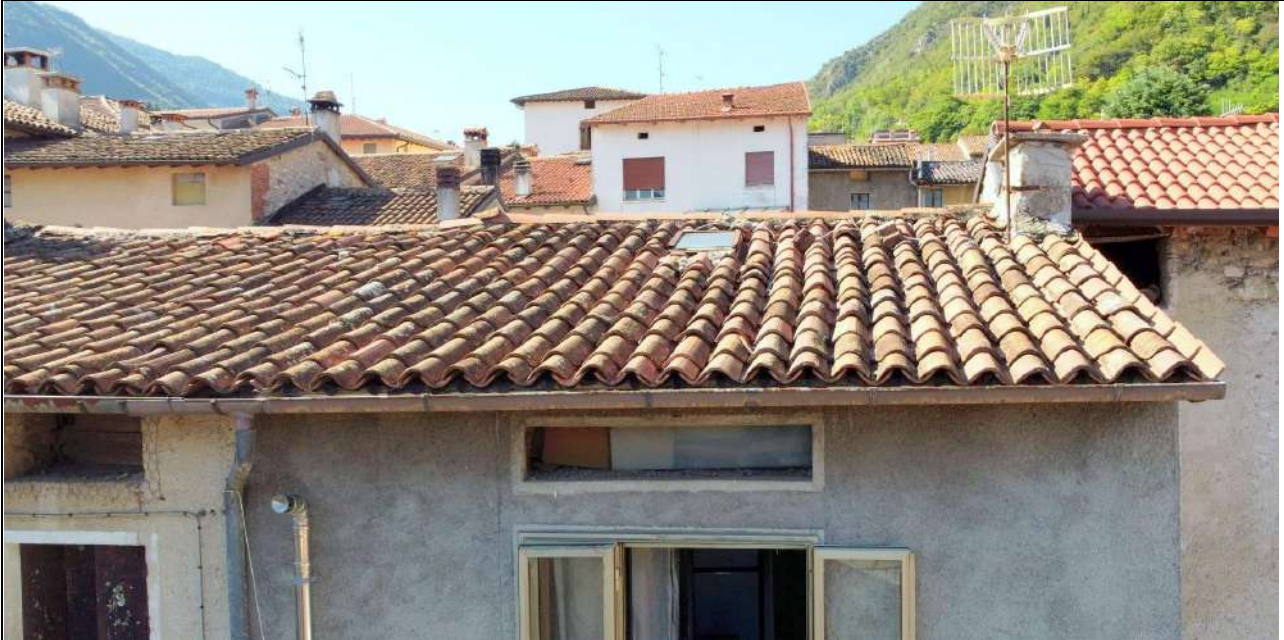
particolare piano di copertura in coppi
