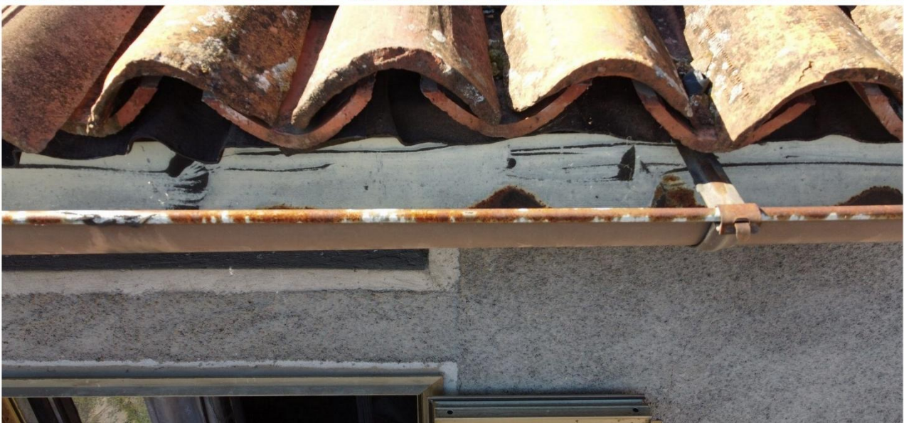
PARTICOLARI STATO MANUTENTIVO COPERTO ***fine***
