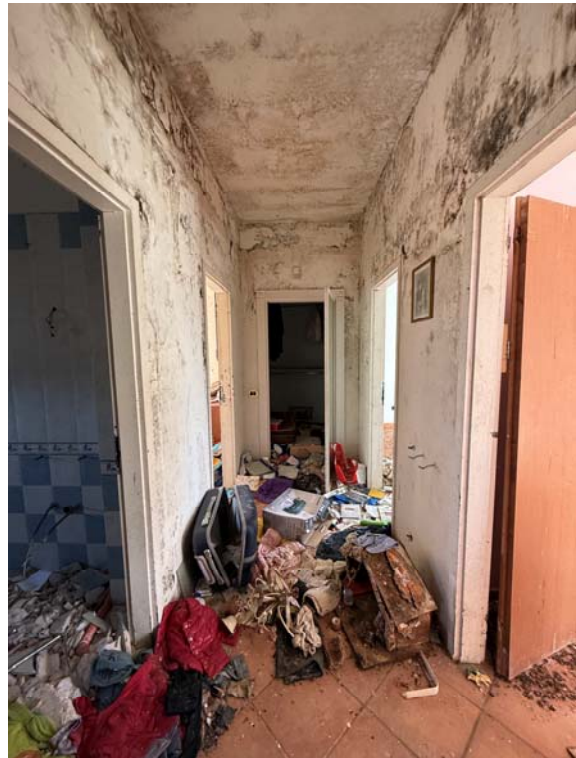
Disimpegno al piano primo (villa p.lla 256, sub. 1)
