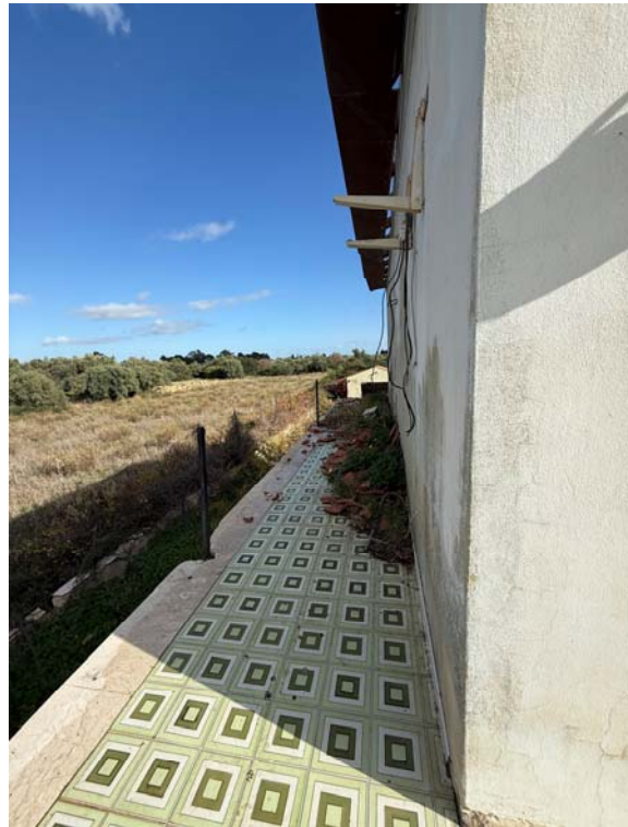
Terrazza esterna al piano primo (villa p.lla 256, sub. 1)
