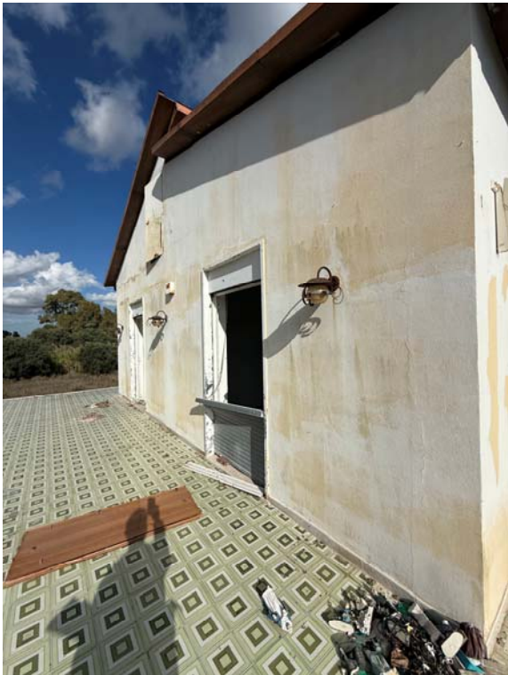
Terrazza esterna al piano primo (villa p.lla 256, sub. 1)
