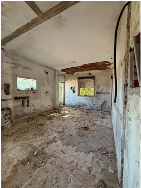
Cucina al piano terra (villa p.lla 256, sub. 1)
