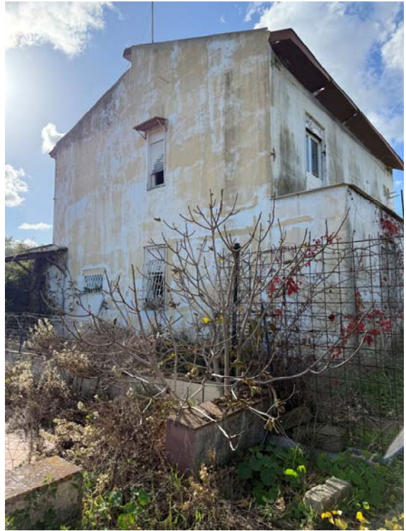
Retro della villa di cui alla p.lla 256, sub. 1
