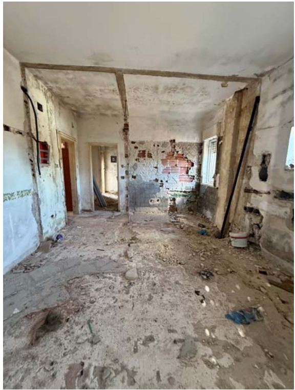
Cucina al piano terra (villa p.lla 256, sub. 1)
