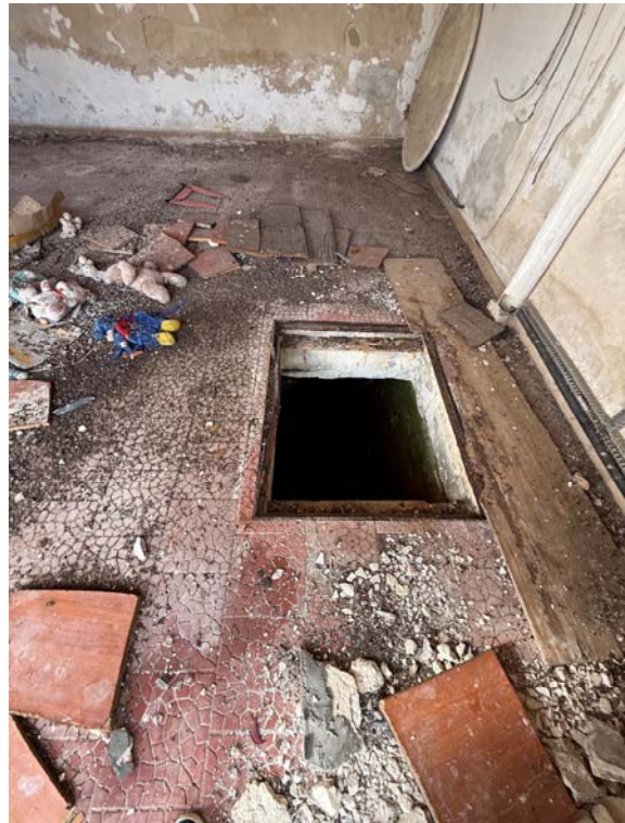
Garage di cui alla p.lla 256, sub. 2 – botola di accesso al vano sotterraneo ove avevano sede gli impianti della piscina
