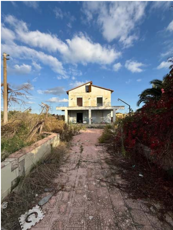
Viale d'ingresso interno al lotto di cui alla p.lla 256
