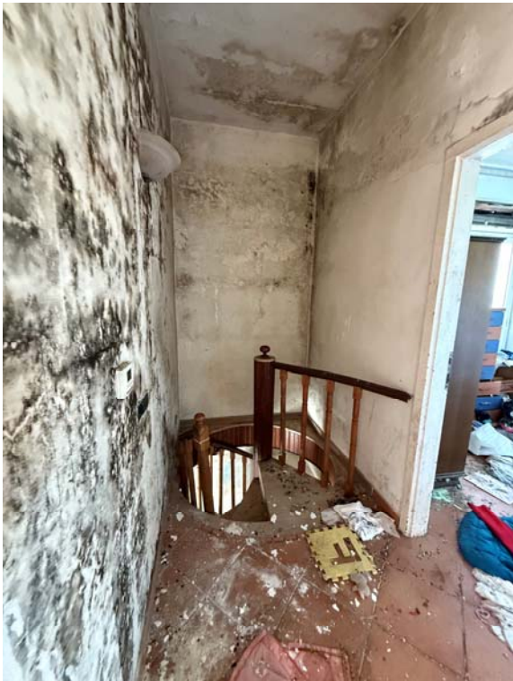
Scala di accesso al piano primo (villa p.lla 256, sub. 1)
