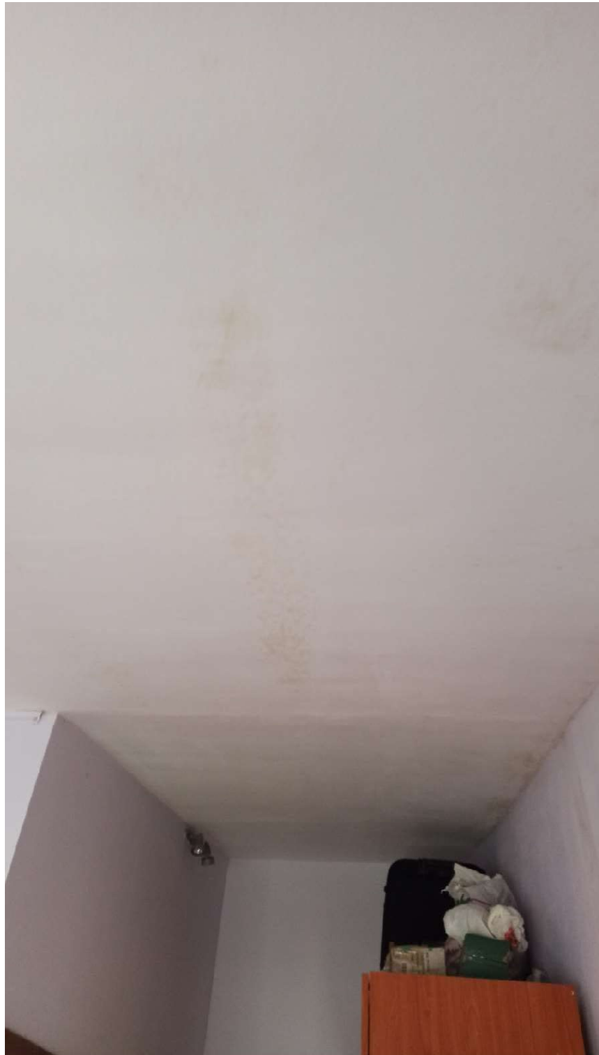
FOTO 22 – DETTAGLIO SOFFITTO CAMERA
