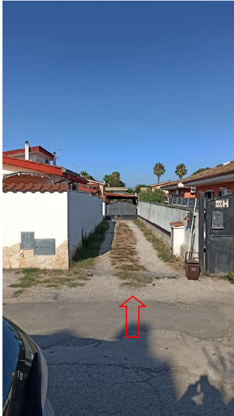
FOTO 1- ACCESSO COMUNE DA VIA METAURO (SUB. 1 – B.C.N.C.)
