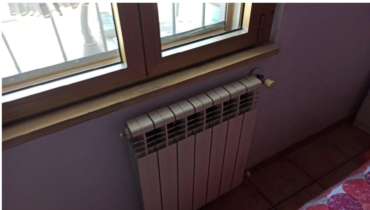
FOTO 23 – DETTAGLIO RADIATORE E INFISSO
