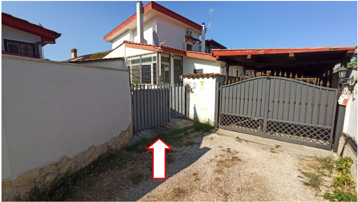
FOTO 4 – CANCELLO DI INGRESSO AL LOTTO
