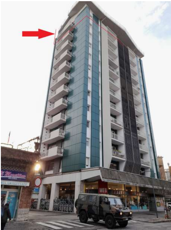
Facciata principale su viale Leopardi e laterale verso piazzale D'Annunzio
