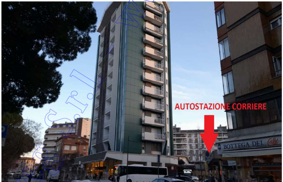
Fabbricato e autostazione corriere visti da viale Leopardi verso piazzale d'Annunzio
