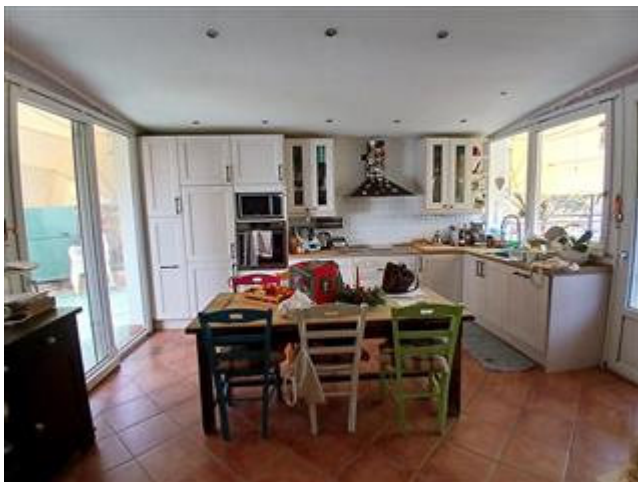
CUCINA OGGETTO DI ORDINANZA DI DEMOLIZIONE
