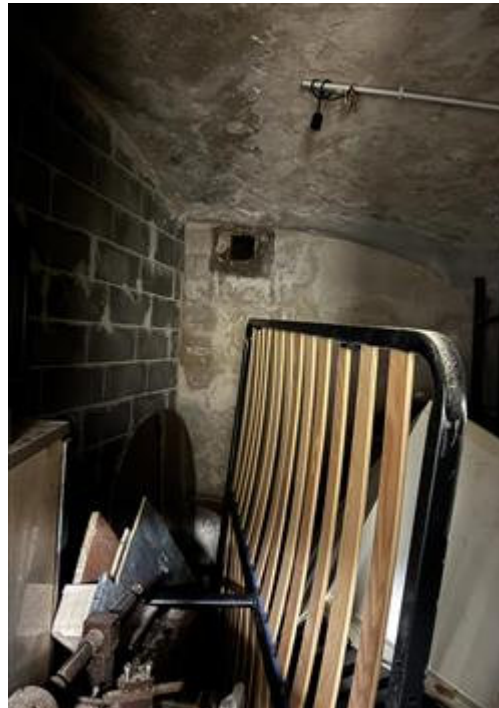
Vista interna della cantina
