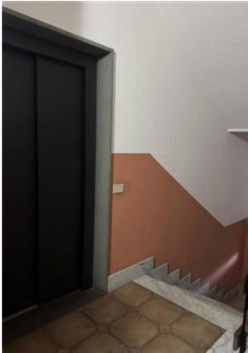
Vista del vano scala
