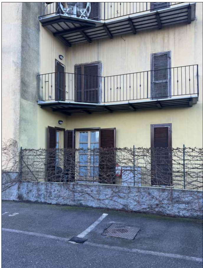
01_ Prospetto esterno da piazzale privato
