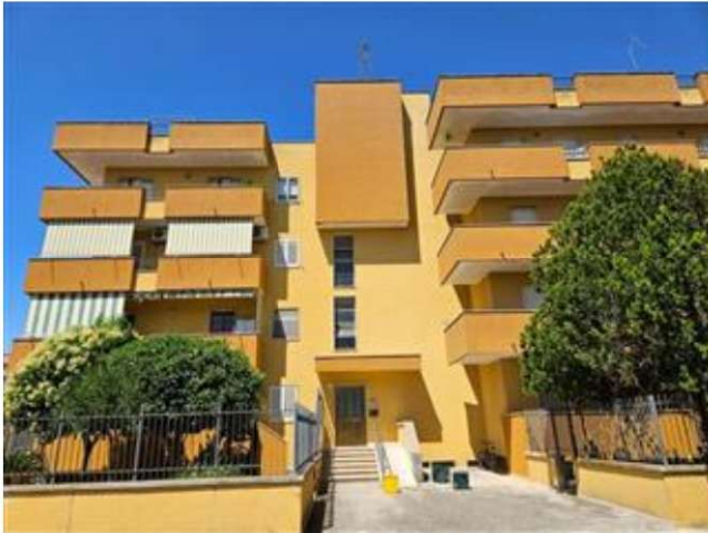
Prospetto condominiale su piazza pellizzari
