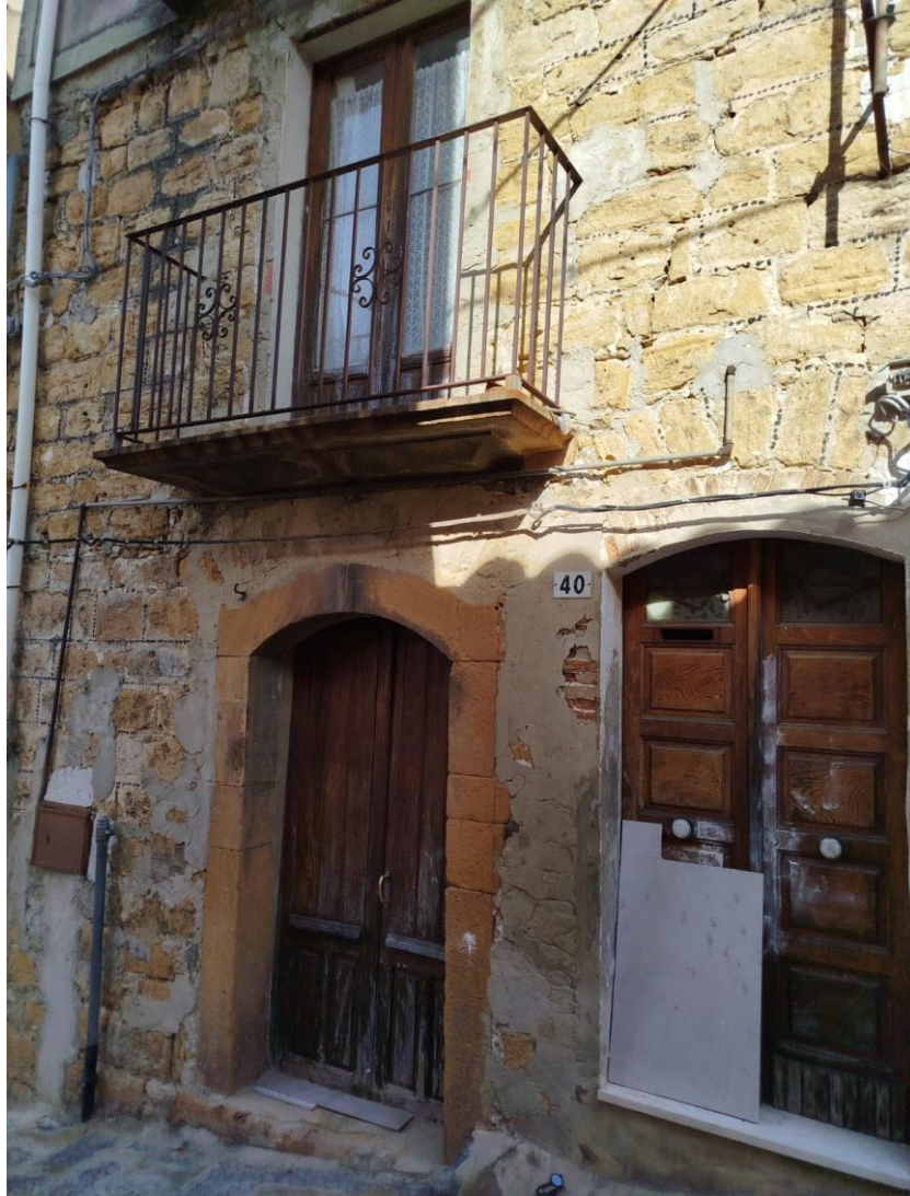
Foto 1 – esterno (foglio 130 particella 1911 sub. 1)
