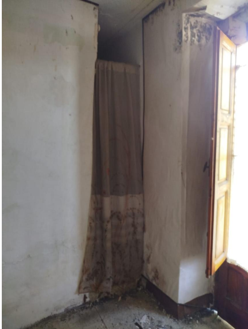
Foto 10 – piano primo (foglio 130 particella 1911 sub. 1)
