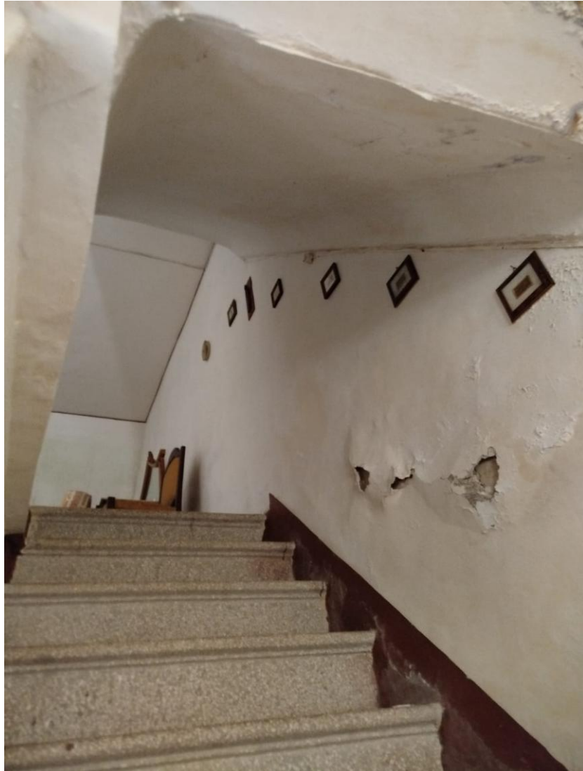
Foto 8 – vano scala (foglio 130 particella 1911 sub. 1)
