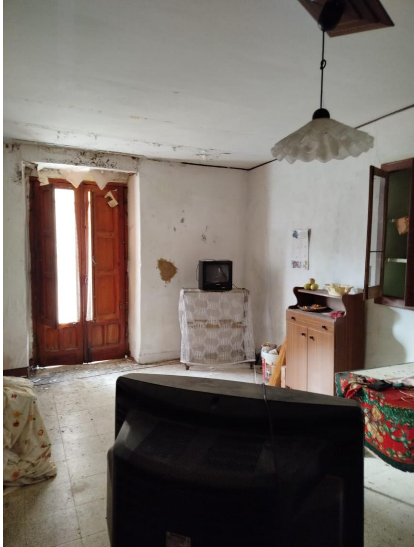
Foto 9 – piano primo (foglio 130 particella 1911 sub. 1)
