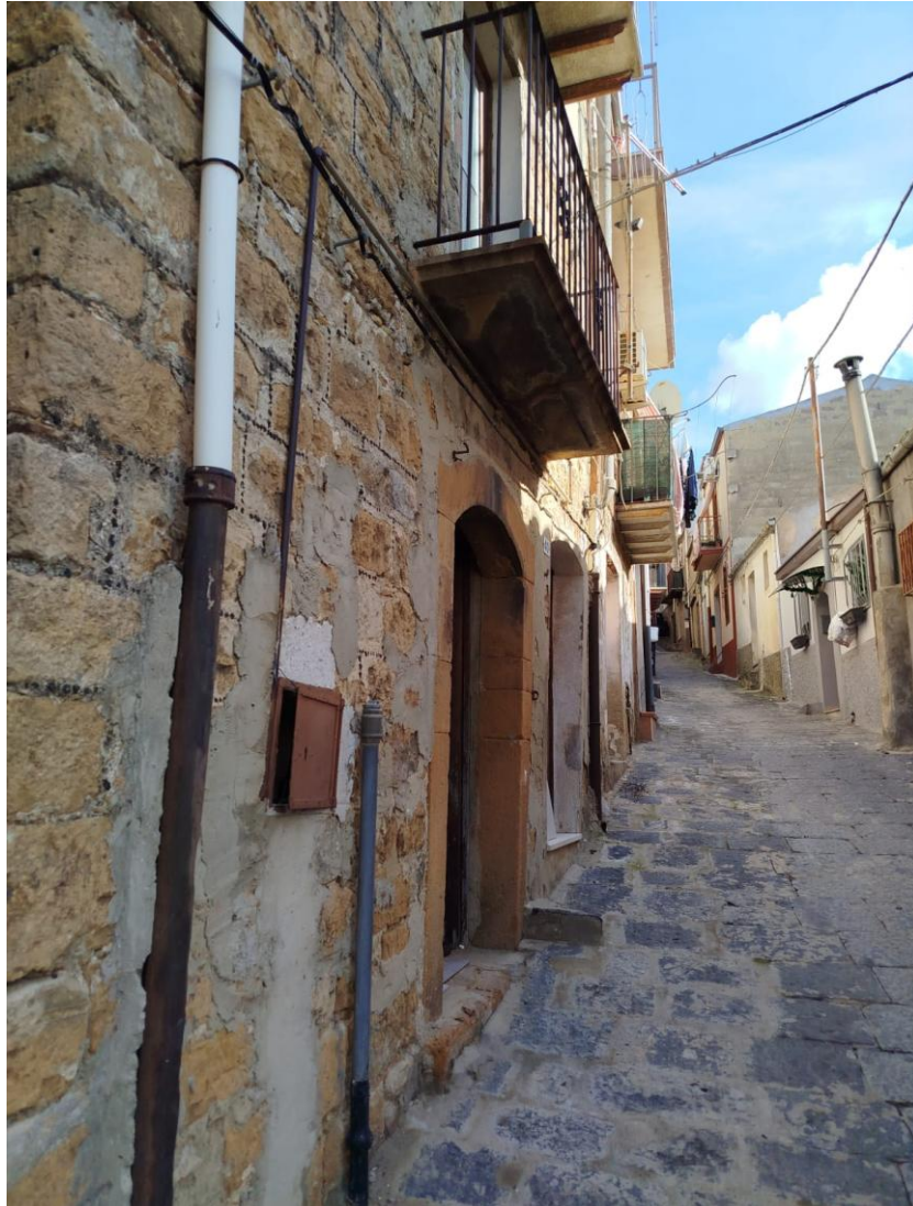
Foto 2 – esterno (foglio 130 particella 1911 sub. 1)
