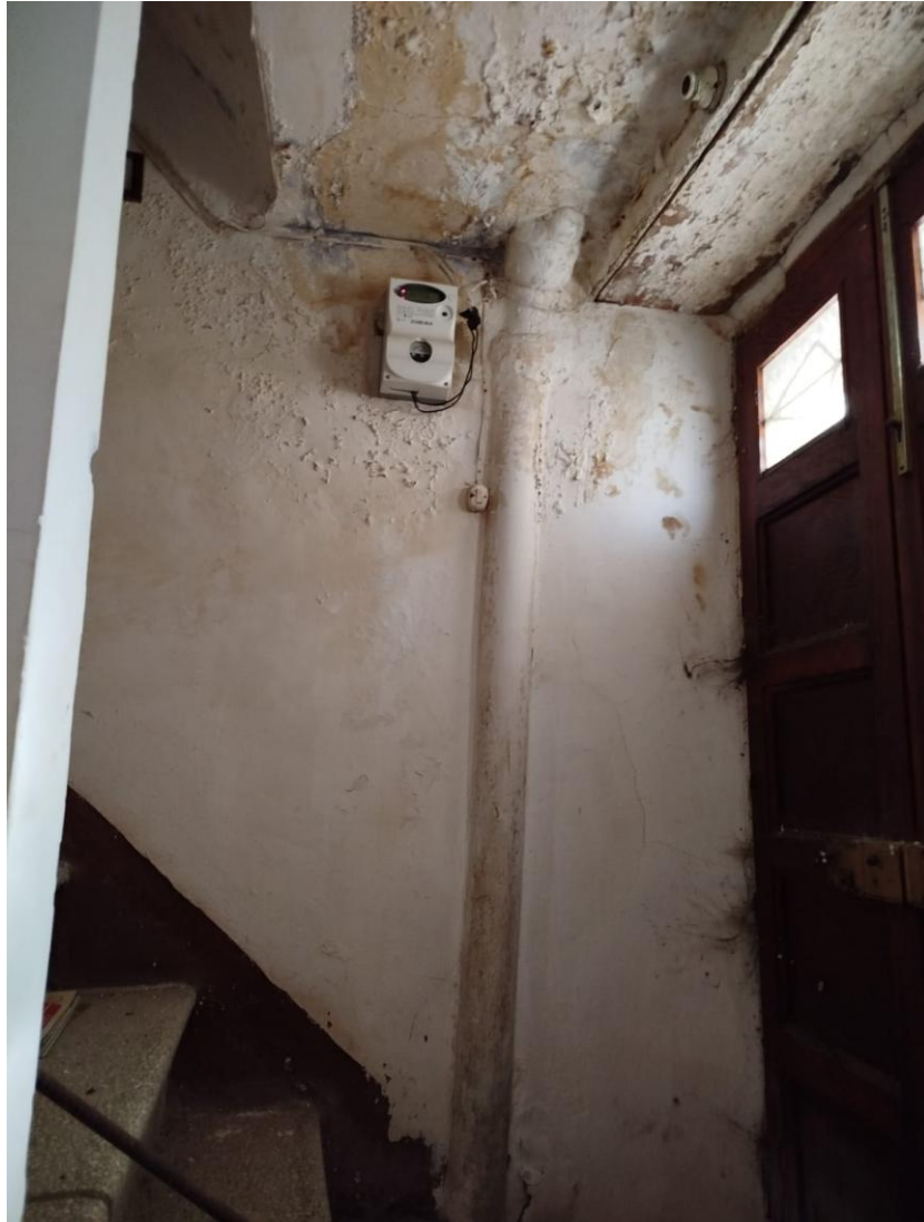
Foto 7 – vano scala (foglio 130 particella 1911 sub. 1)
