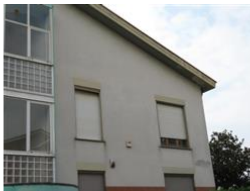
vista esterna dell'edificio - dettaglio
