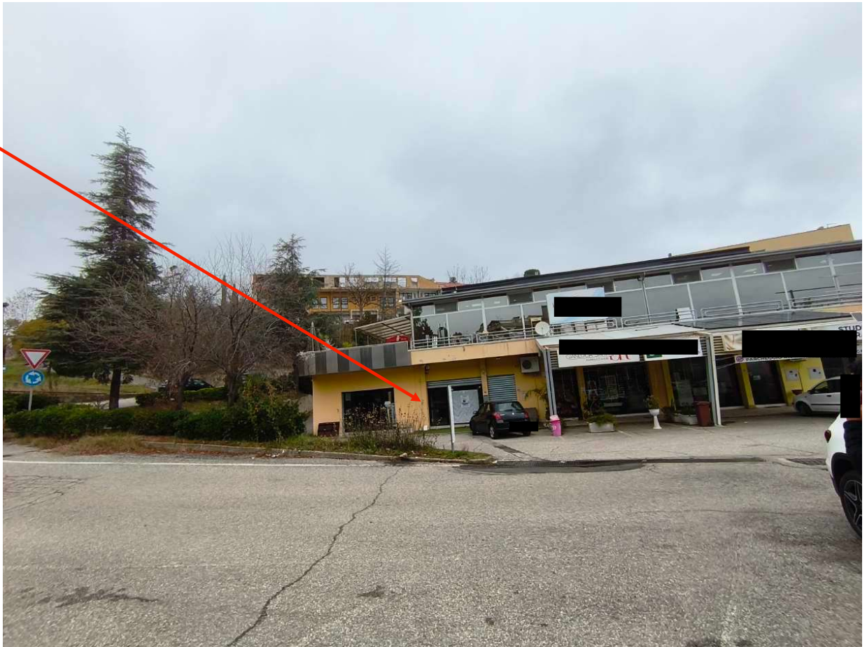
Foto n. 5: Immobile pignorato – prospetto principale
