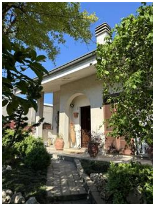
Villa bifamiliare - Edificio B
