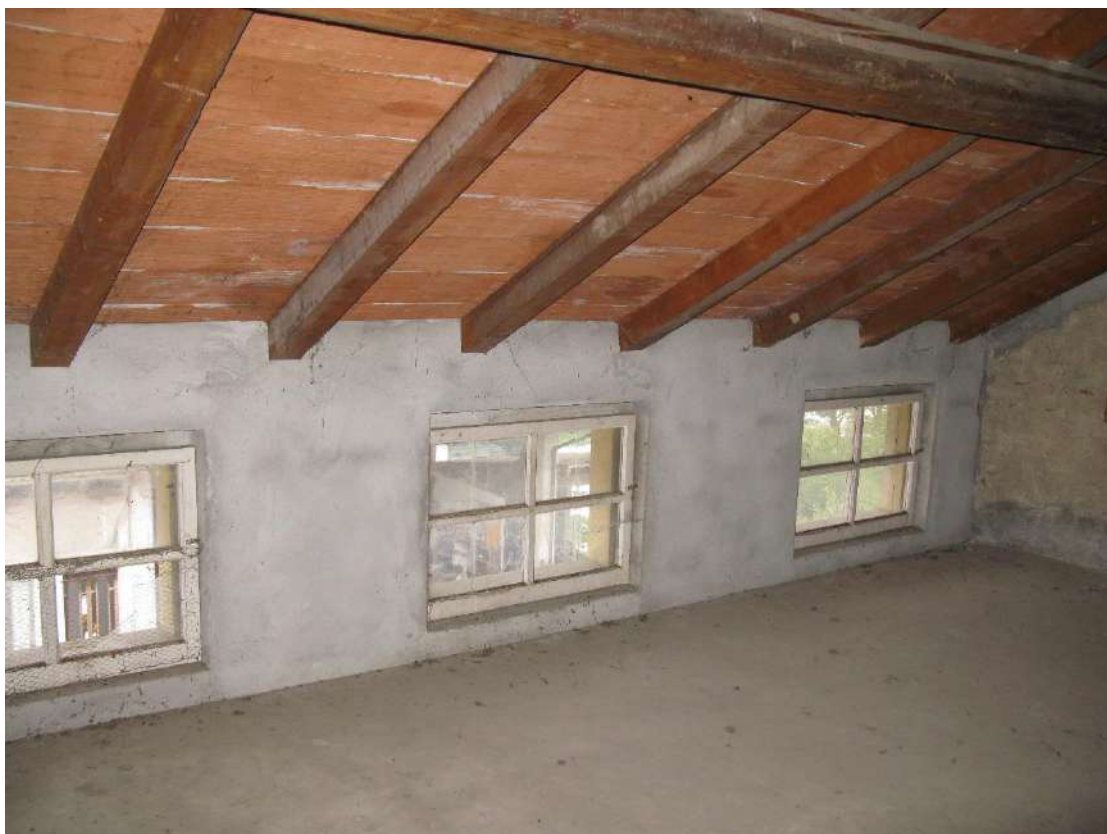
Foto 33 – Soffitta al piano secondo – Bene 2
