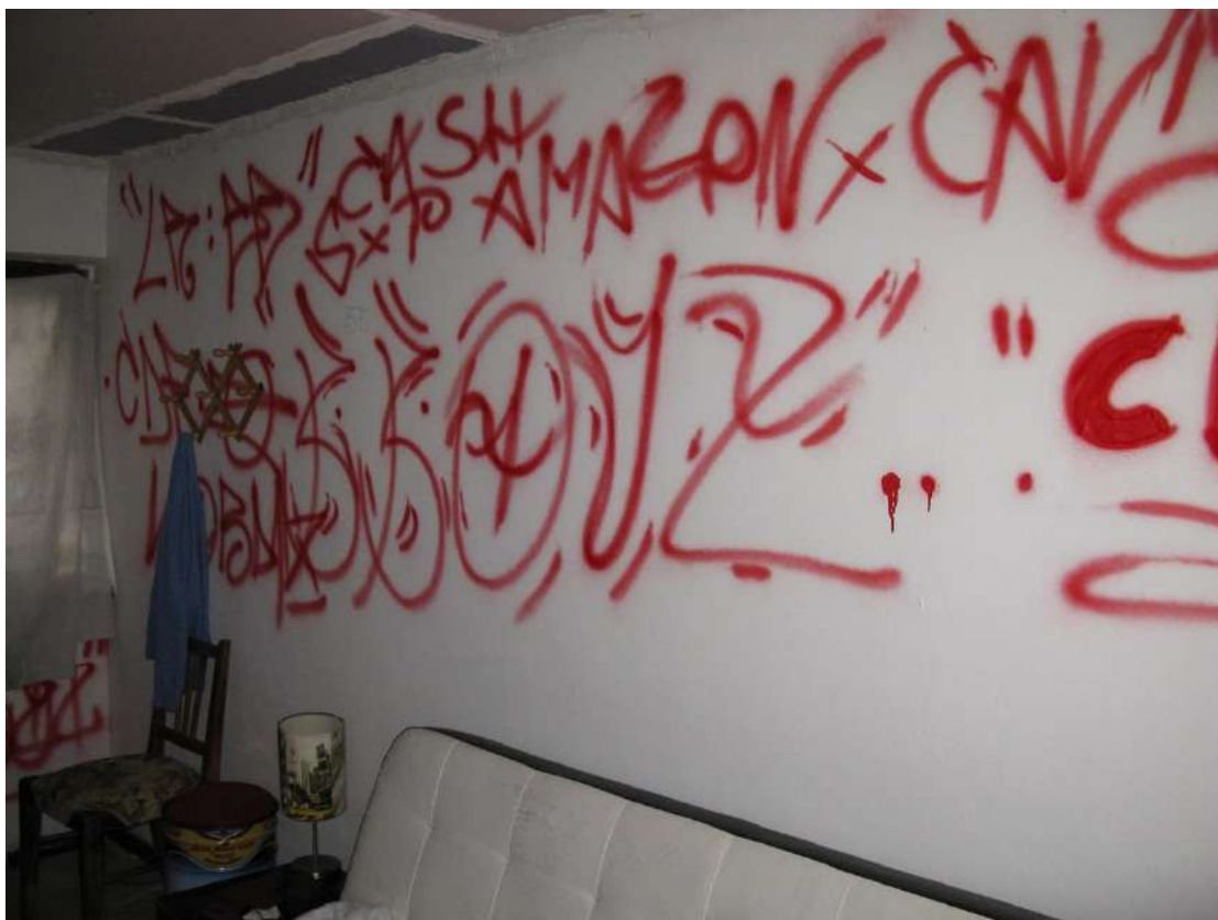
Foto 49 – Locale ufficio al piano terreno non autorizzato – Bene 4
