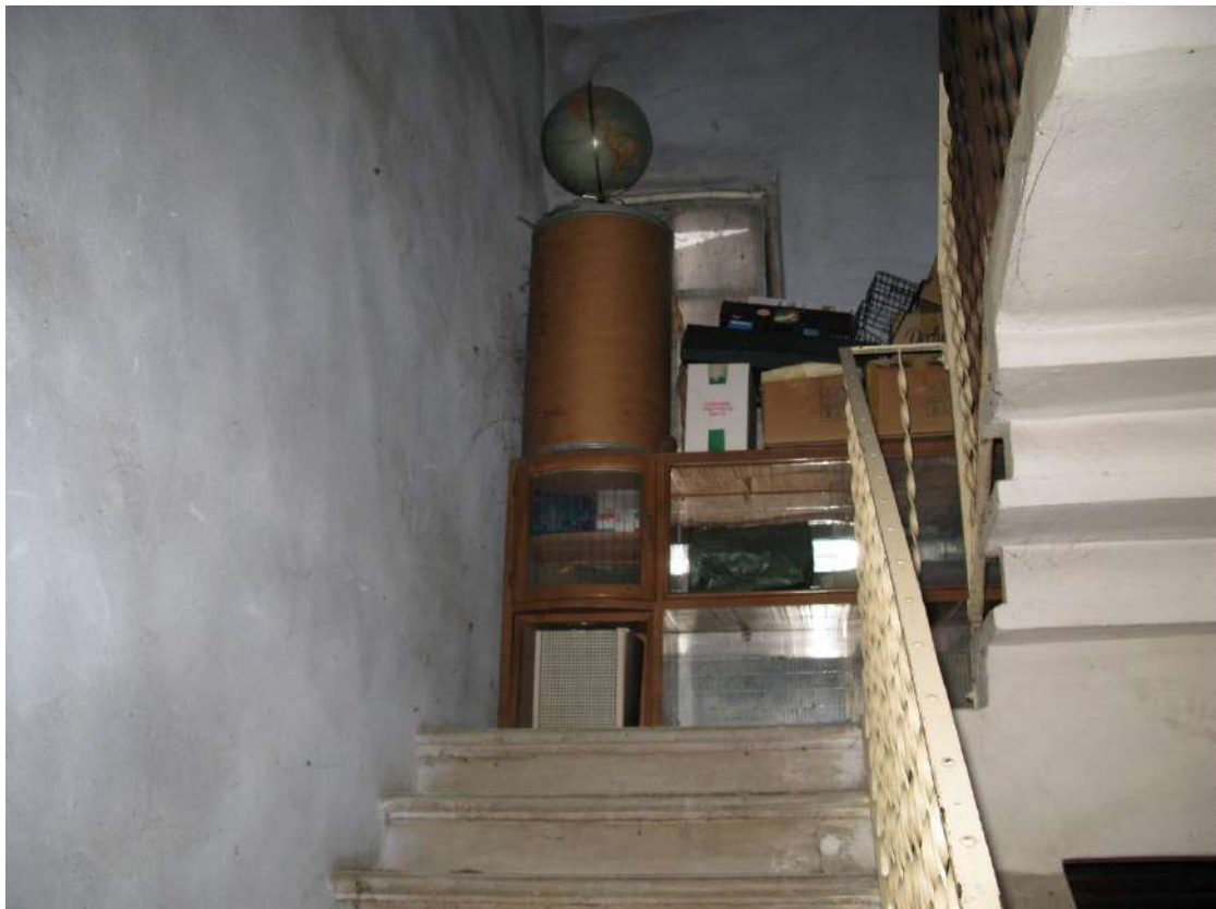
Foto 28 – Vano scala di accesso al piano secondo (soffitta) - Bene 2
