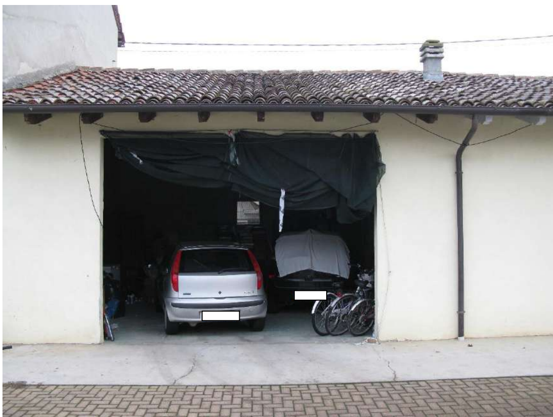
Foto 52 – Garage al piano terreno – Bene 5
