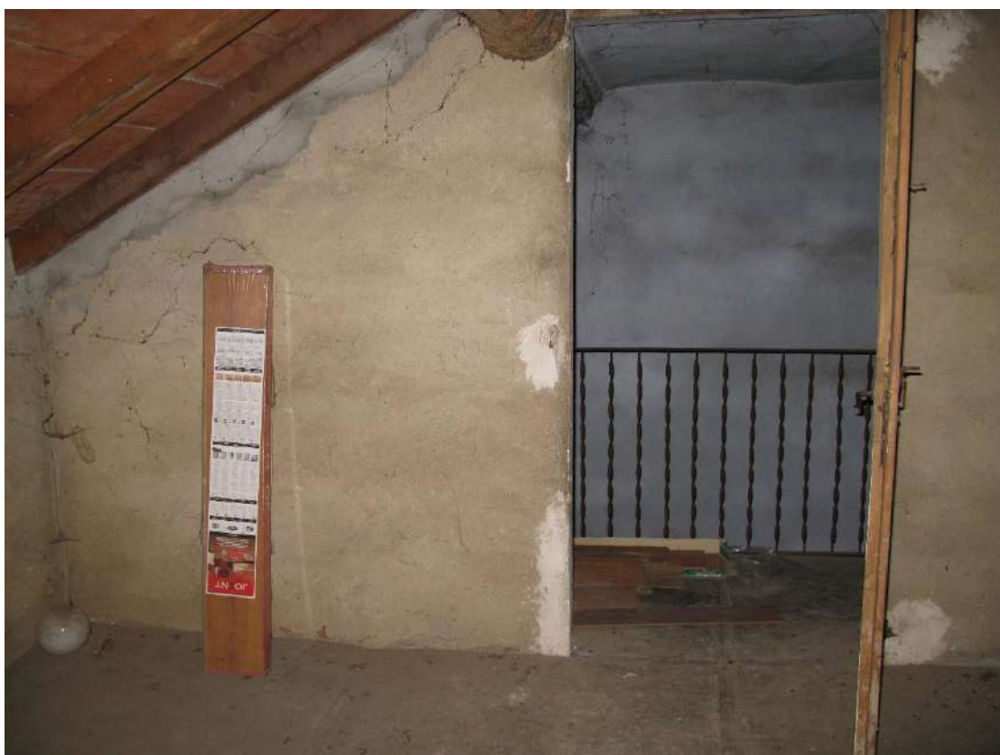
Foto 30 – Soffitta al piano secondo – Bene 2
