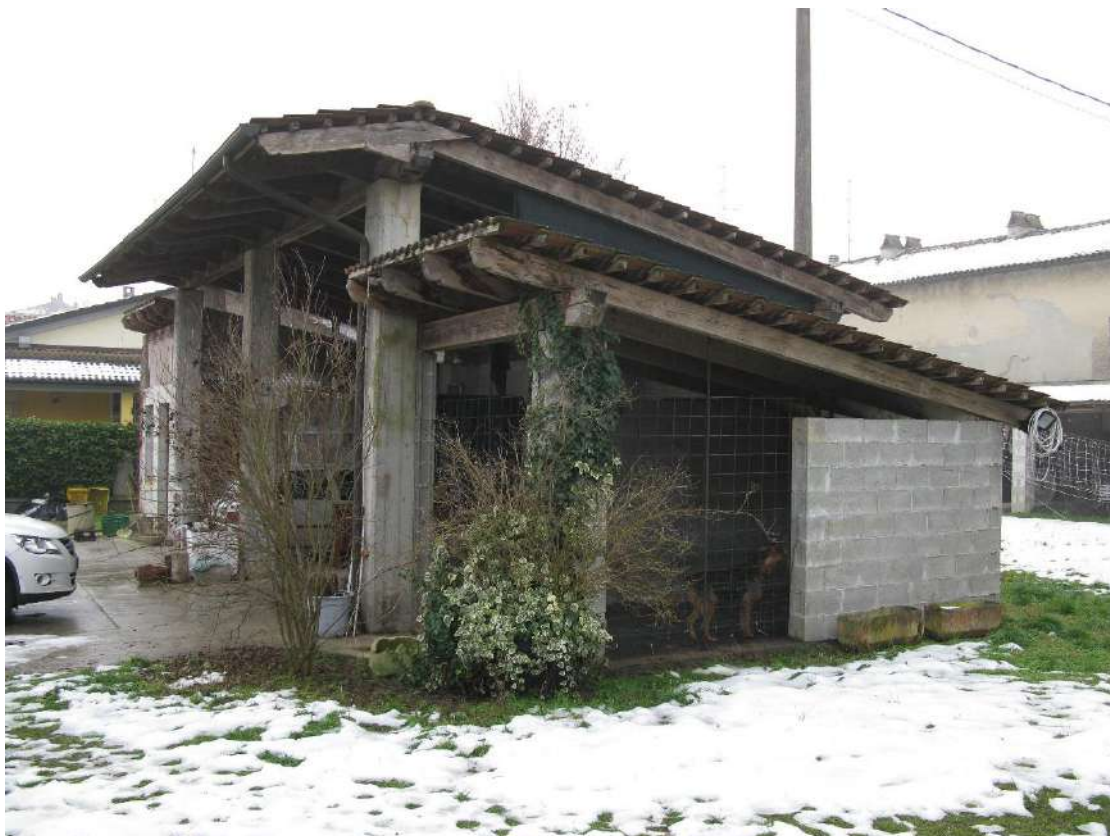
Foto 41 – Tettoie al piano terreno, parte bassa abusiva – Bene 4
