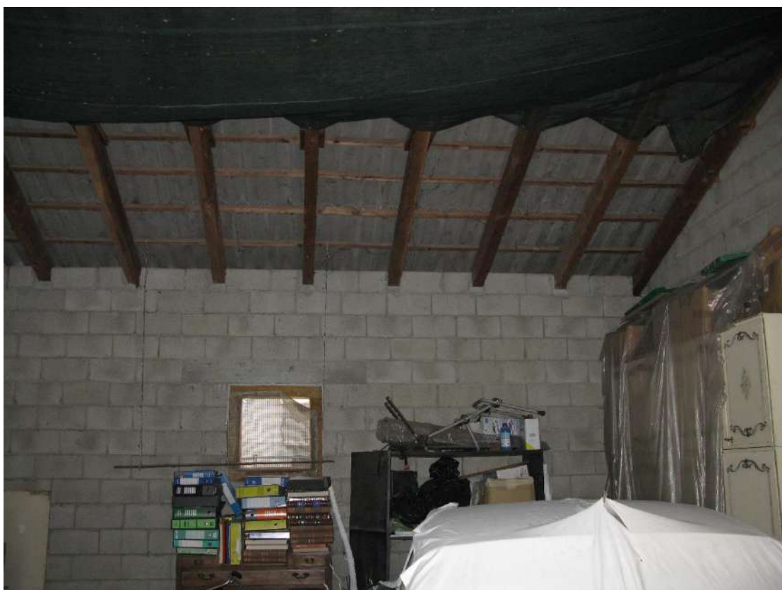
Foto 56 – Garage al piano terreno – Bene 5
