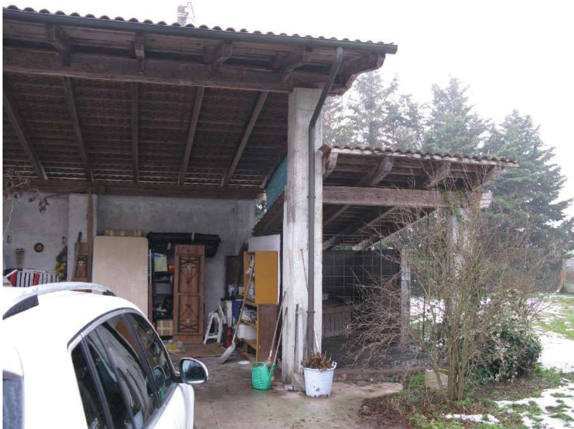
Foto 39 – Tettoie al piano terreno, parte bassa a destra abusiva – Bene 4
