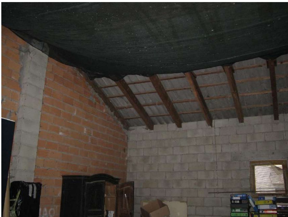
Foto 55 – Garage al piano terreno – Bene 5
