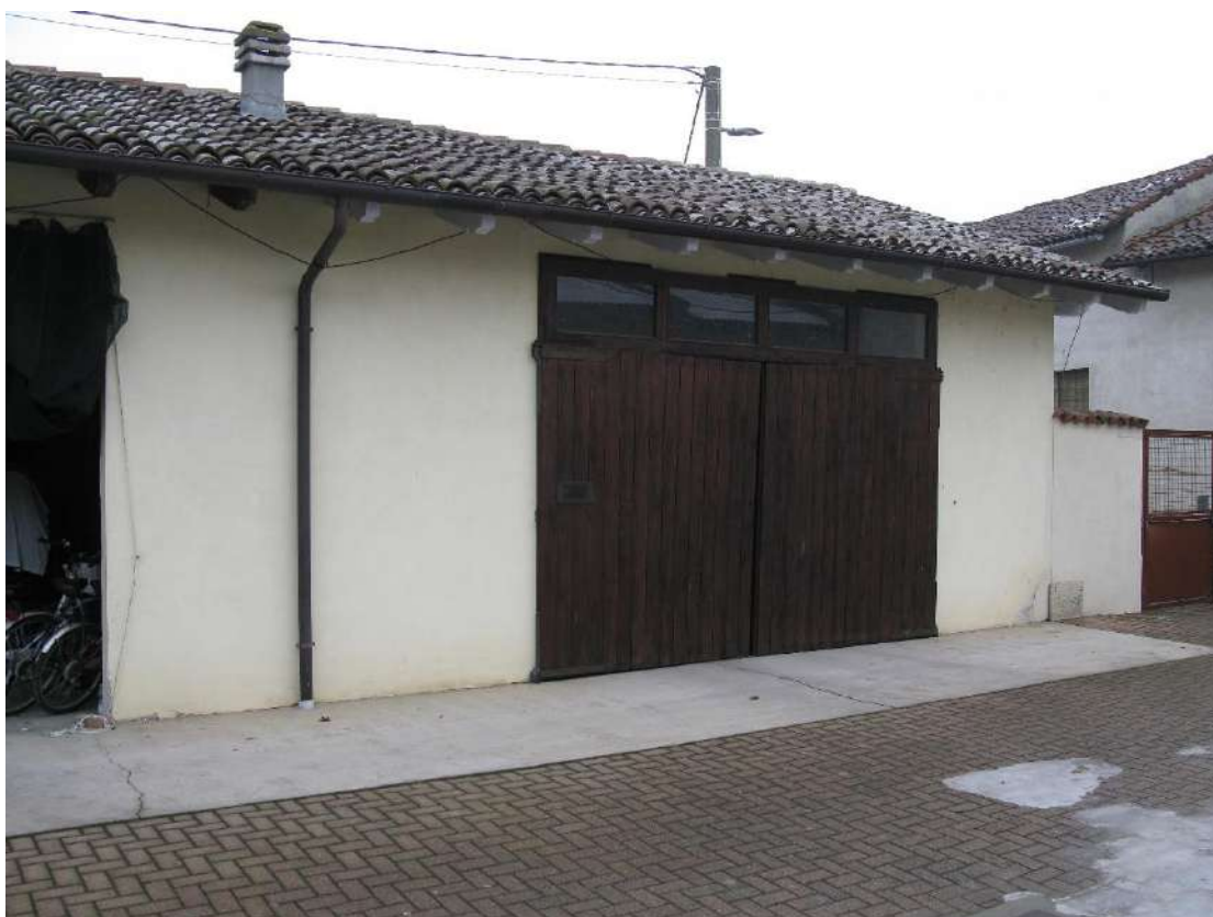
Foto 54 – Garage al piano terreno – Bene 5
