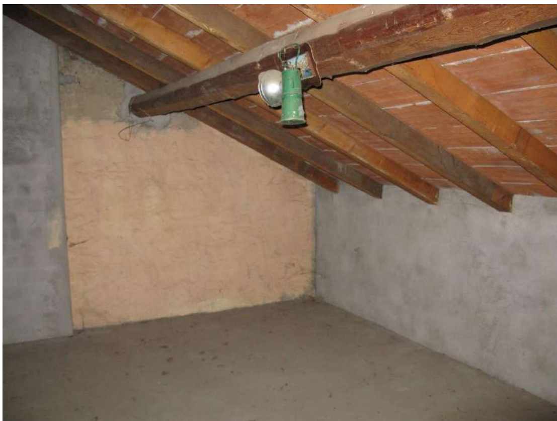
Foto 31 – Soffitta al piano secondo – Bene 2
