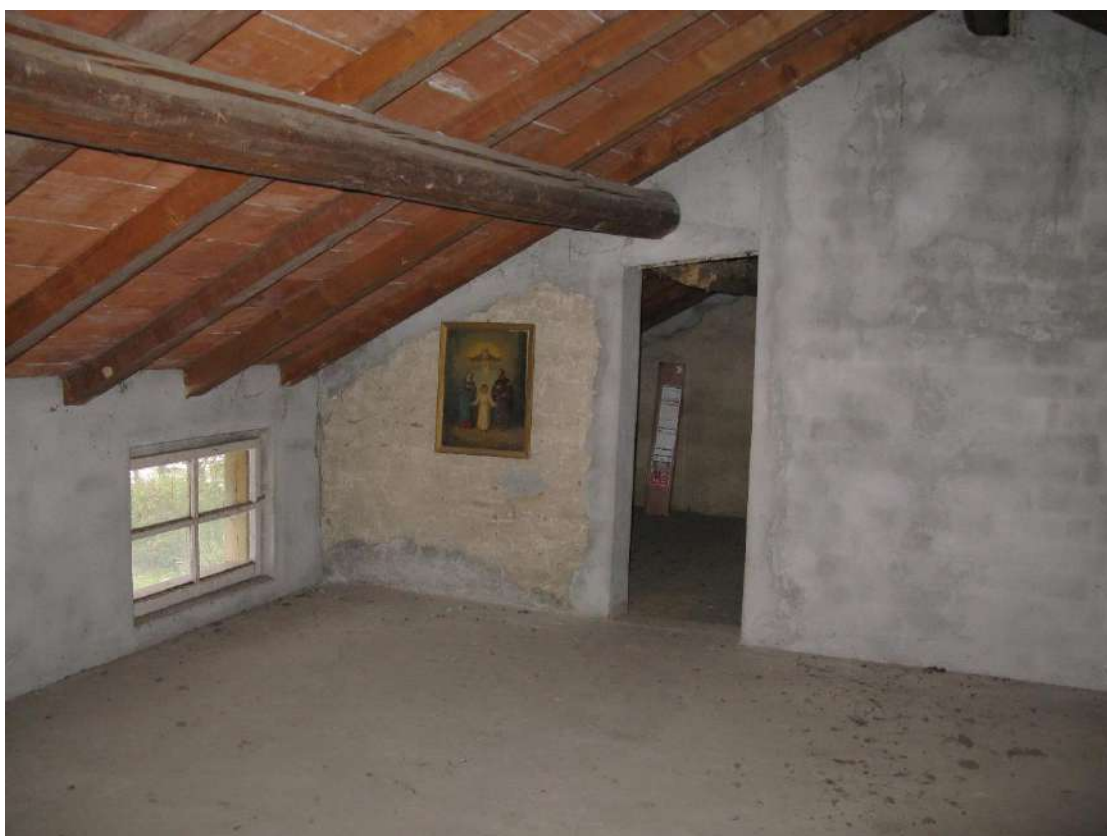
Foto 32 – Soffitta al piano secondo – Bene 2
