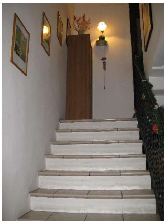
Foto 18 – Scala di accesso al piano primo – Bene 2
