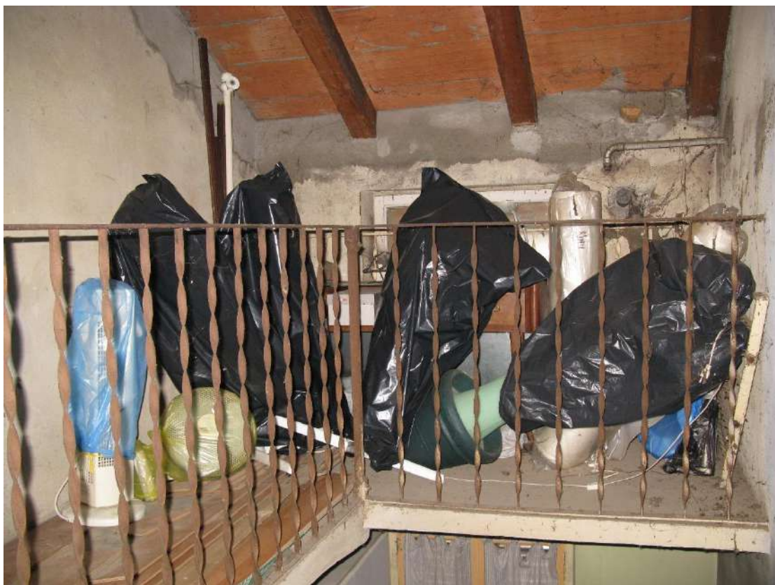
Foto 29 – Soffitta al piano secondo – Bene 2
