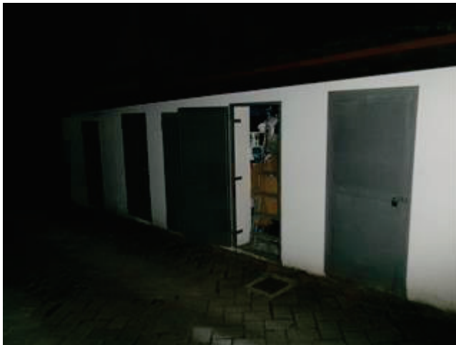
ingresso del deposito di pertinenza
