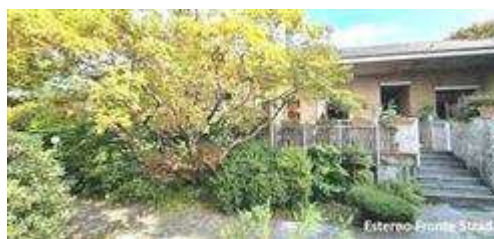
Esterno fronte strada
