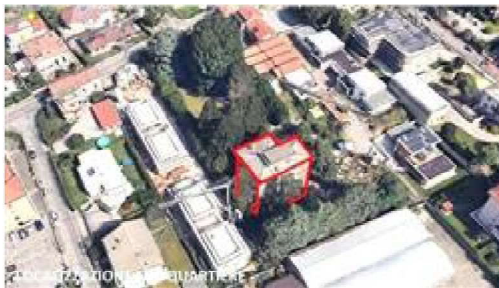
Localizzazione aerea nel quartiere
