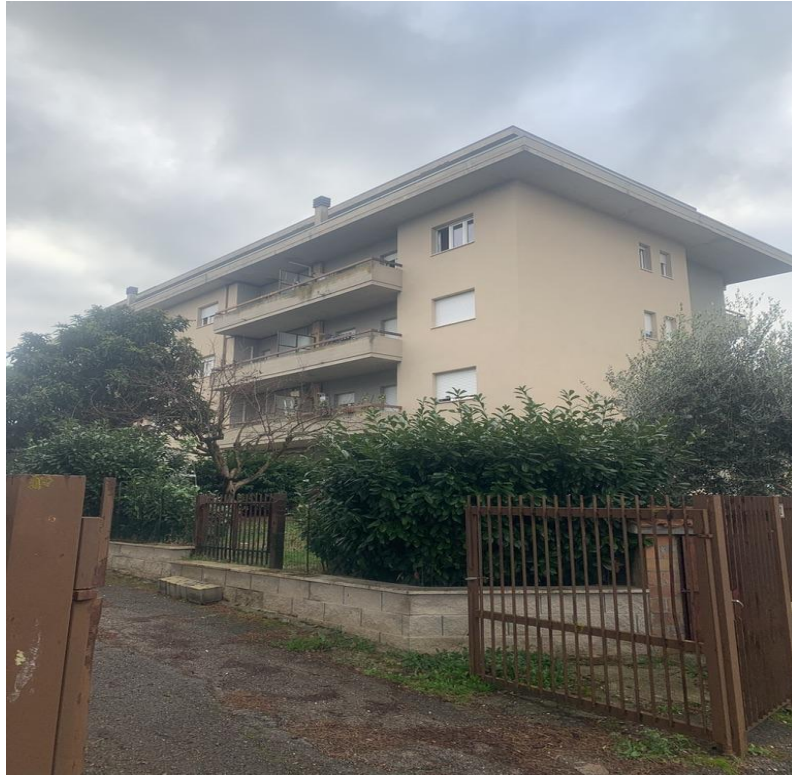
Foto n° 1 – palazzina condom. Di via Liguria, 2
