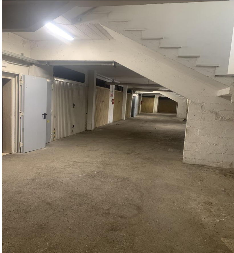
Foto n° 15 - Corsia dei garages
