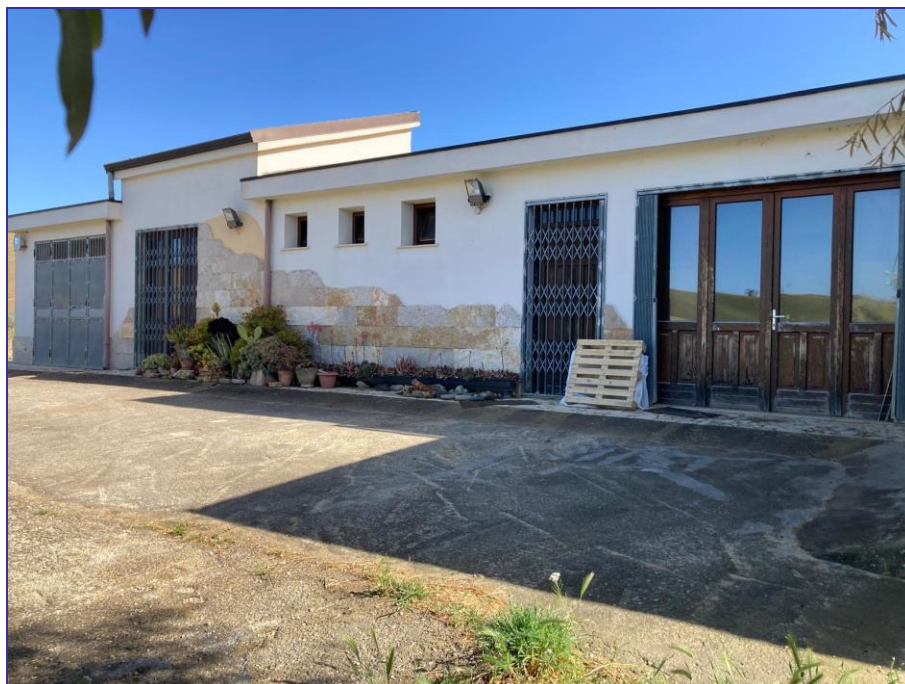
Foto 13 – Imm. 1 - Prospetto principale fabbricato su di una elevazione.
