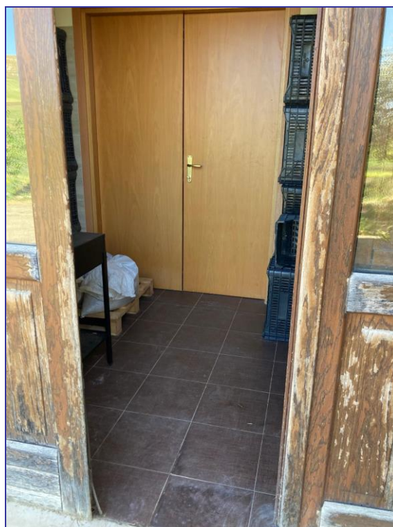
Foto 17 – Imm.1 – Vano ingresso prodotto.
