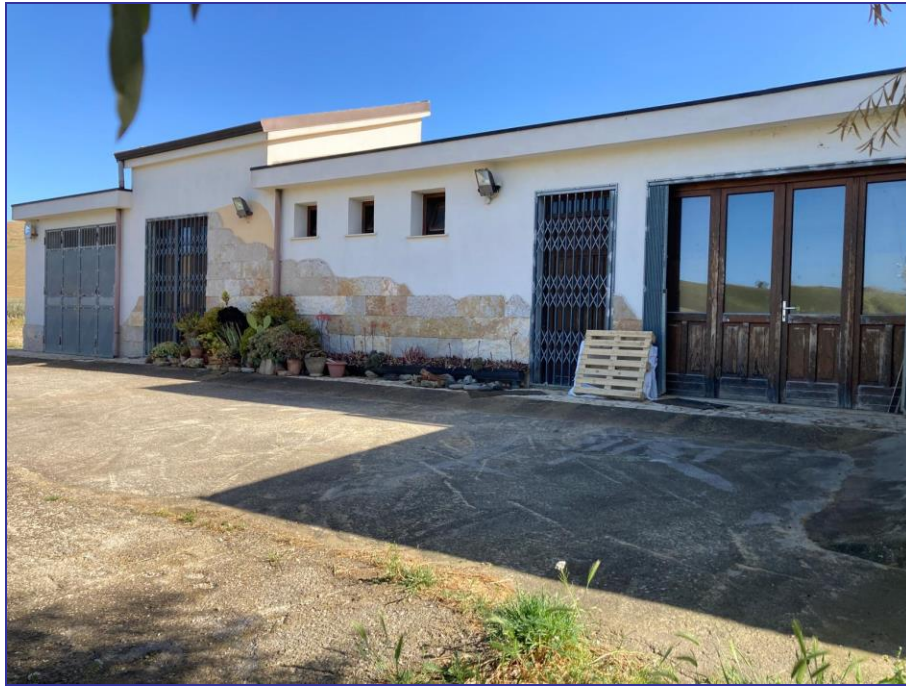
Foto 9 – Imm. 3 – Altra vista della corte esterna lungo il prospetto principale.
