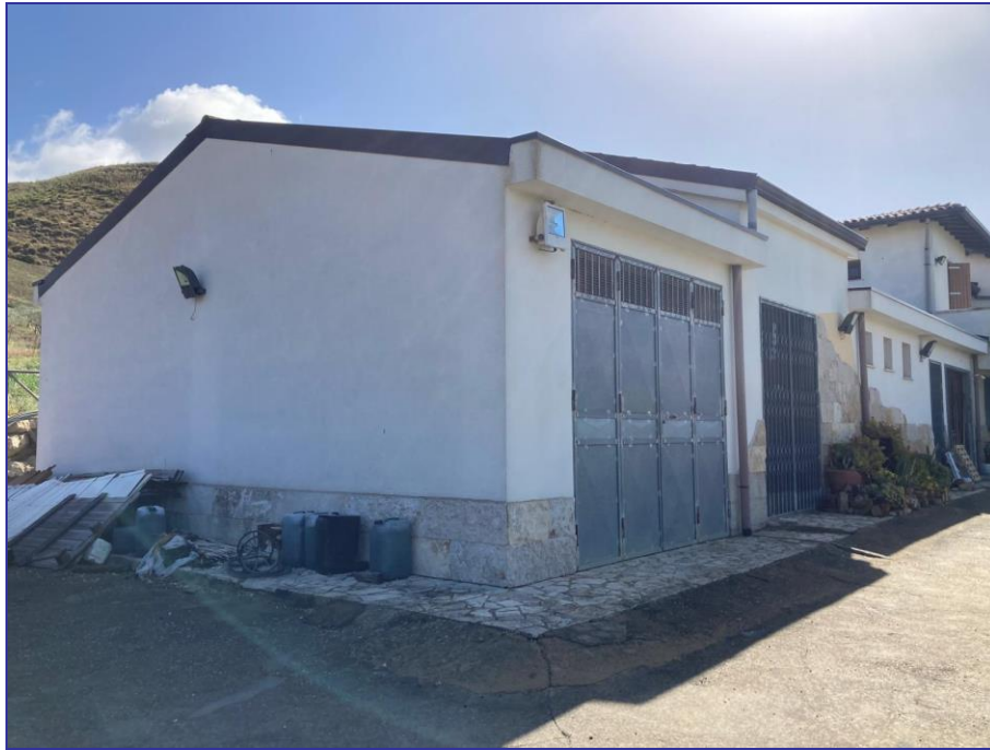
Foto 14 – Imm. 1 - Prospetto laterale fabbricato su di una elevazione.
