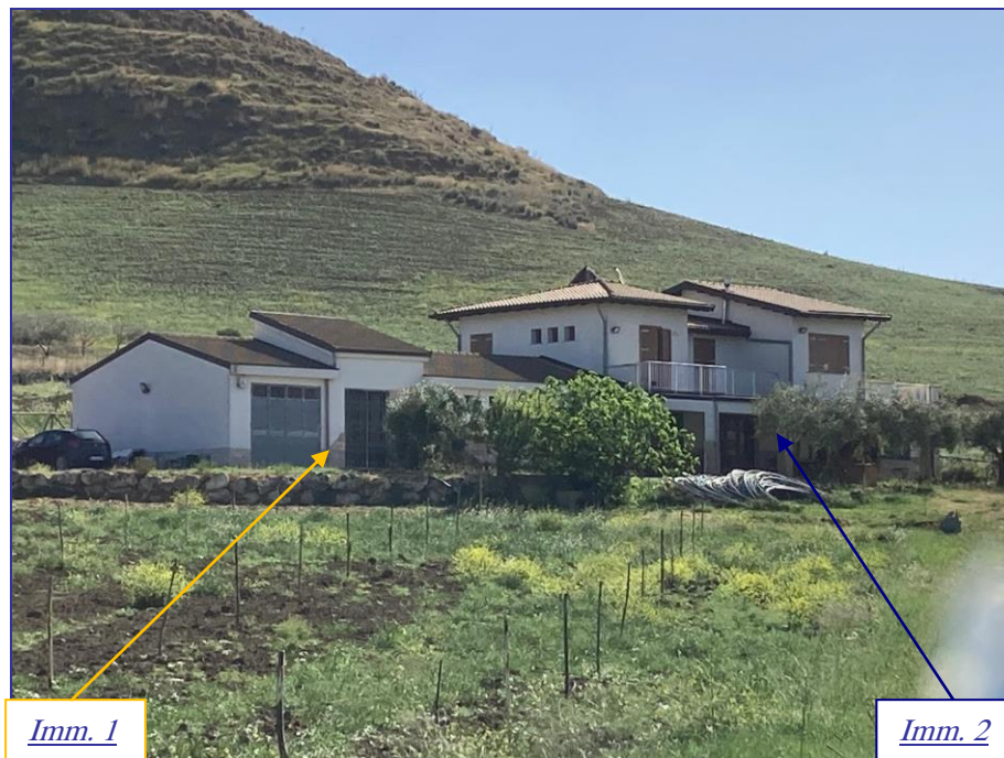
Foto 12 – Imm. 1 e 2 – Vista complessiva degli immobili Imm. 1 e Imm. 2 , lungo il prospetto principale.
