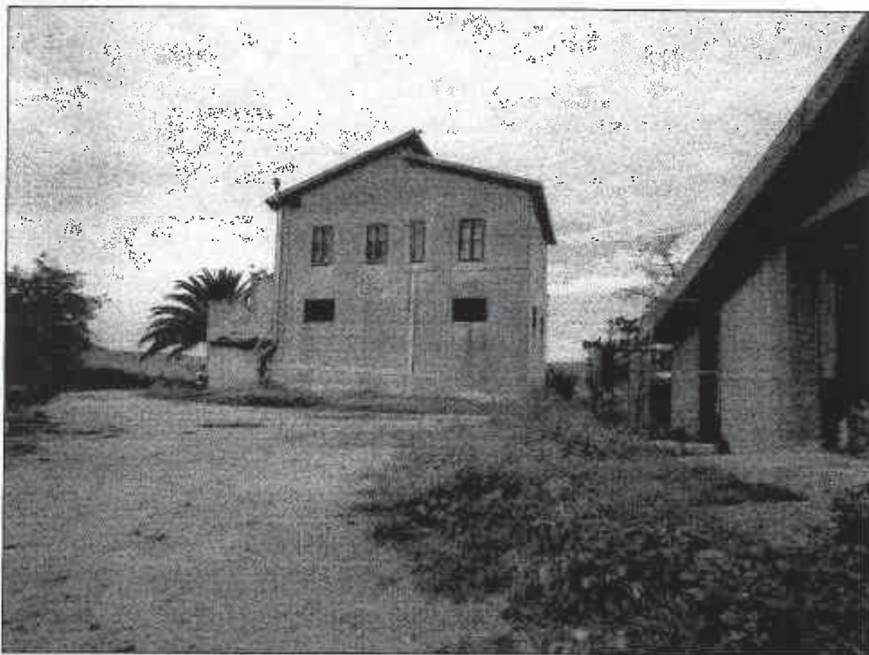
FOTO 2 - ABITAZIONE IN C.DA GAITO. IL RETRO.
