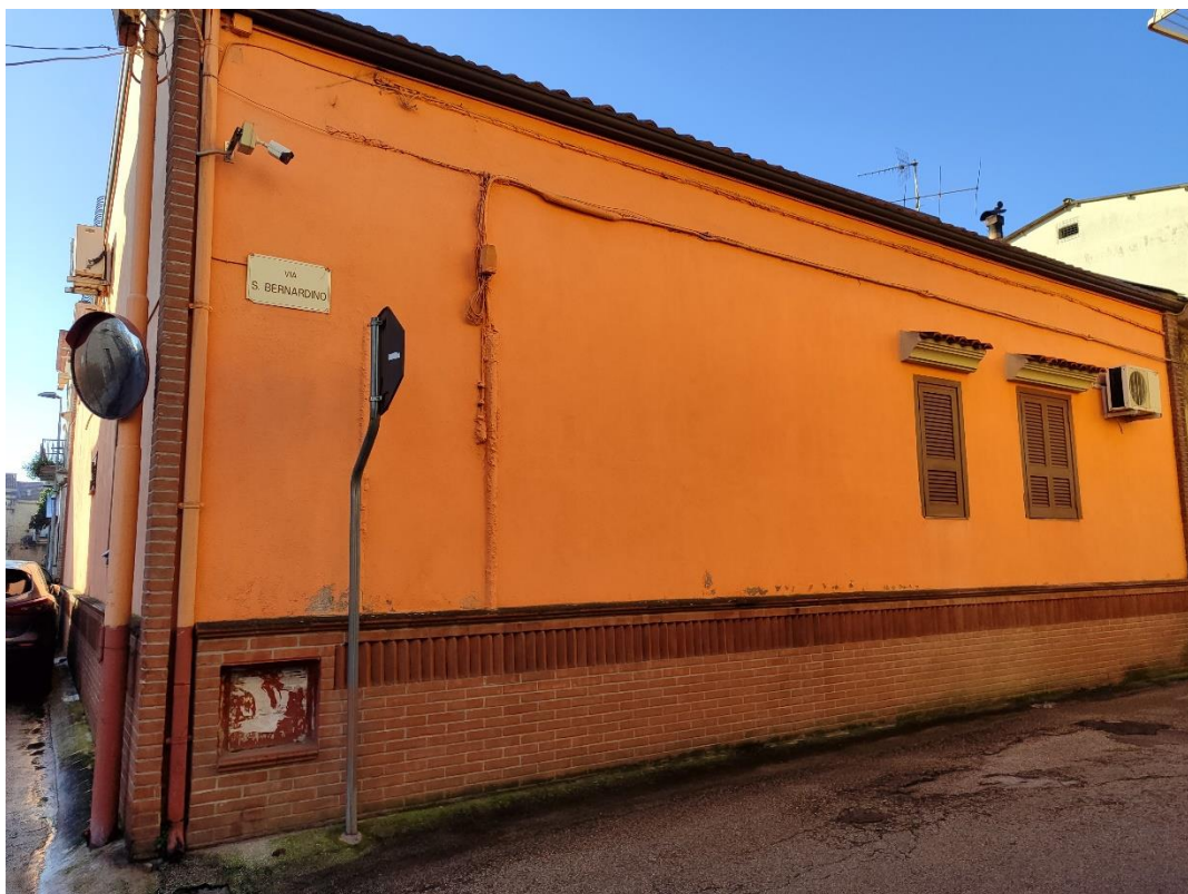
Vista facciata nord da via San Bernardino
