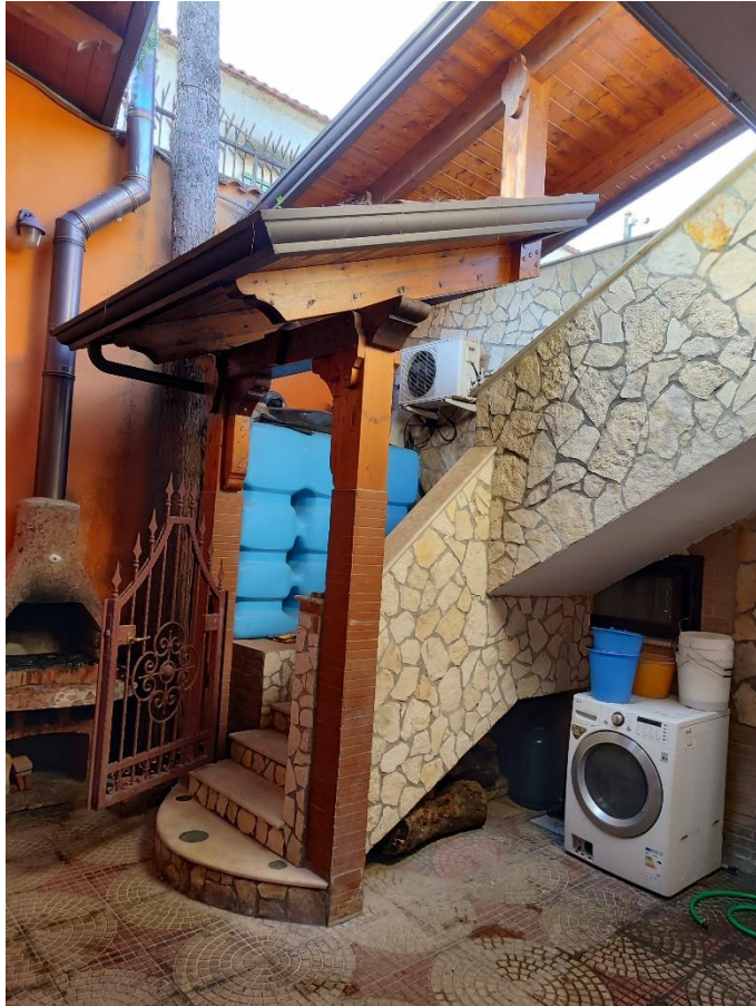
Vista scala accesso al terrazzo dalla corte interna
