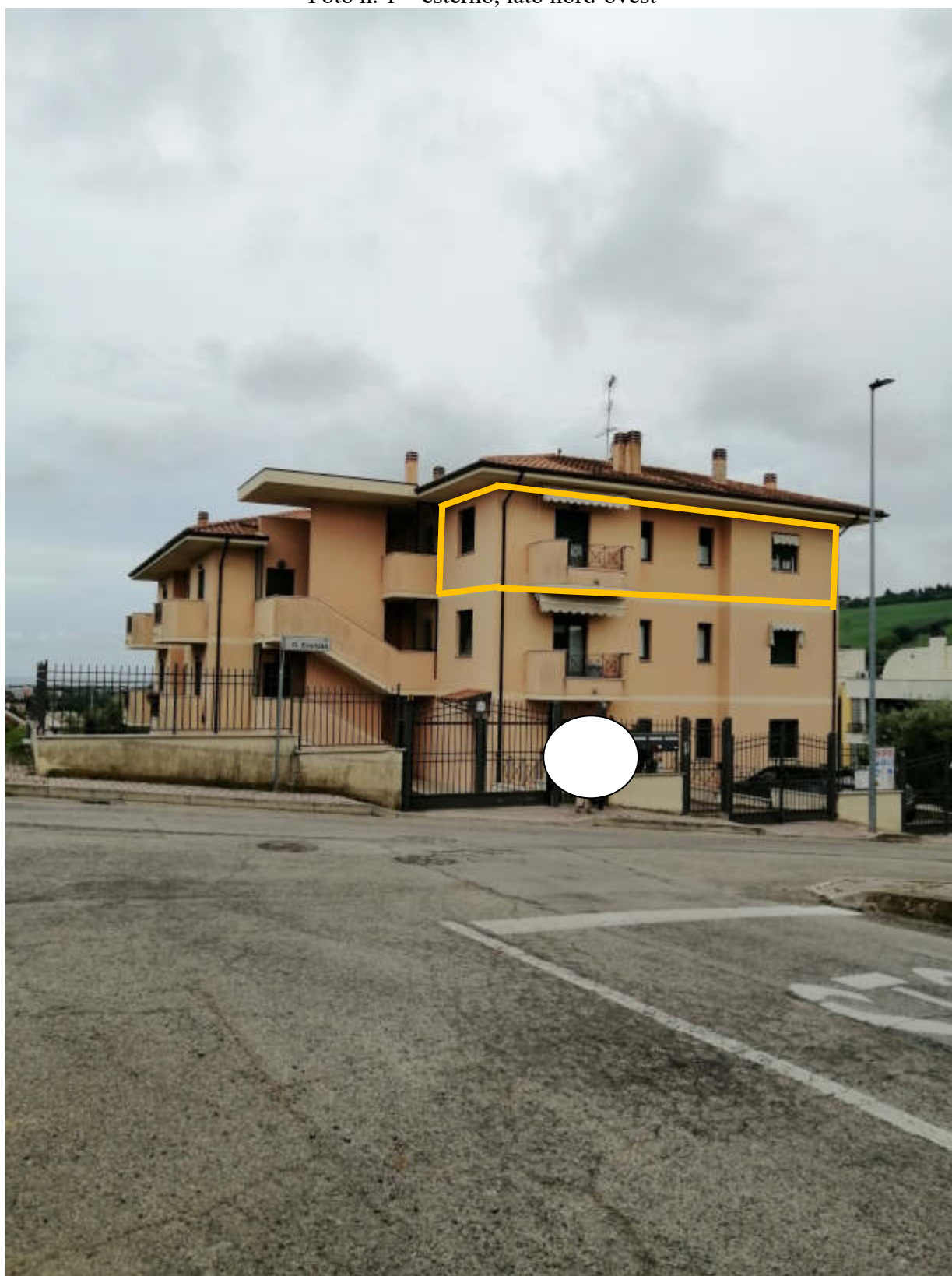
Foto n. 1 – esterno, lato nord-ovest
