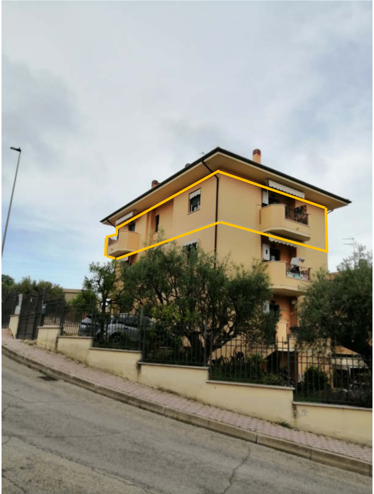
Foto n. 2 – esterno, lati nord-ovest e sud-ovest
