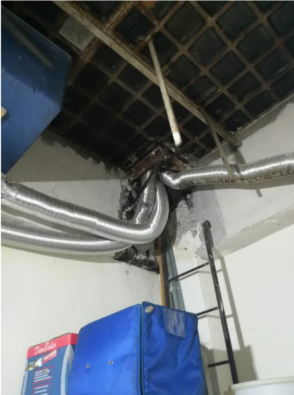
Foto n. 7 : dettaglio della copertura a vetri della chiostrina;
