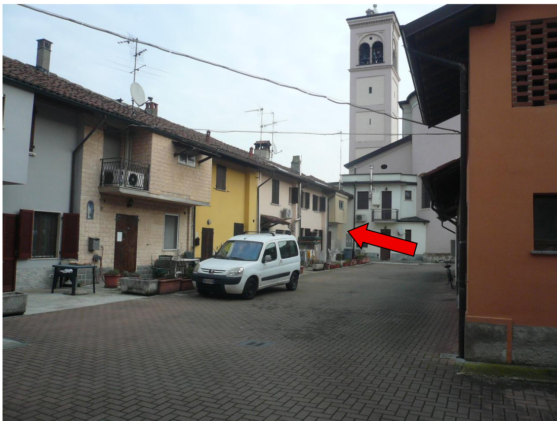
Figura 3 - Vista del fabbricato dal cortile comune
