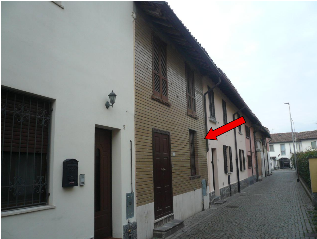
Figura 5 - Vista del fabbricato e dell'accesso pedonale da via Cappelletti
