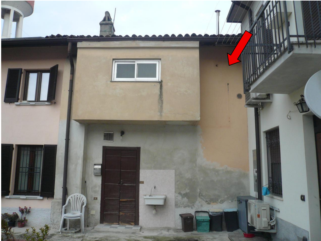
Figura 1 - Vista del fabbricato dal cortile comune
