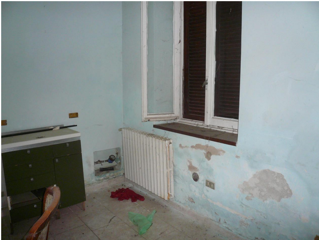
Figura 13 - Particolare dei locali al piano terra
