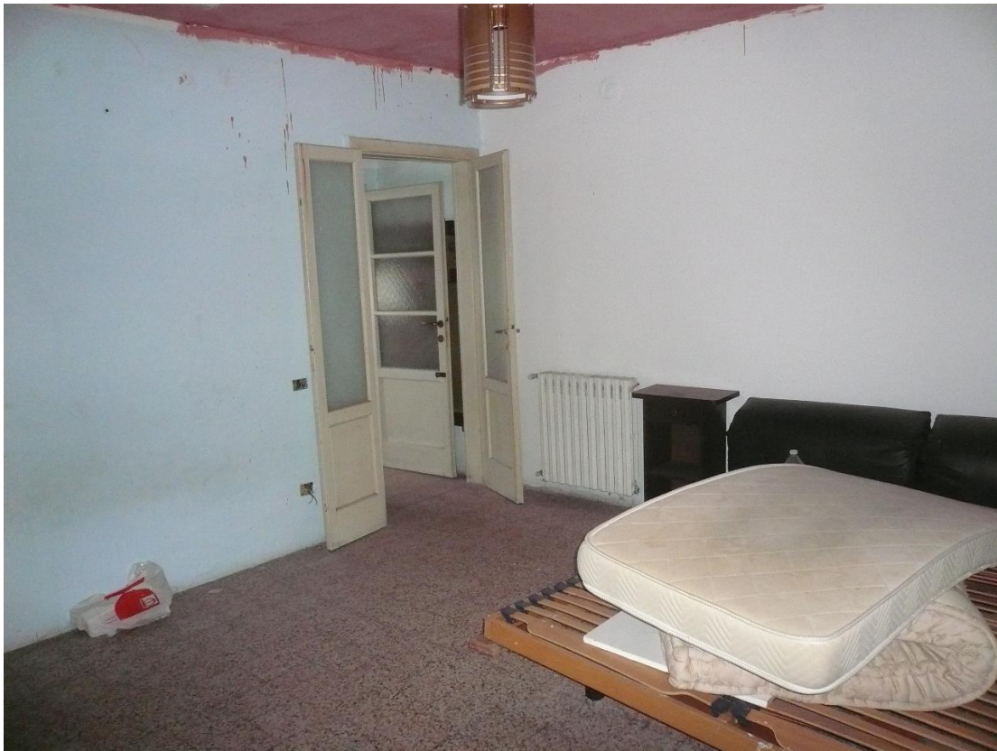
Figura 7 - Particolare del locale al piano primo
