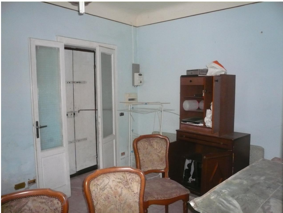
Figura 12 - Particolare dei locali al piano terra
