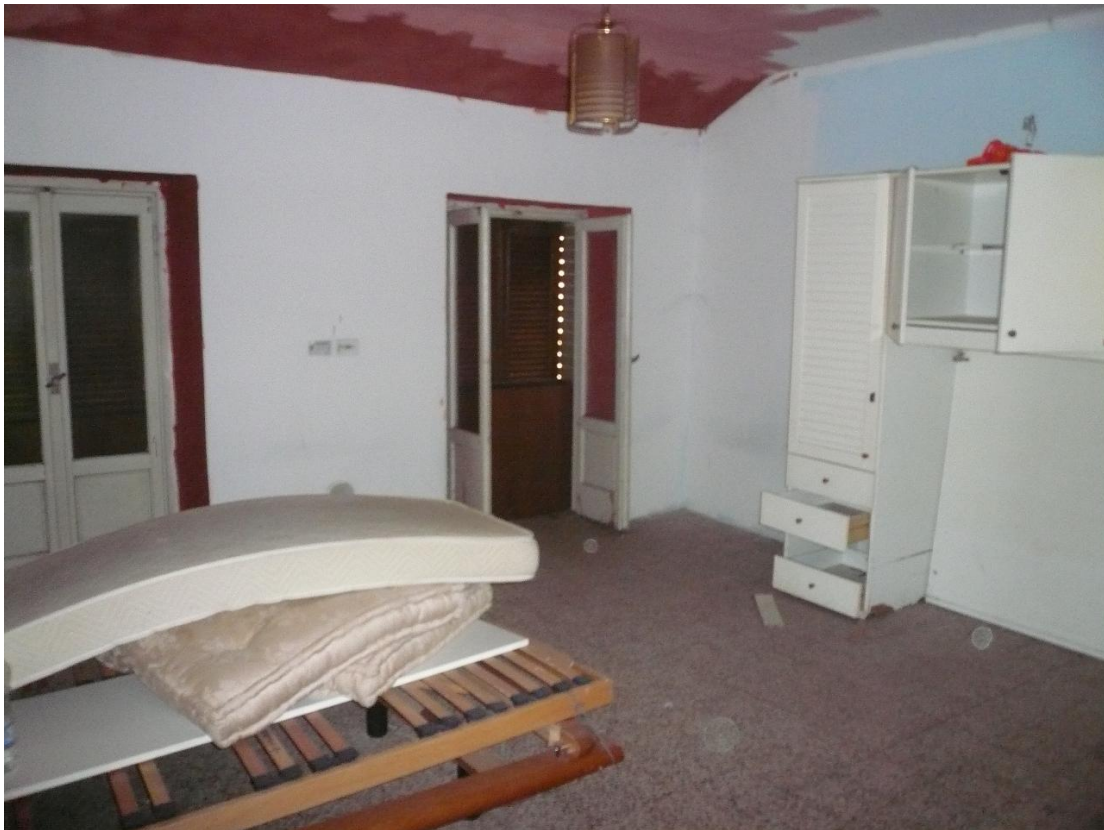
Figura 6 - Particolare del locale al piano primo
