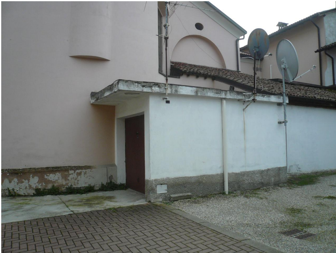
Figura 15 - Vista dal cortile comune del locale autorimessa
