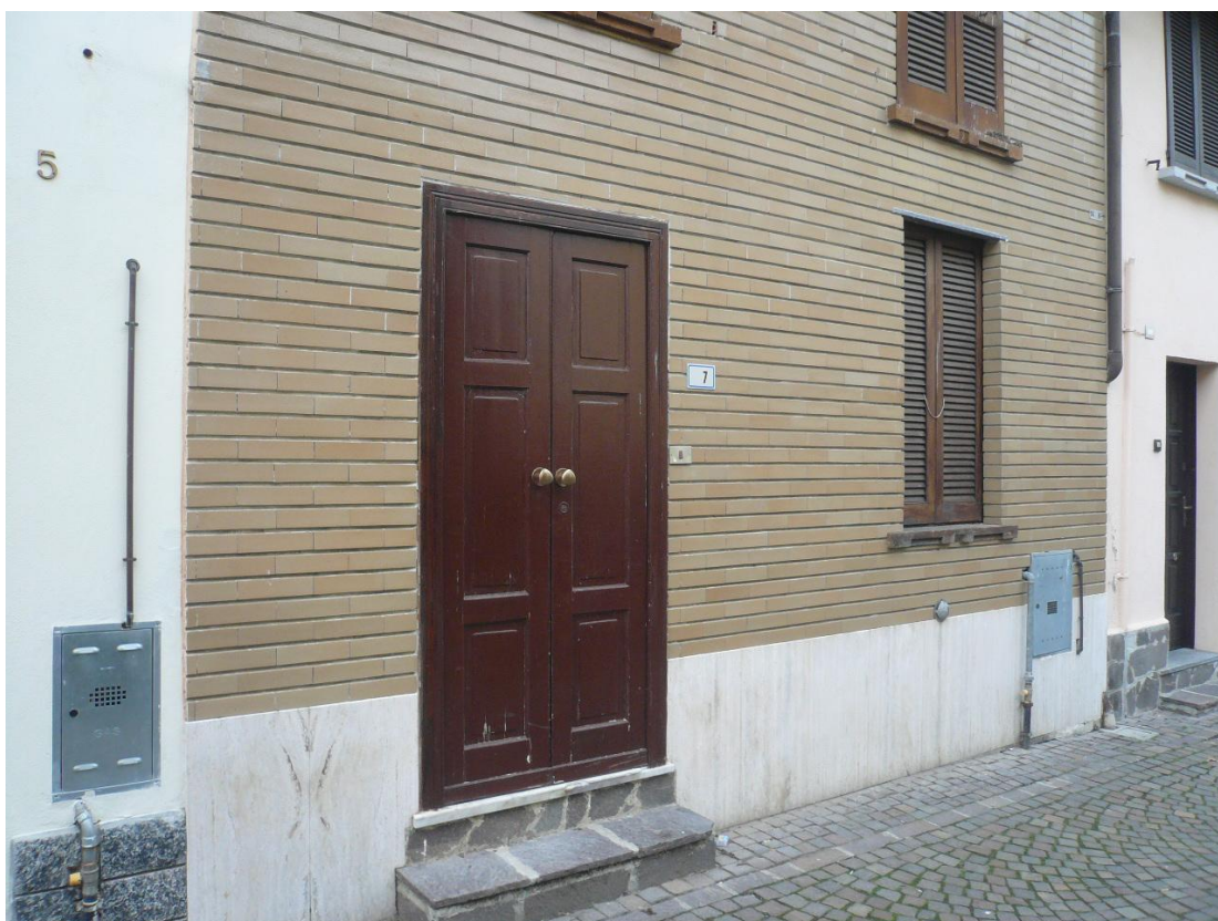
Figura 4 - Vista del fabbricato e dell'accesso pedonale da via Cappelletti
