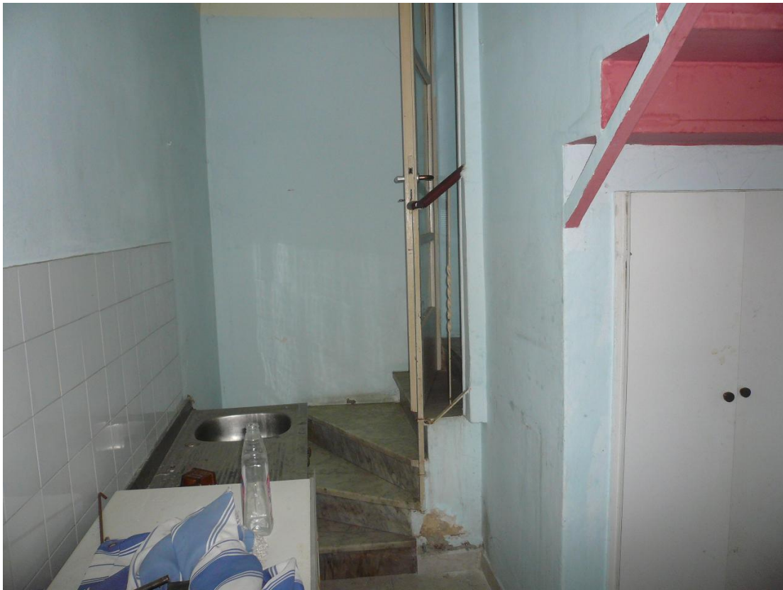
Figura 11 - Particolare dei locali al piano terra
