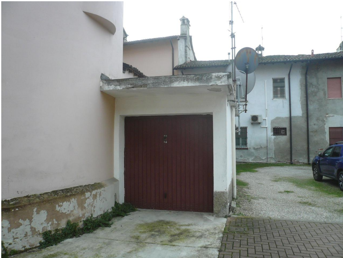
Figura 14 - Vista dal cortile comune del locale autorimessa
