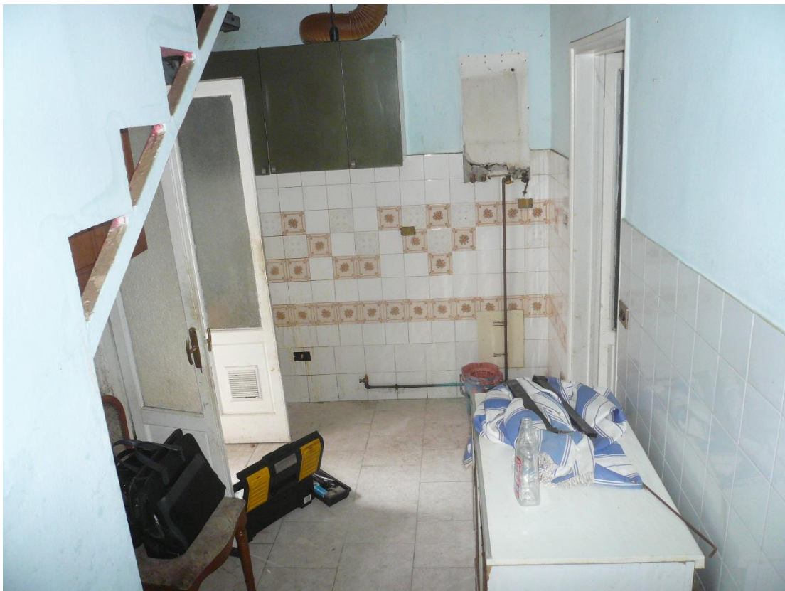
Figura 10 - Particolare dei locali al piano terra
