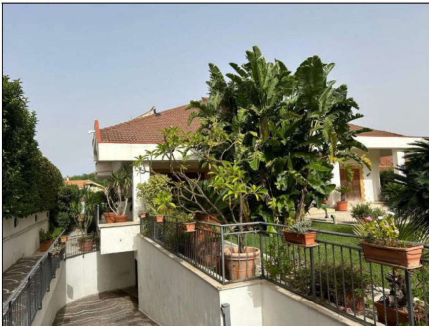
Ripresa d'insieme della villa unitamente agli spazi esterni (rampa che serve il p.seminterrato/camminamenti esterni laterali)
