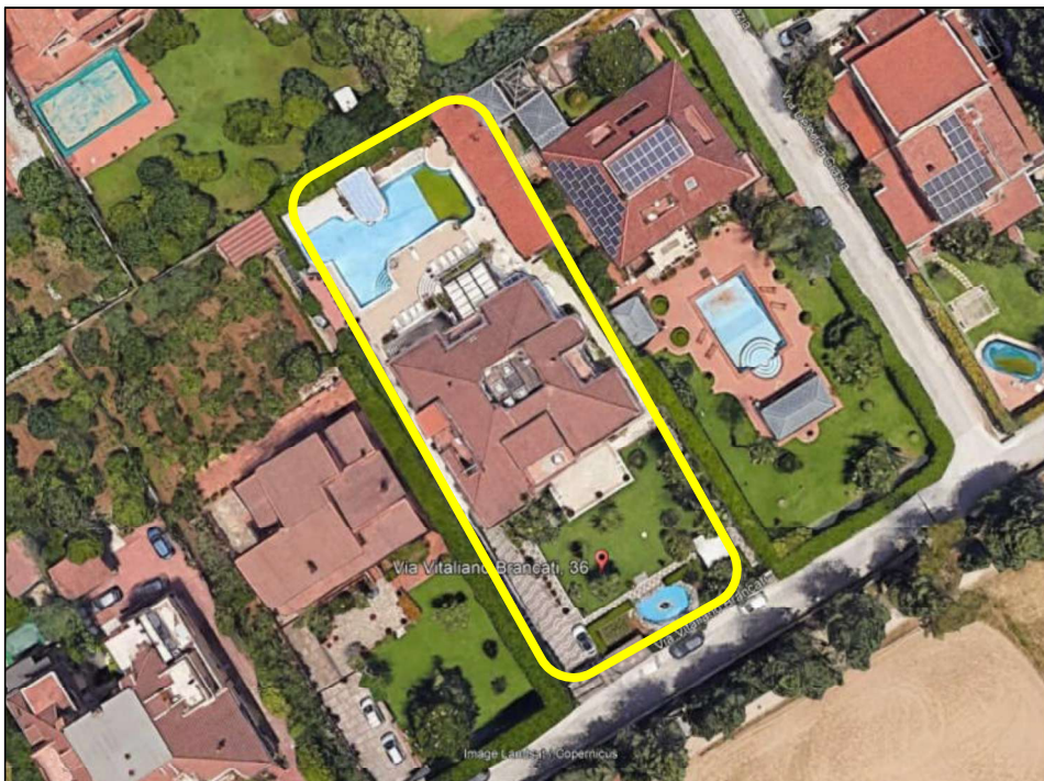
Stralcio Google – Earth con la marcatura, con tratto continuo di colore giallo, afferente al compendio immobiliare oggetto di stima
