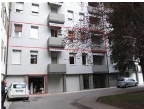
Veduta garage e appartamento da Est
