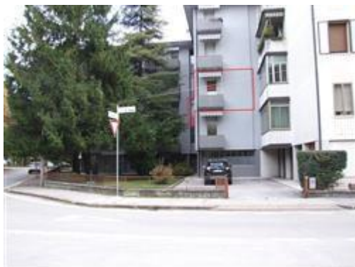
Accesso pedonale-carraio appartamento
