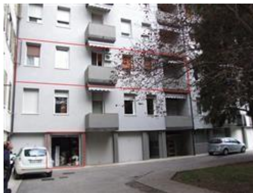
Veduta garage e appartamento da Est
