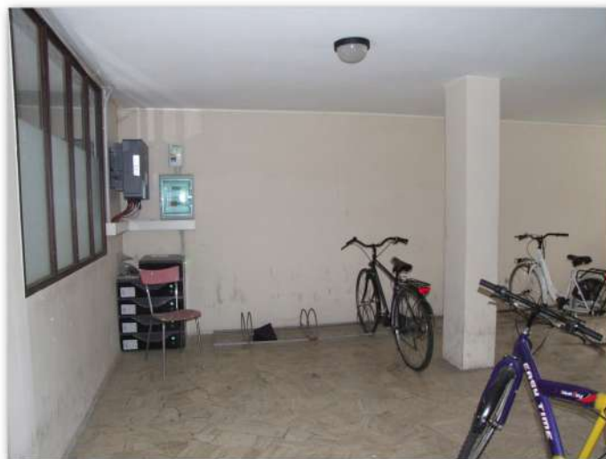
23. Locale di uso comune
