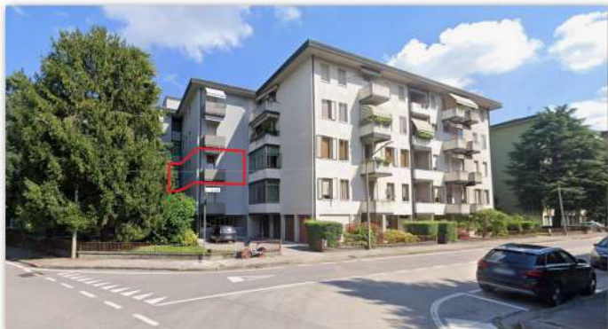
01. Veduta immobile da Sud
