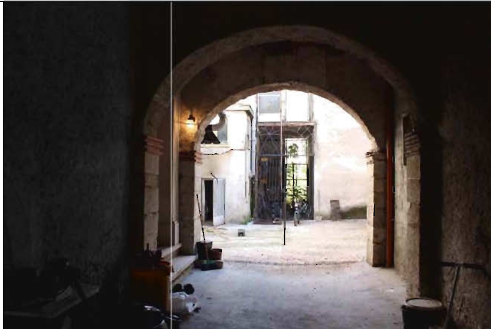
Foto n. 1_corte interna in comune
