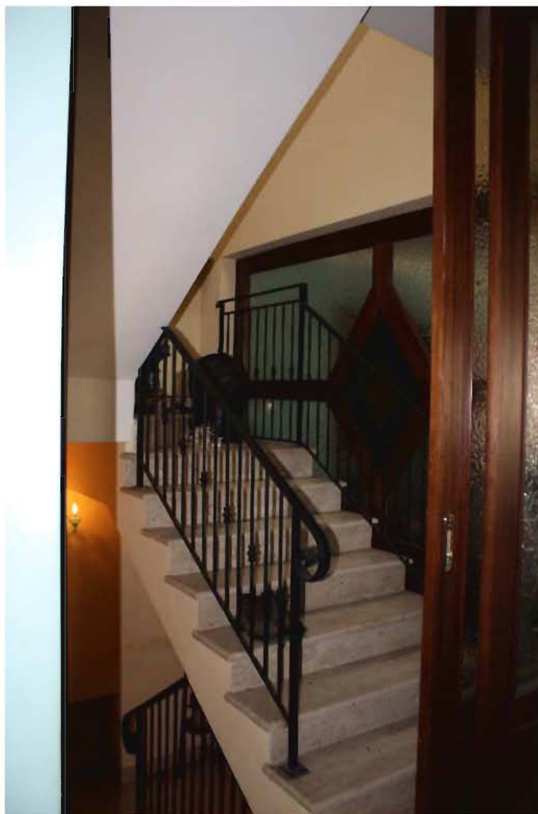
Foto n. 5 _scala di collegamento del piano abitativo con il sottotetto.
