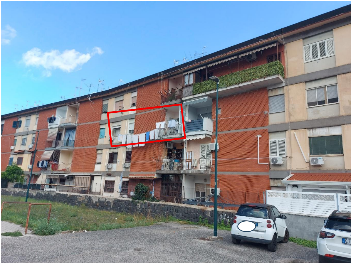
Prospetto su via della Maiella fabbricato 36 - affacci cespite
