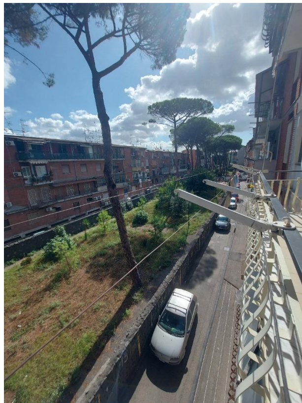
balcone BL1 affaccio su viale condominiale
