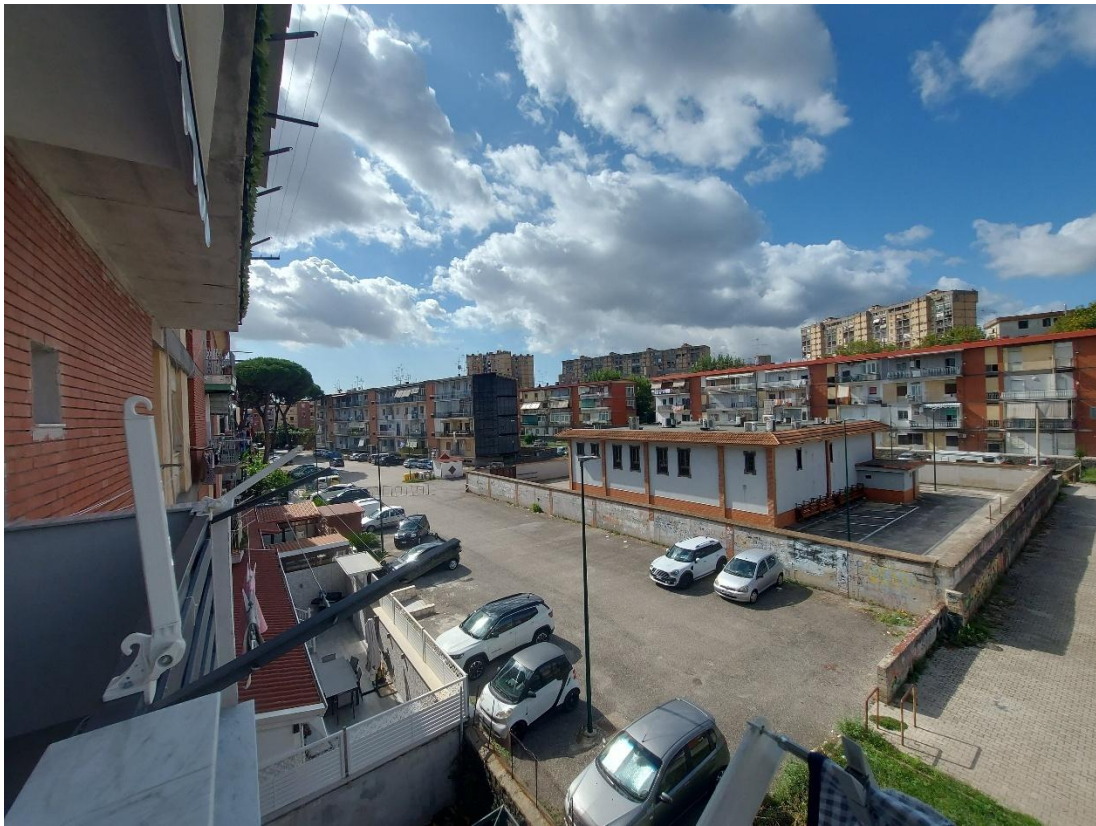
Balcone BL2 -affacci su via della Maiella
