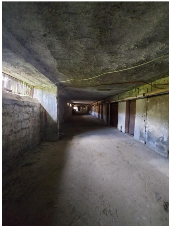
Piano seminterrato – corridoio comune
