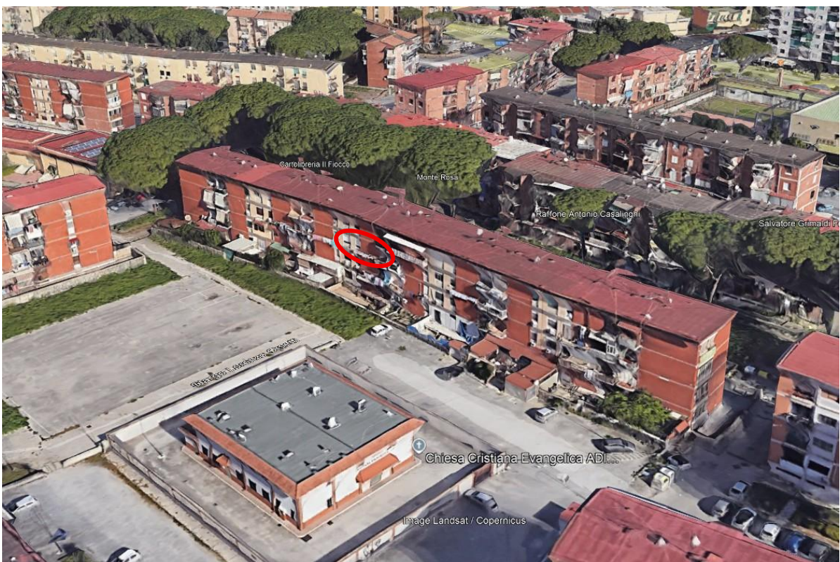
inquadramento territoriale - fabbricato 36 affacci cespite
