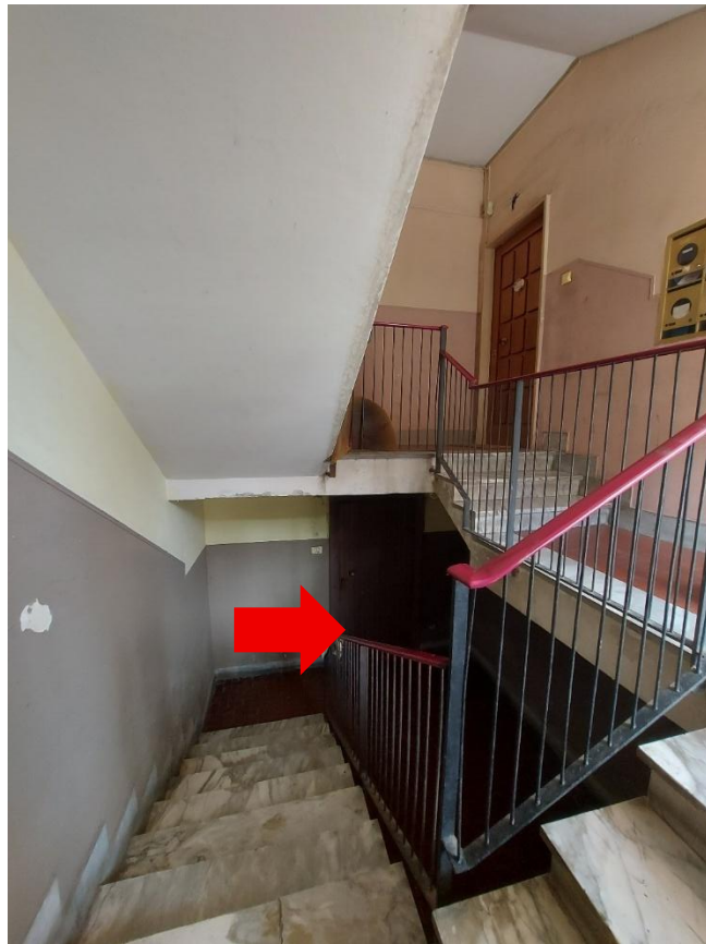
Piano terra scala 99 – cancello accesso ai locali cantinati del seminterrato
