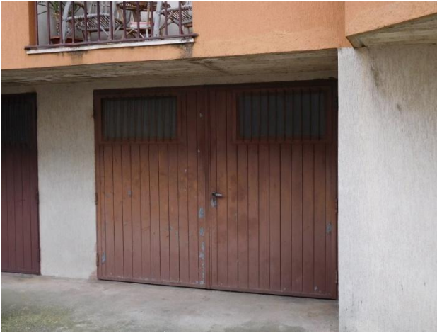
Foto 33 – vista da nord – accesso garage
