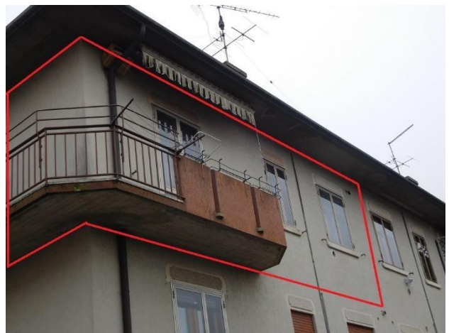
Foto 6 – vista da sud-est – particolare appartamento
