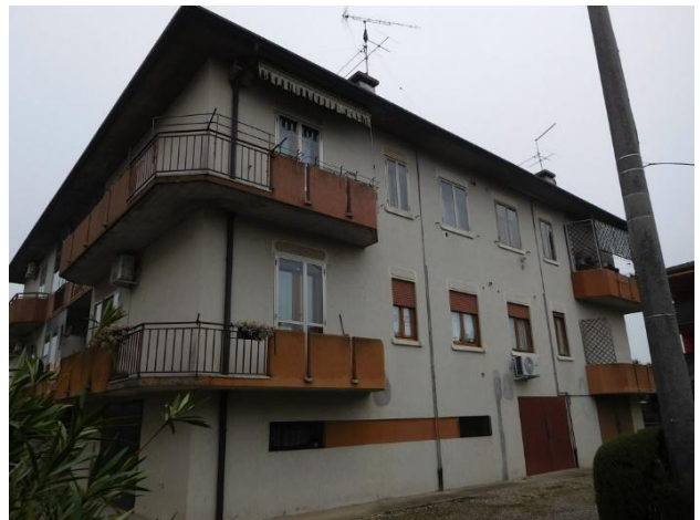
Foto 4 – vista da nord-ovest
