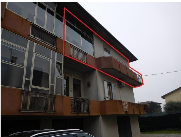
Foto 5 – vista da nord – particolare appartamento
