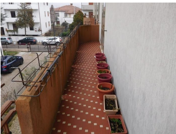
Foto 23 – piano secondo – appartamento – terrazza
