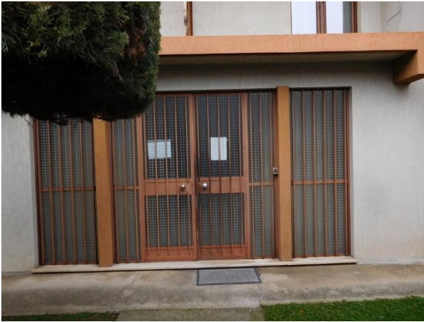
Foto 7 – vista da sud – particolare ingresso comune
