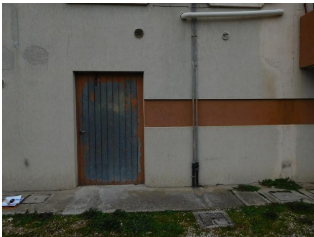
Foto 37 – vista da est – locale comune contatori
