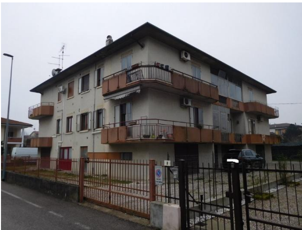
Foto 3 – vista da nord-est – da via Brescia
