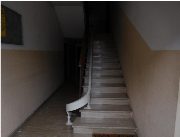
Foto 9 – vista ingresso comune piano terra
