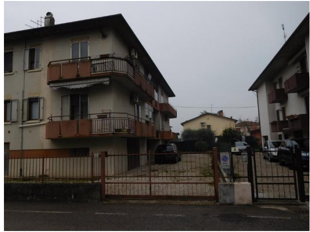
Foto 32 – da nord-est – accesso carraiato da via Brescia
