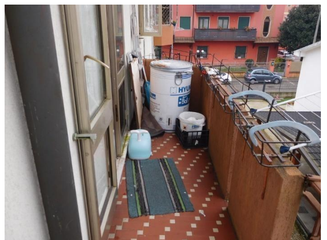
Foto 24 – piano secondo – appartamento – terrazza
